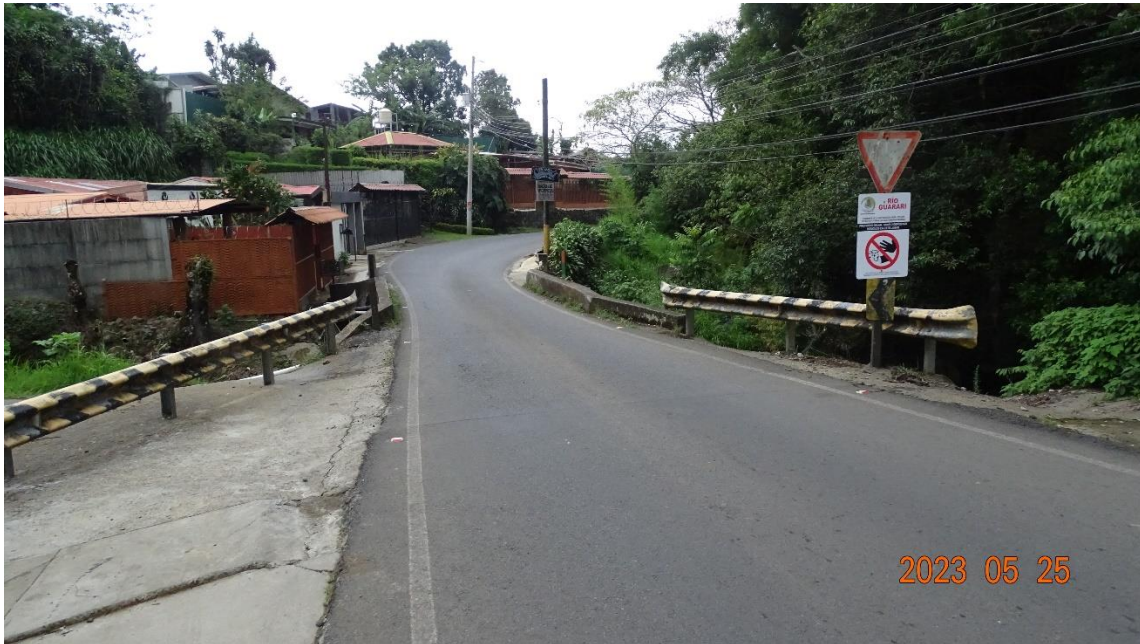
Figura 4.2. Vista a lo largo de la línea de centro del puente hacia El Roble
