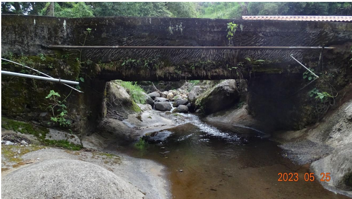
Figura 4.3. Vista lateral del costado aguas abajo del puente
