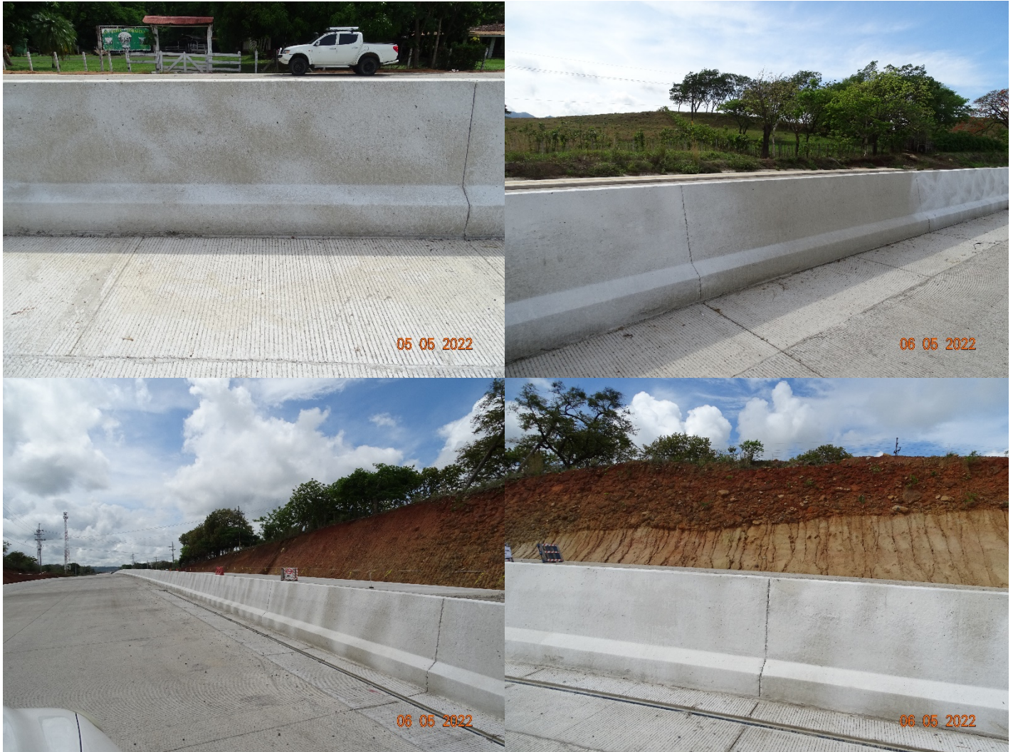
Figura 102. Manto de curado colocado sin cobertura total ni homogénea en algunas barreras construidas. Fecha de las fotografías: 05/05/2022
