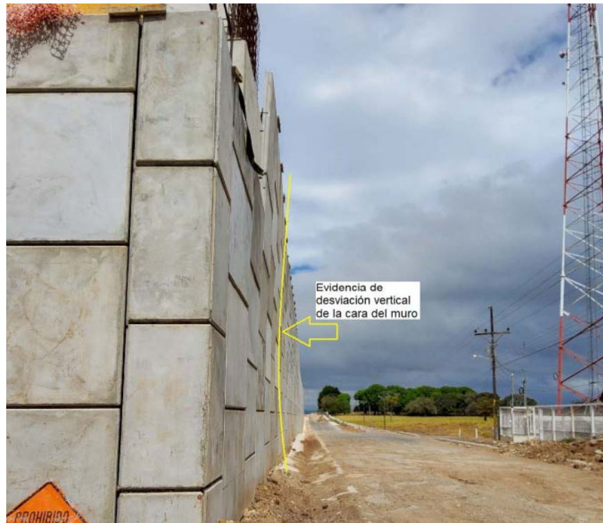
Figura 82. Inclínación vertical de las paredes del muro de relleno reforzado del paso a desnivel San Miguel. Fecha de la fotografía: 31/01/2022
