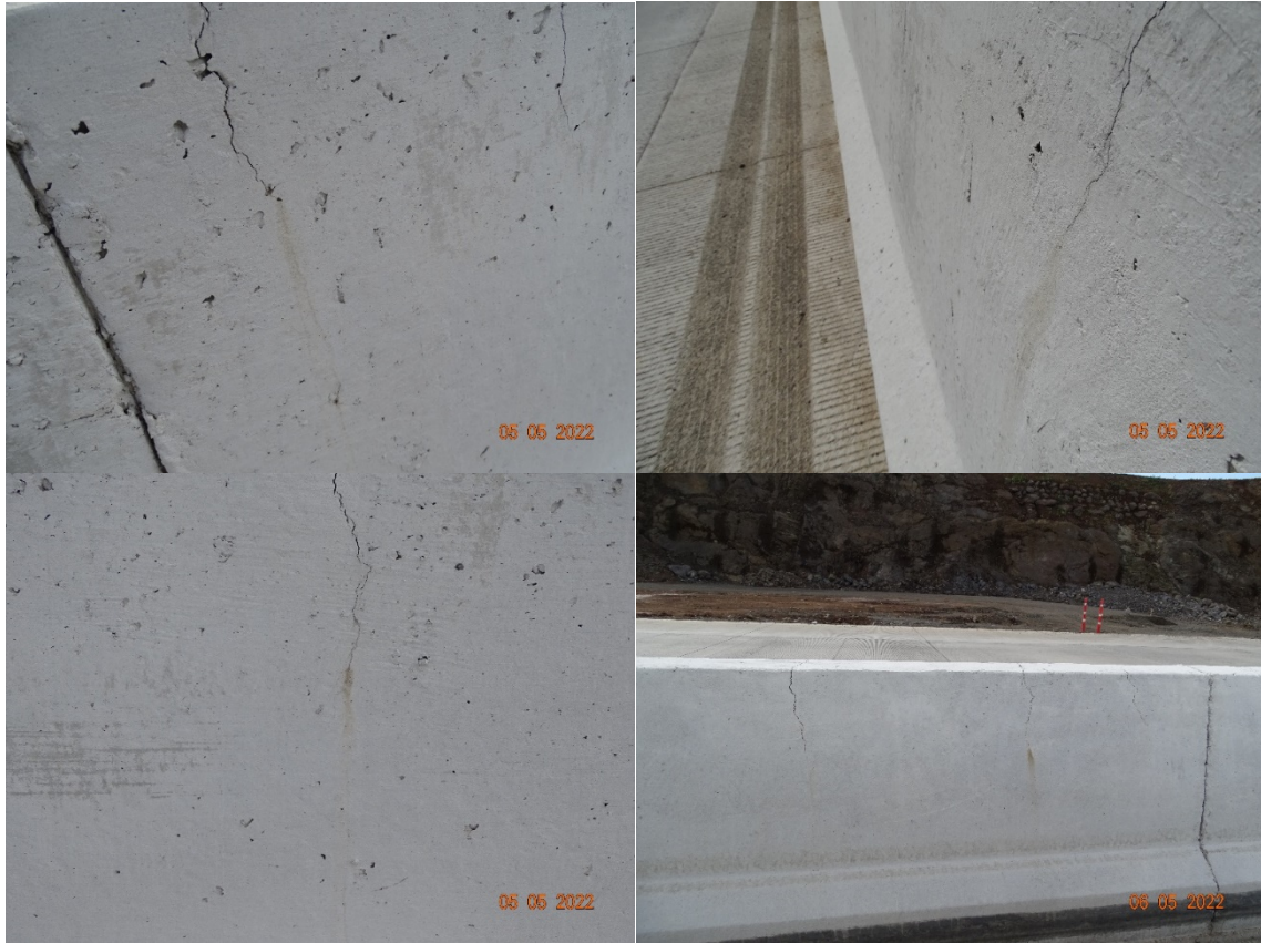
Figura 97. Deterioros en algunas barreras construidas. Fecha de las fotografías: 05/05/2022
