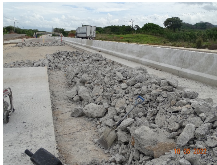
Figura 64. Demolición de losa de pavimento de concreto. Estacionamiento: 160+600, lado izquierdo. Fecha de la fotografía: 18/05/2022
