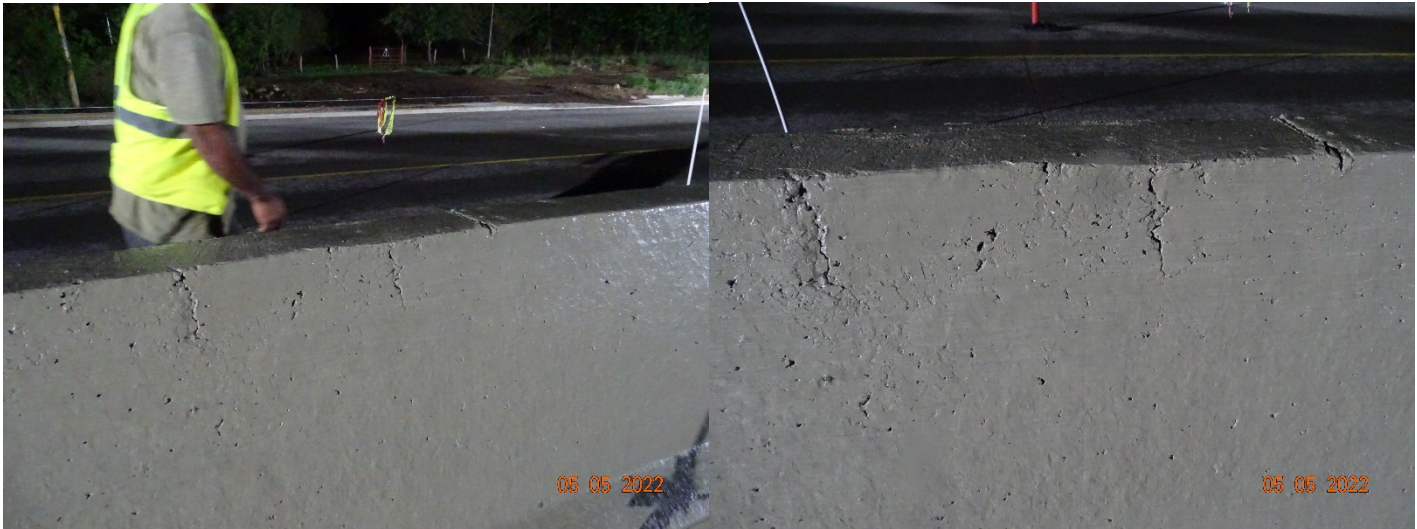
Figura 99. Reparación por vía manual de la altura de las barreras de contención construidas el 5 de mayo de 2022. Estacionamiento: 157+100
