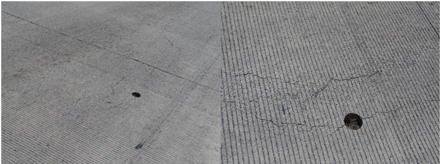
Figura 54. Desgaste, agrietamiento lineal y núcleo sin rellenar. Estacionamiento: 150+508, carril interno, lado izquierdo. Fecha de las fotografías: 19/04/2022
