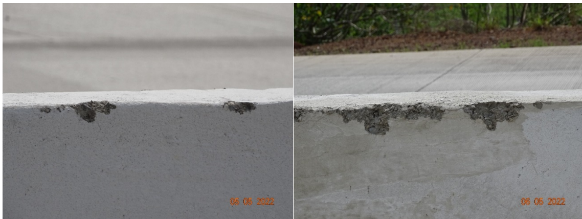
Figura 97. Deterioros en algunas barreras construidas. Fecha de las fotografías: 05/05/2022
