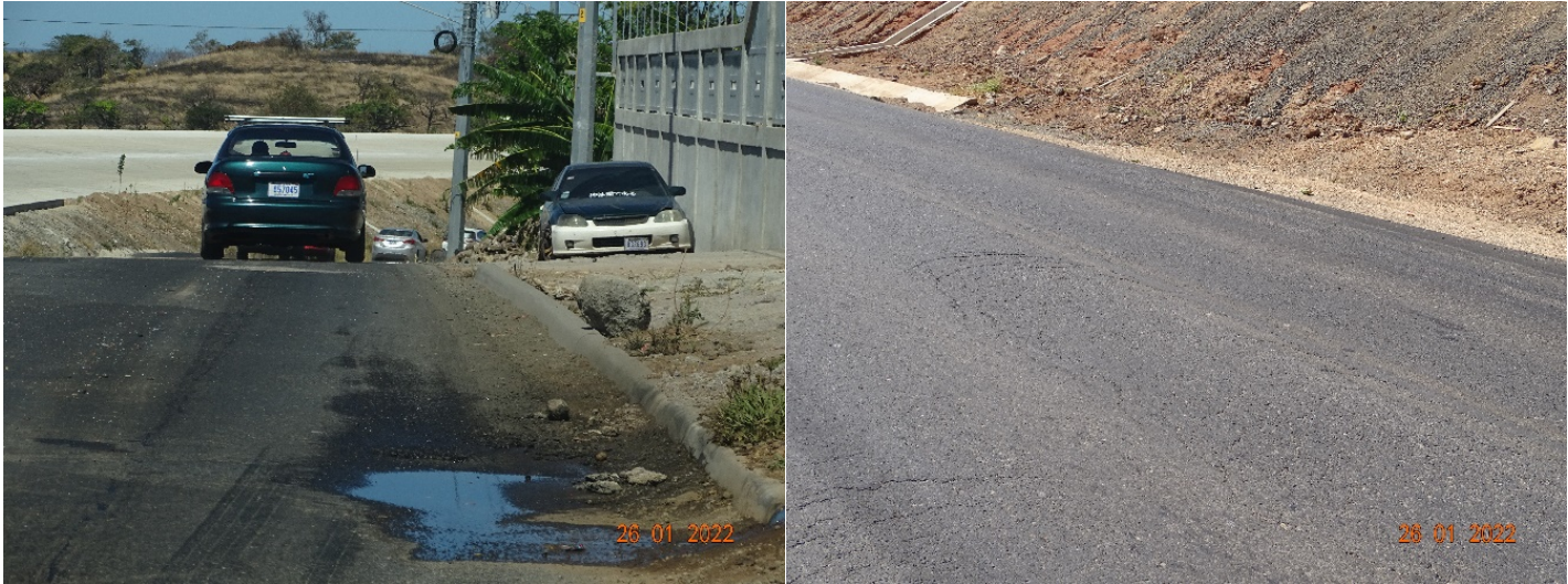
Figura 87. Deterioros presentes en la marginal 8 lado derecho del proyecto. Fecha de las fotografías: 28/01/2022
