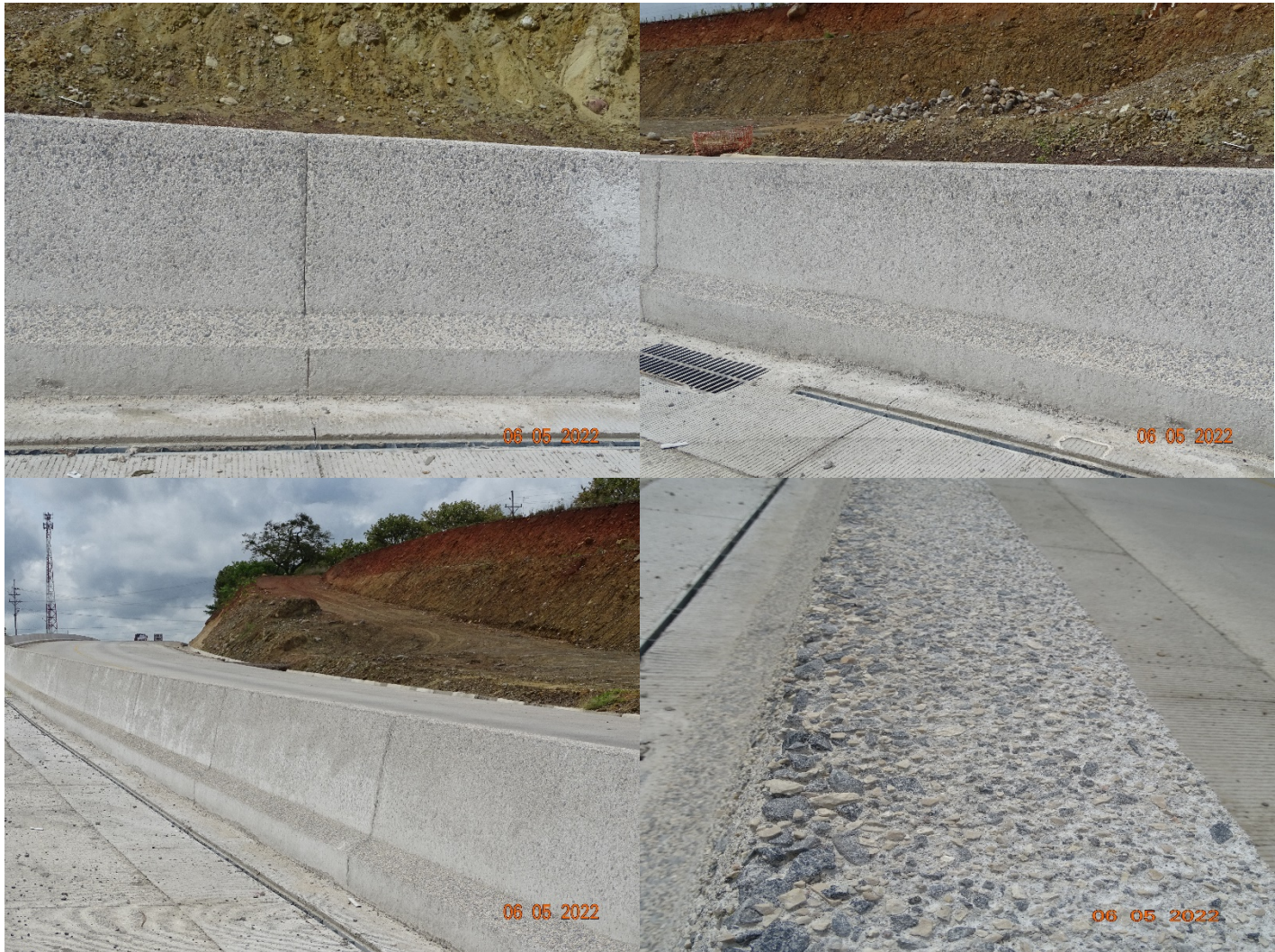
Figura 103. Barreras construidas en el estacionamiento 155+700 con aparente pérdida de pasta
