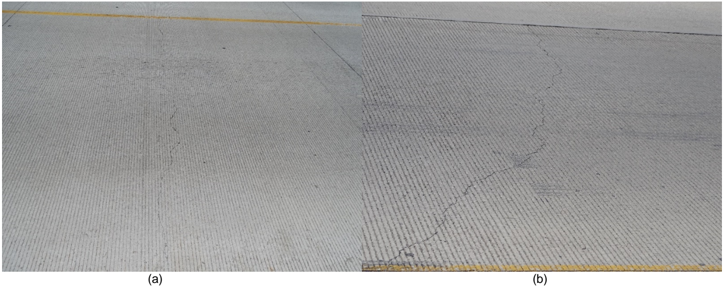
Figura 54. Desgaste, agrietamiento lineal y núcleo sin rellenar. Estacionamiento: 150+508, carril interno, lado izquierdo. Fecha de las fotografías: 19/04/2022
