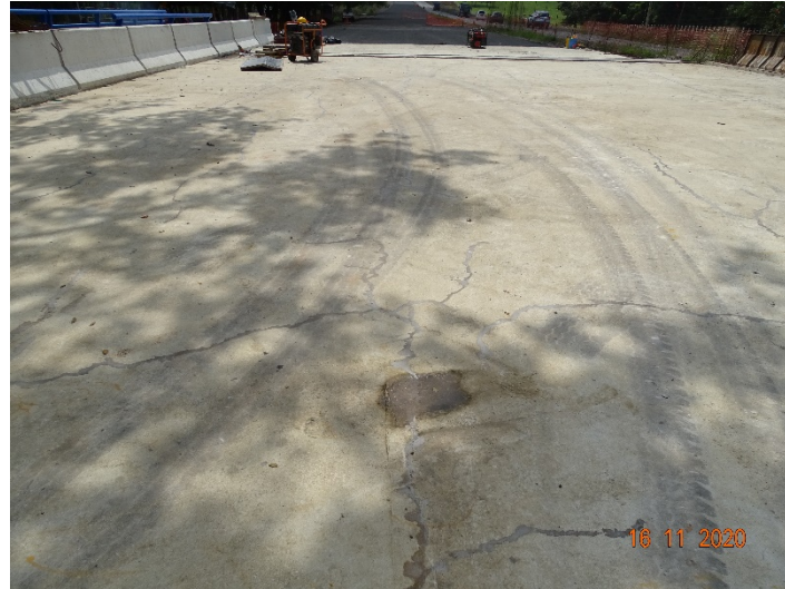
Figura 69. Sellado de los agrietamientos en el tablero del puente aguas arriba sobre el río Salitral. Fecha de la fotografía: 16/11/2020
