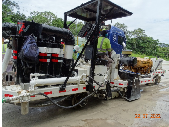
Figura 65. Cepillado del pavimento para corrección de la regularidad superficial. Estacionamiento: 148+300, lado derecho. Fecha de la fotografía: 22/07/2022
