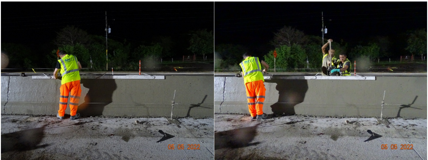
Figura 99. Reparación por vía manual de la altura de las barreras de contención construidas el 5 de mayo de 2022. Estacionamiento: 157+100
