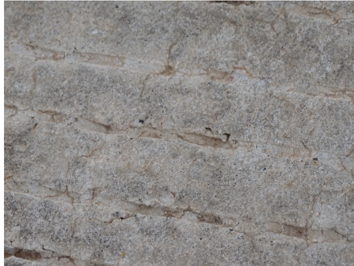
Figura 57. Agrietamiento por contracción. Estacionamiento: 149+800 – 149+828, carril interno y externo, lado derecho. Fecha de la fotografía: 19/04/2022
