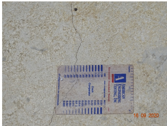
Figura 68. Agrietamientos en el tablero del puente aguas arriba sobre el río Salitral. Fecha de la fotografía: 19/09/2020
