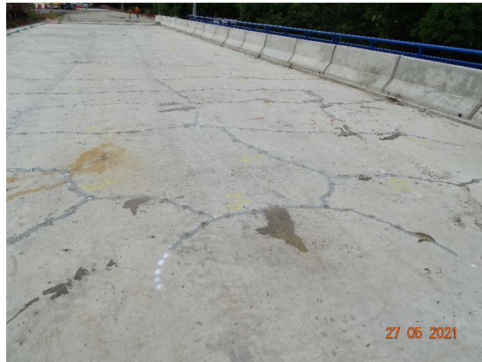
Figura 75. Agrietamientos en el tablero del puente aguas abajo sobre el río Javillos. Fecha de la fotografía: 27/05/2021
