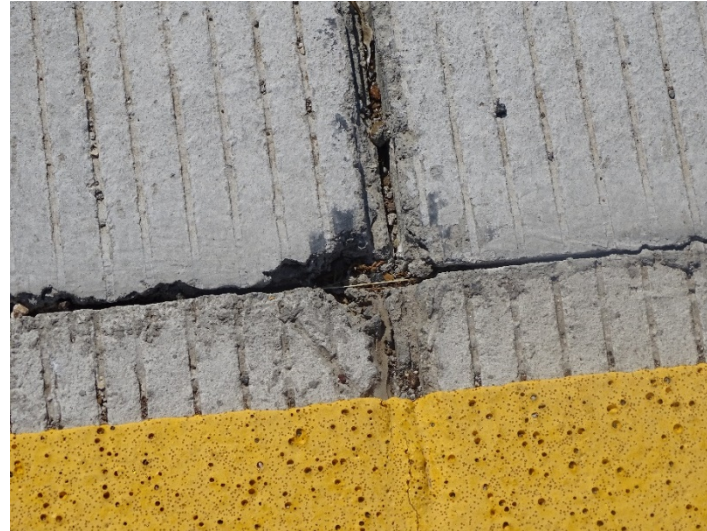
Figura 61. Fractura de esquina. Estacionamiento: 163+012, carril interno, lado izquierdo. Fecha de la fotografía: 19/04/2022
