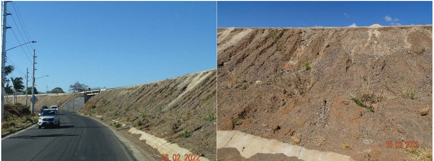
Figura 77. Erosión en los taludes del paso a desnivel Aserradero por falta de protección. Fecha de las fotografías: 25/02/2022
