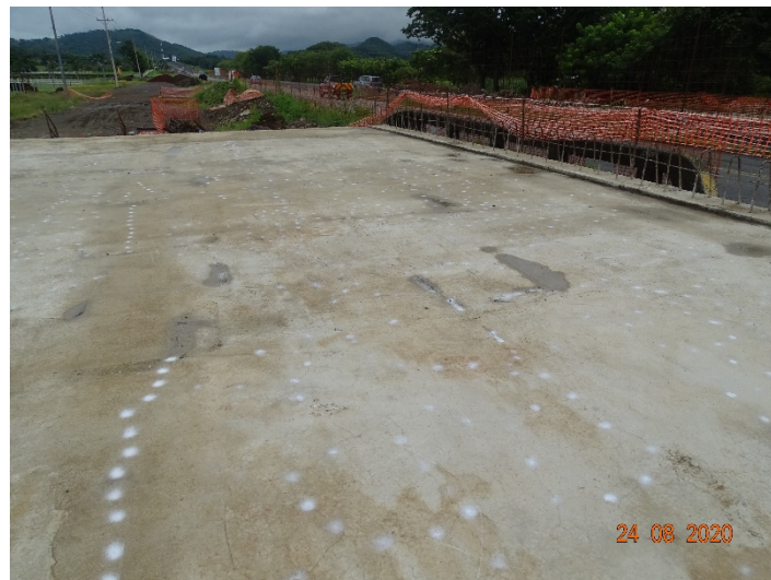
Figura 67. Sellado de los agrietamientos en el tablero del puente aguas abajo sobre el río Salitral. Fecha de la fotografía: 19/09/2020
