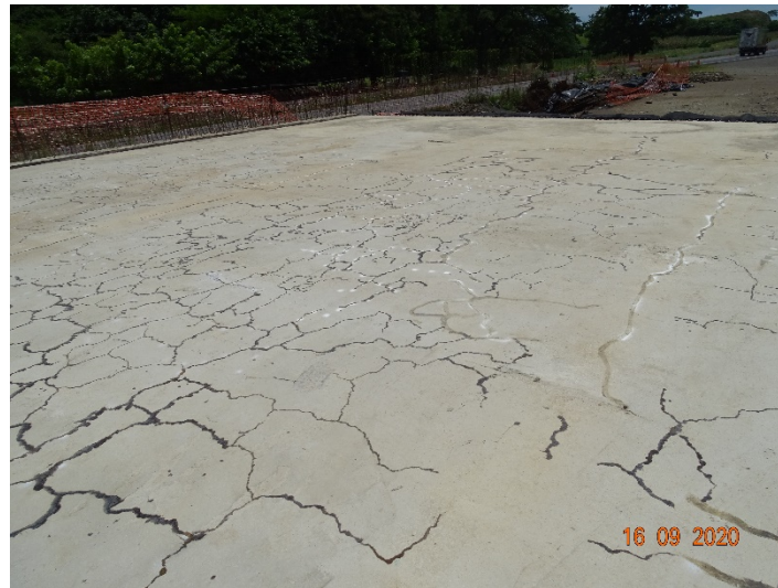
Figura 68. Agrietamientos en el tablero del puente aguas arriba sobre el río Salitral. Fecha de la fotografía: 19/09/2020
