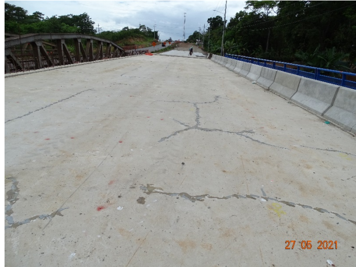
Figura 75. Agrietamientos en el tablero del puente aguas abajo sobre el río Javillos. Fecha de la fotografía: 27/05/2021
