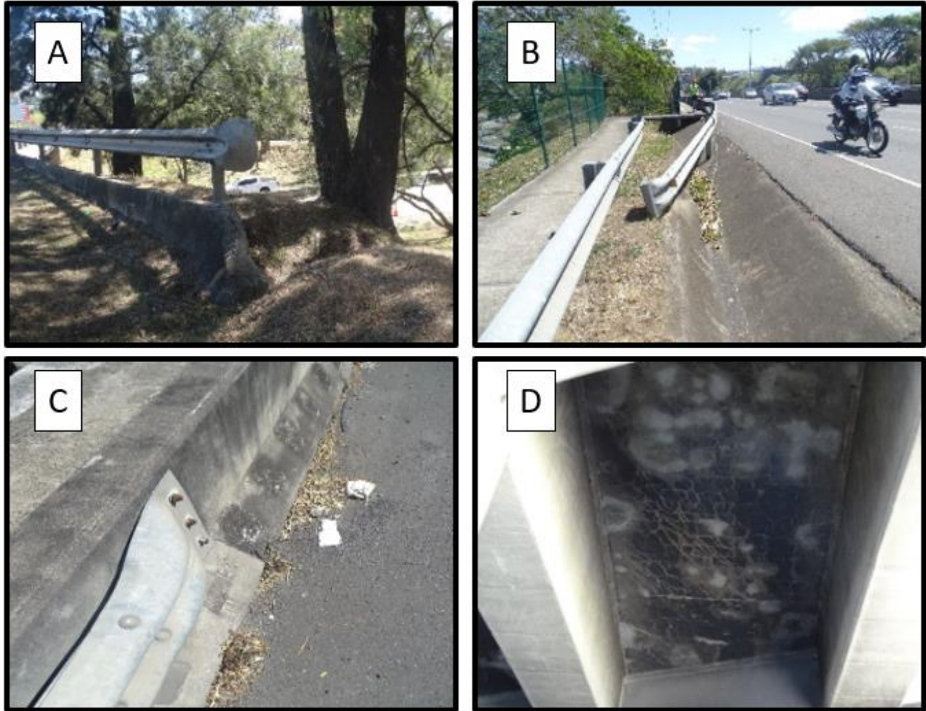
Figura 5.2. (A, B y C) Deficiencias en sistema de contención vehicular de los accesos, y (D) Deficiencias en tablero
