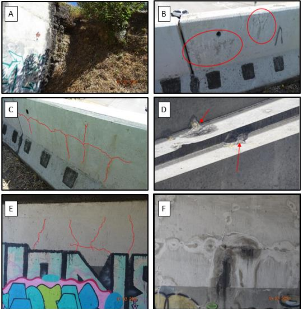
Figura 5.7. (A), Deficiencias en sistemas de drenaje de los accesos, (B y C) Deficiencias en elementos de seguridad vial, (D) Deficiencias en elementos principales de la superestructura, y (E y F) Deficiencias en subestructura
