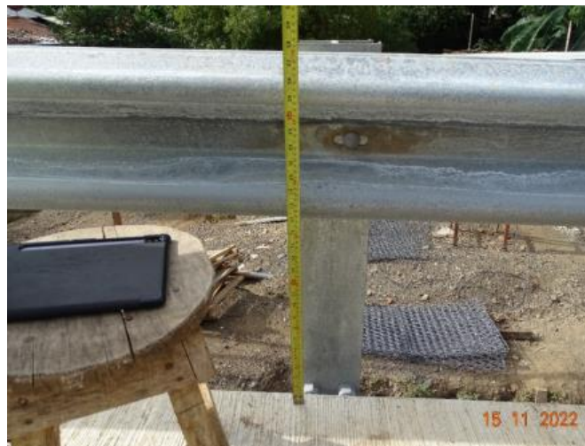
Figura 8. Altura de baranda flexible, puente sobre el río Esperanza. Fecha 15 de noviembre de 2022
