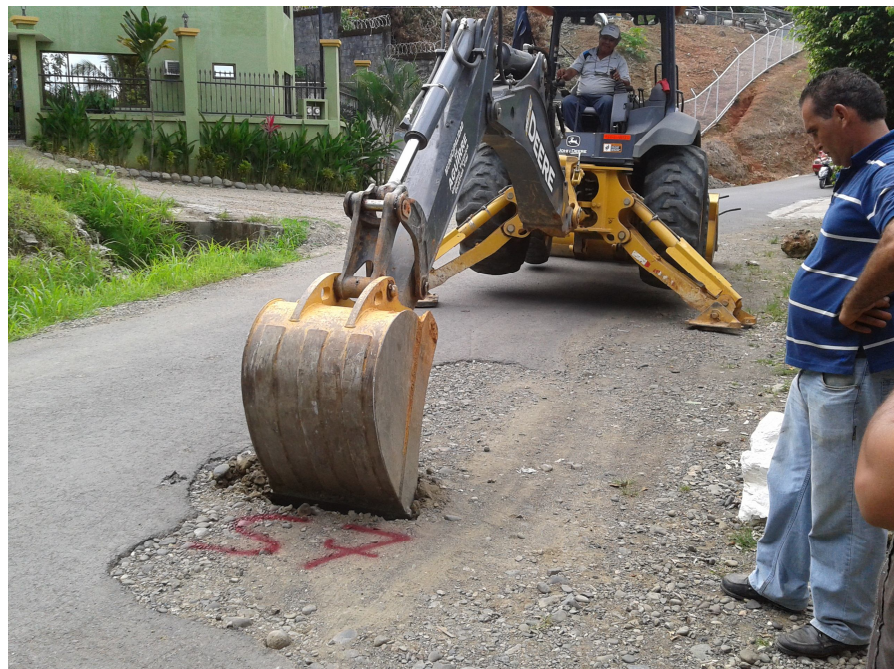
Figura 3. Proceso de excavación de los sondeos a cielo abierto.
