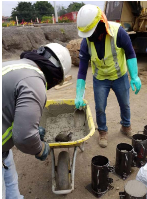
Figura 2. Uso de la misma muestra por los técnicos de ambos laboratorios. Proyecto: Diseño y Construcción de las Obras de ampliación Río Segundo. Fuente: LanammeUCR
