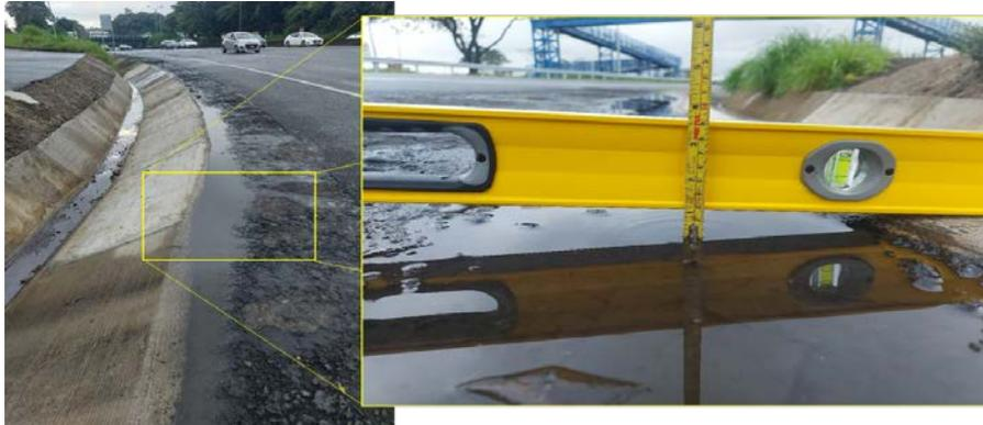
**Figura 45.** Falta de continuidad en el drenaje transversal por diferencia de nivel. Fecha: 23 de junio del 2022
