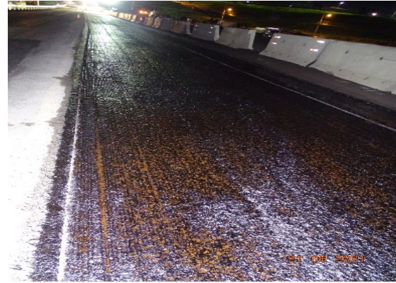
Figura 10. Riego de liga colocado en bache del carril interno. Fecha: 21 de junio de 2021, 11:32 p.m.
