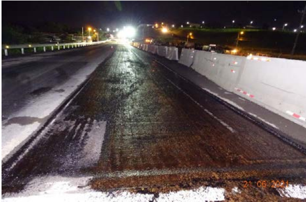
Figura 10. Riego de liga colocado en bache del carril interno. Fecha: 21 de junio de 2021, 11:32 p.m.
