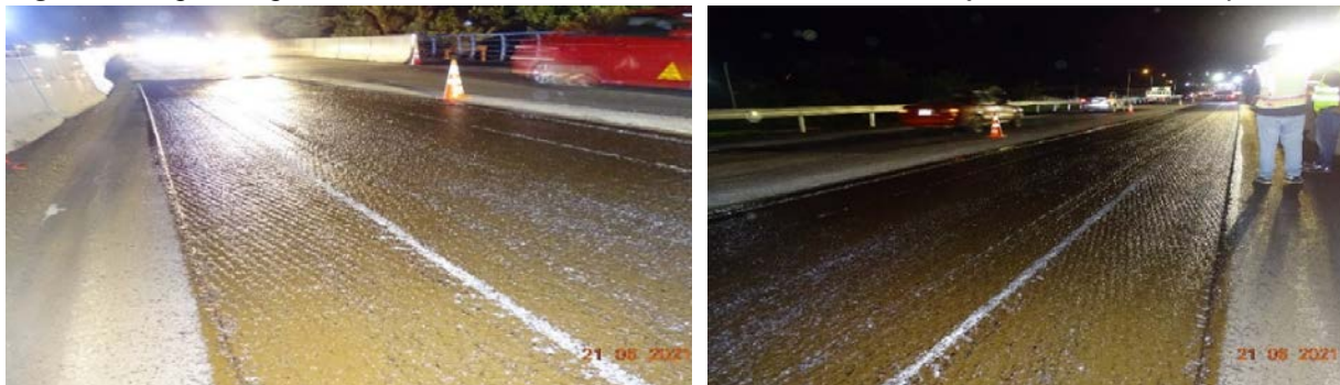
Figura 9 Riego de liga colocado en bache del carril interno. Fecha: 21 de junio de 2021, 9:25 p.m.
