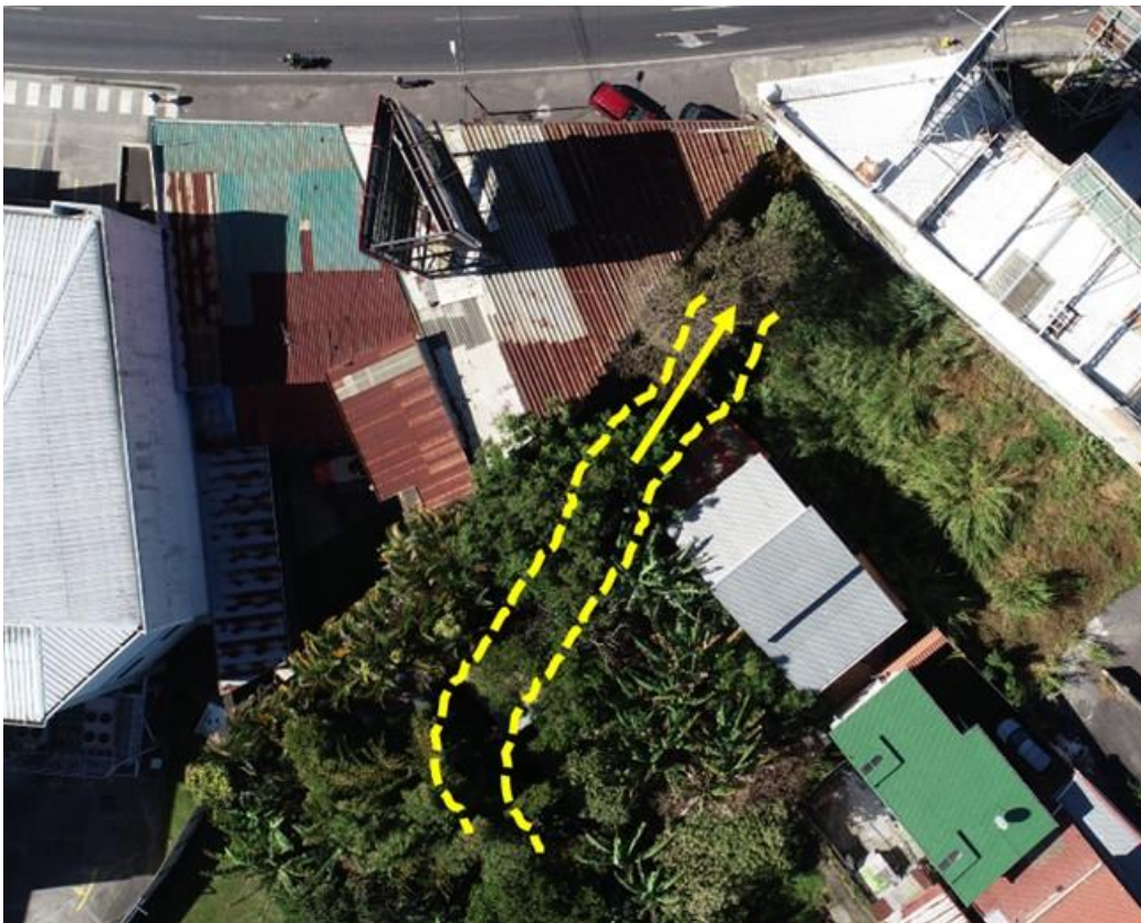
Figura 5. Vista aérea de la zona de entrada de la alcantarilla que atraviesa la Ruta Nacional No.2.
