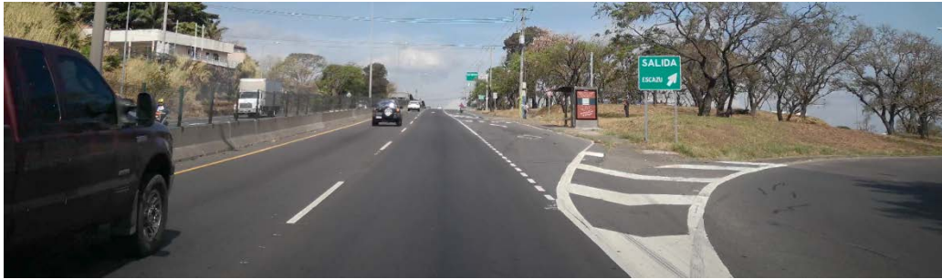
Figura 89. Bahía de autobús sobre vía principal tipo autopista
