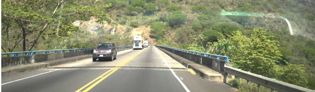
Figura 105. Conexión barrera semirrígida con pretil de puente y presencia de vehículos pesados
