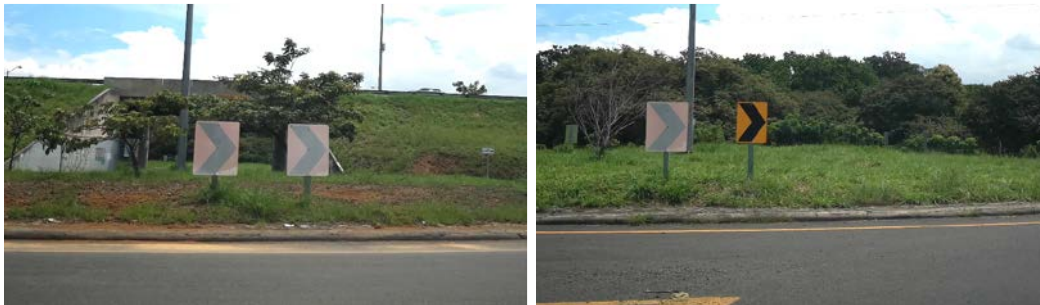
Figura 112. Señalamiento vertical deteriorado
