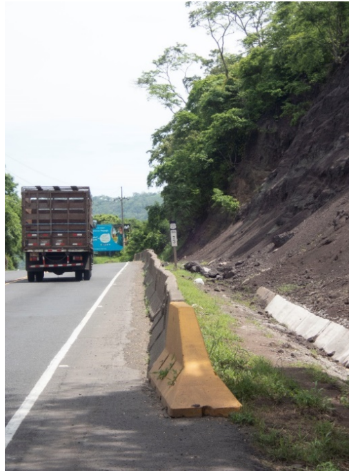
Figura 85. PK 73 +000. Barrera de concreto colocada al pie del talud a modo de barrera de control de caídos.
