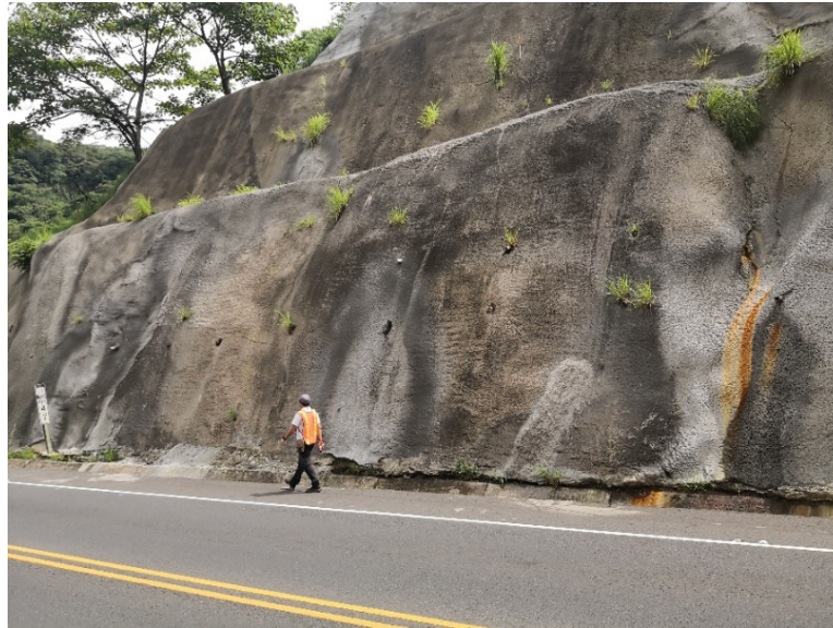
Figura 79. PK 47+000 Vista general de la condición actual del talud
