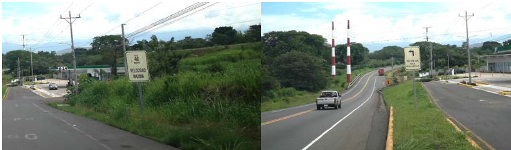
Figura 108. Señalamiento vertical deteriorado
