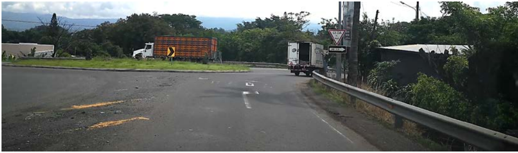
Figura 107. Demarcación horizontal borrosa y ausencia de captaluces
