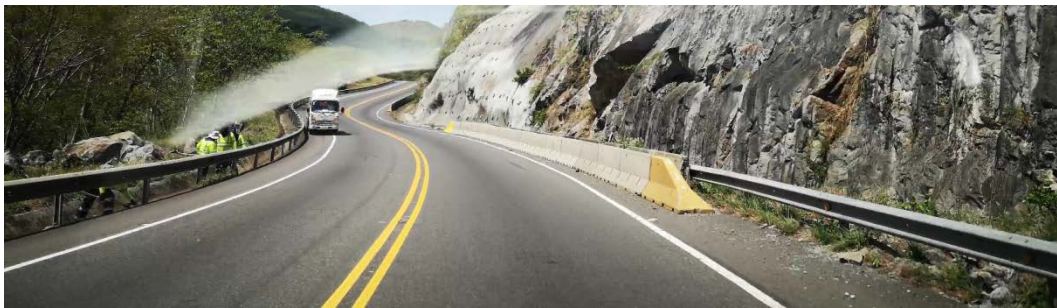
Figura 106. Sistemas de contención vehicular de concreto
