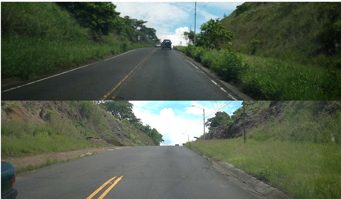
Figura 114. Demarcación horizontal borrosa y ausencia de captaluces
