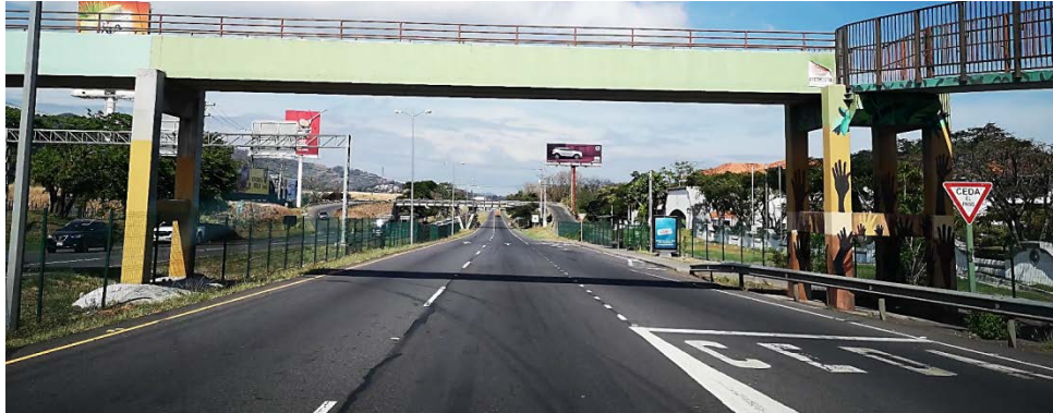
Figura 96. Puente peatonal, bahía de autobús y carril de aceleración
