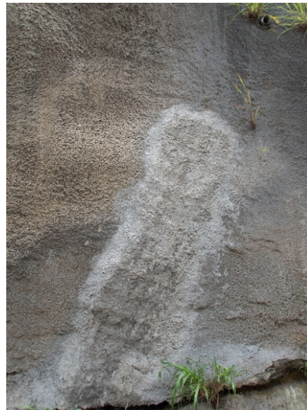
Figura 82. Sección intervenida recientemente, se sustituyó una parte del concreto lanzado en el talud
