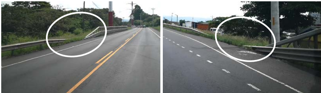
Figura 110. Discontinuidades en sistemas de contención vehicular
