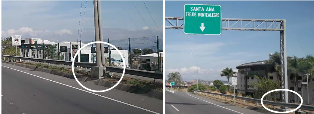
Figura 91. Discontinuidades en sistemas de contención vehicular
