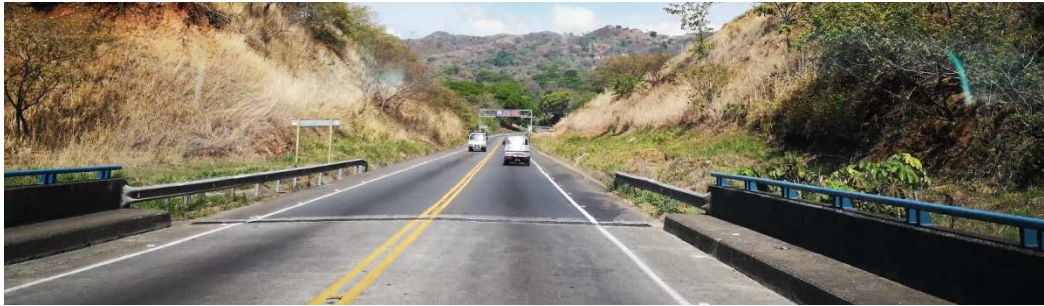
Figura 98. Conexión barrera semirrígida con pretil de puente
