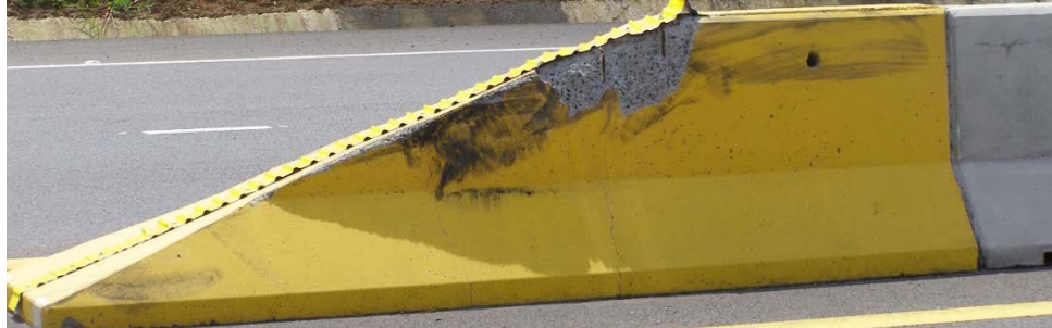
Figura 100. Terminal de concreto en mediana
