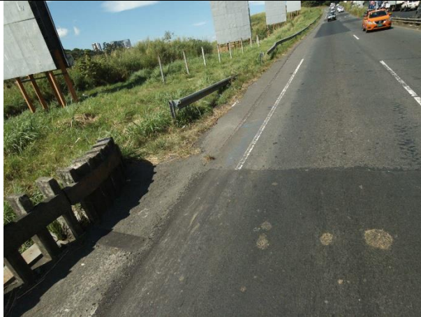
Sistema semirrígido de contención con impactos estacionamiento 1+530 (Puente Río Torres)
