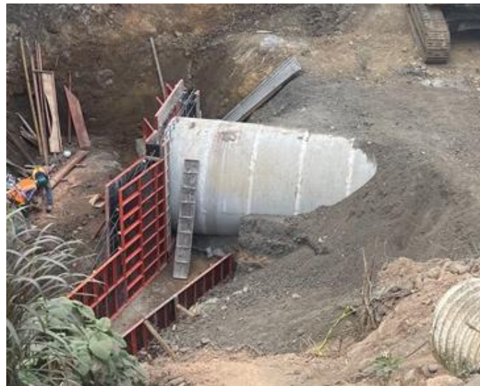
Figura 8. Cabezal en construcción aguas arriba, Punto 3 Ruta Nacional 1. Se aprecian parte de los trabajos que se desarrollaban en la entrada de la alcantarilla al momento de la evaluación
