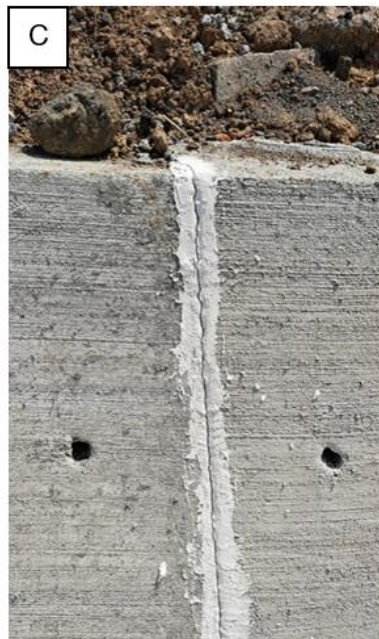
Figura 6. Cuneta de concreto al costado del relleno. A) Vista aérea del relleno y la cuneta de concreto. B) Vista al nivel de la cuneta. C y D) Separaciones milimétricas entre los paños de concreto de la cuneta, algunas de estas uniones presentan reparaciones recientes, sin embargo, la separación entre algunos segmentos de cuneta es apreciable actualmente
