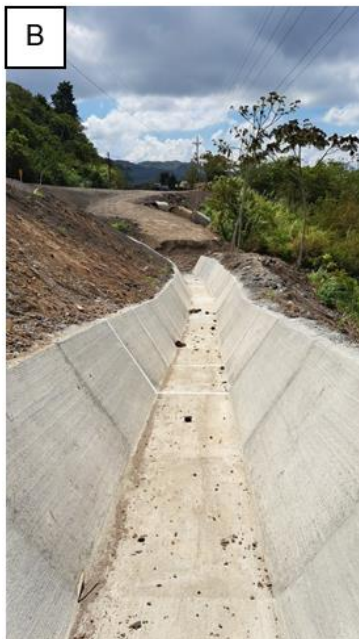
Figura 6. Cuneta de concreto al costado del relleno. A) Vista aérea del relleno y la cuneta de concreto. B) Vista al nivel de la cuneta. C y D) Separaciones milimétricas entre los paños de concreto de la cuneta, algunas de estas uniones presentan reparaciones recientes, sin embargo, la separación entre algunos segmentos de cuneta es apreciable actualmente
