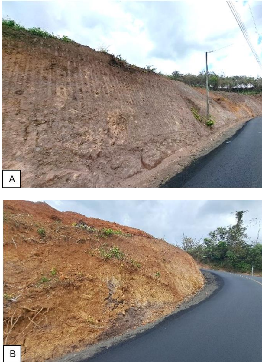
Figura 19. Condición observada en varios taludes de la Ruta Cantonal alterna. A) Talud del Punto RA-1: En general se observa una consistencia firme del material del talud, incluso todavía se pueden observar las marcas de la maquinaria empleada para el corte del talud. B) Talud en el Punto RA-2: Comparativamente la consistencia del material es más blanda y suelta que en el Punto RA-1, se presenta más como suelo y no como roca, y hay evidencia de material orgánico
