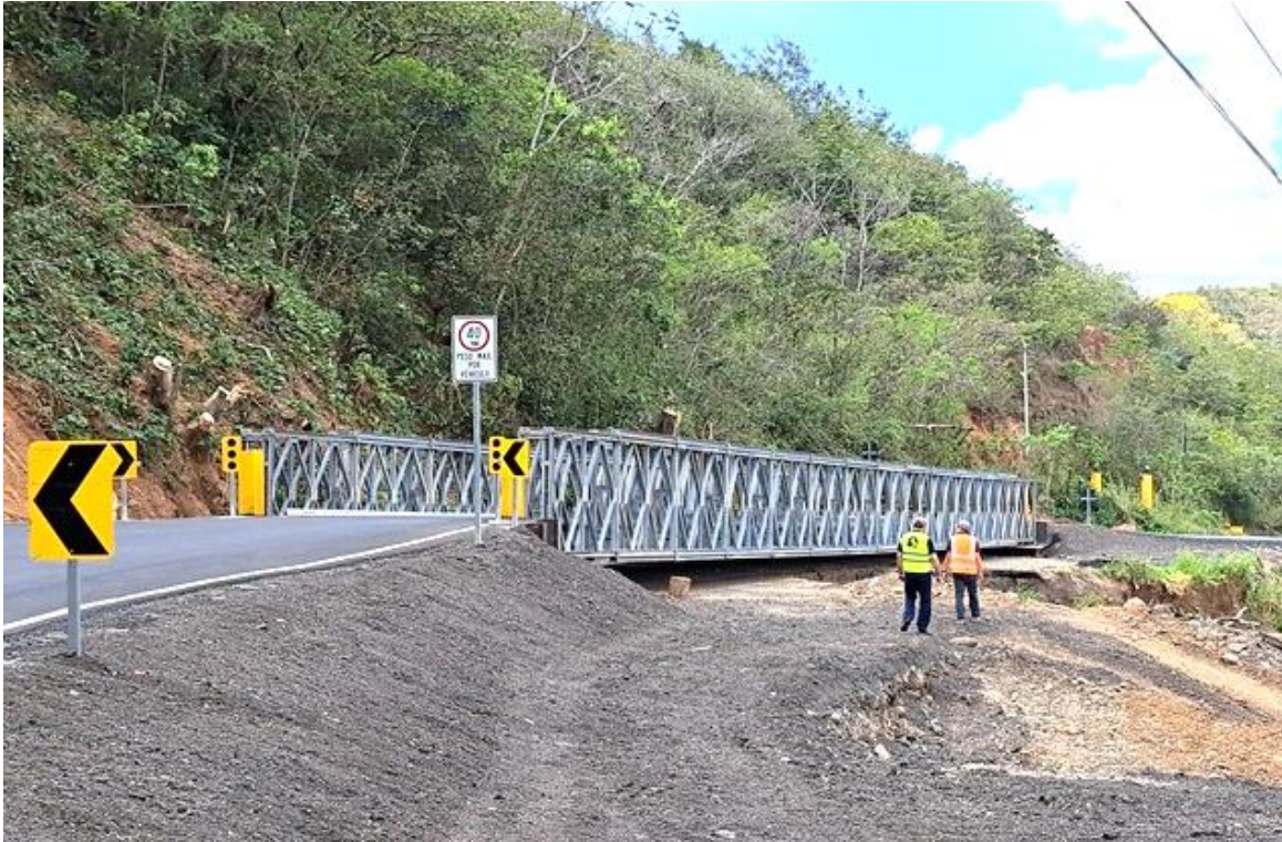
Figura 11. Puente Bailey instalado en el Punto 4 de la Ruta Nacional No.1. Condición observada el día 18/01/2023.
