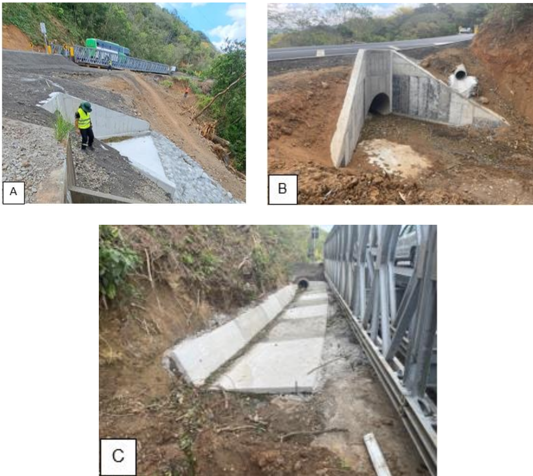
Figura 13. Obras de drenaje recientemente construidas en el Punto 4, Ruta Nacional No.1. A) y B) Salida y entrada de la alcantarilla respectivamente. C) Cuneta de concreto al costado del puente Bailey
