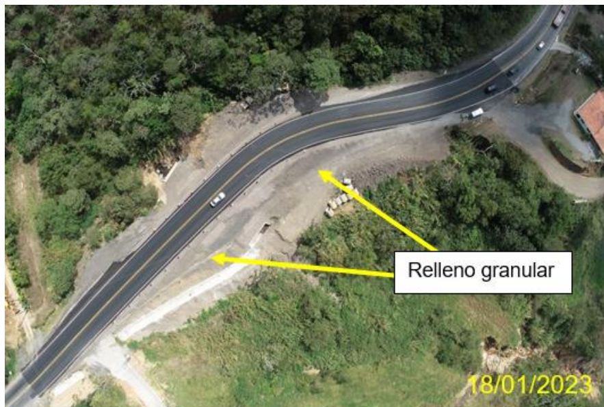
Figura 5. Vistas aéreas para la comparación de la condición del Punto 2, entre octubre del 2022 y enero del 2023. Se observa el relleno construido en la zona que ha presentado grietas y hundimientos, debido a la inestabilidad del terreno
