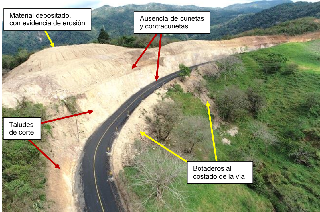
Figura 22. Punto RA-4 de la ruta alterna. Localizado a 3 km desde el cruce en Piedra Blanca con la Ruta Nacional No.1. Se observan parte de los impactos generados en la zona. Se identificaron materiales depositados al costado de la vía, sin evidencia de procesos adecuados de compactación, controles de erosión y retención de sedimentos
