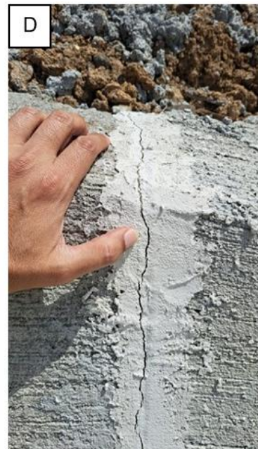
Figura 6. Cuneta de concreto al costado del relleno. A) Vista aérea del relleno y la cuneta de concreto. B) Vista al nivel de la cuneta. C y D) Separaciones milimétricas entre los paños de concreto de la cuneta, algunas de estas uniones presentan reparaciones recientes, sin embargo, la separación entre algunos segmentos de cuneta es apreciable actualmente
