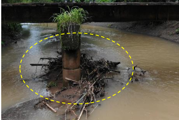
Socavación local en pila central
