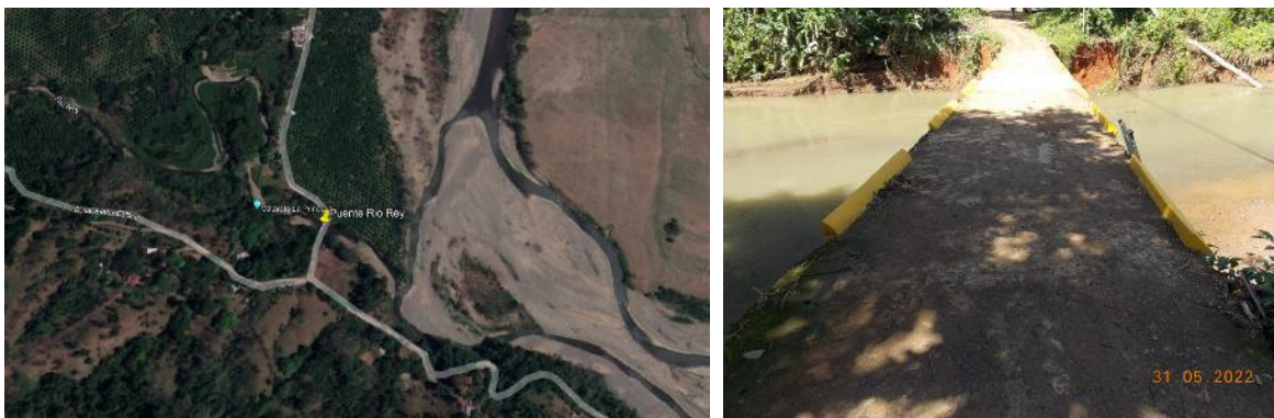
Figura 3: Ubicación del puente Rio Rey y vista general.
