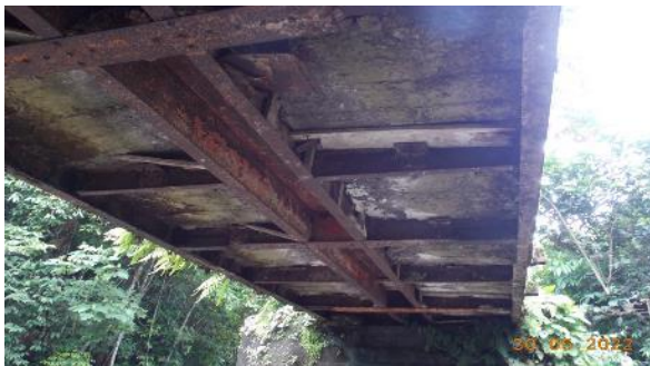
Deterioro de losa
