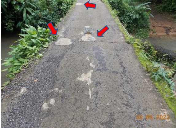
Deterioro de losa
