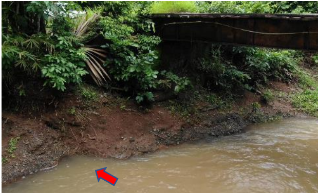
Socavación local en pila central
