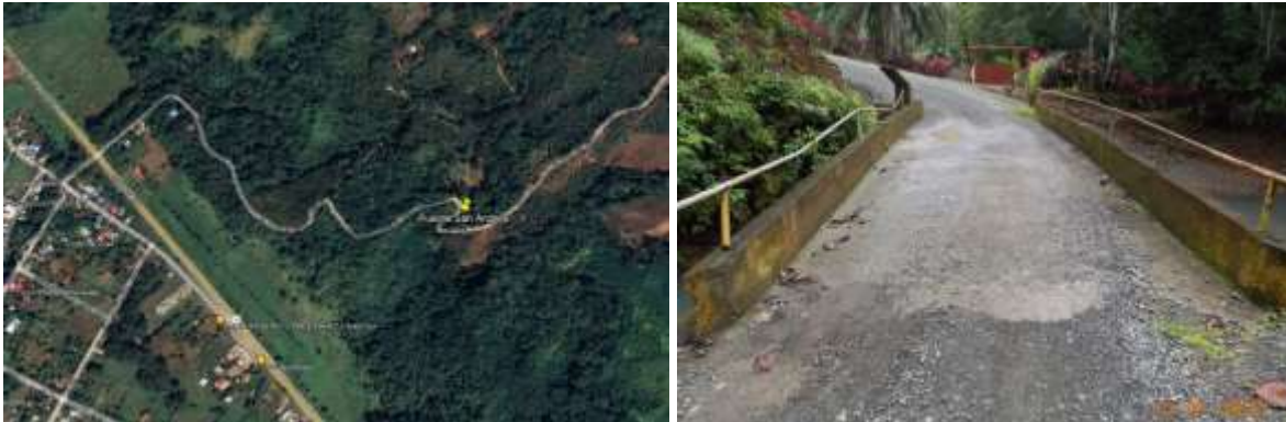
Figura 4: Ubicación de puente San Andrés y vista general. Fuente: Google Earth y LanammeUCR
