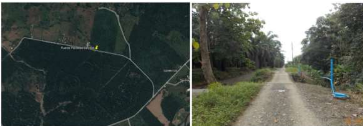
Figura 1: Ubicación del puente Cerritos y vista general.
