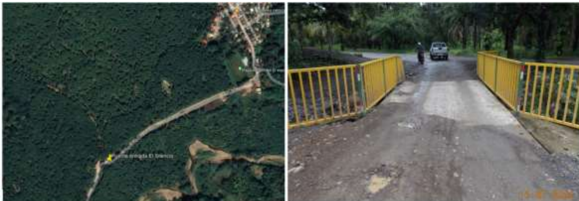
Figura 3: Ubicación de alcantarilla en entrada hacia El Silencio y vista general.
