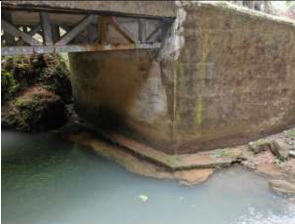
Socavación en bastión de margen izquierda y pila central
