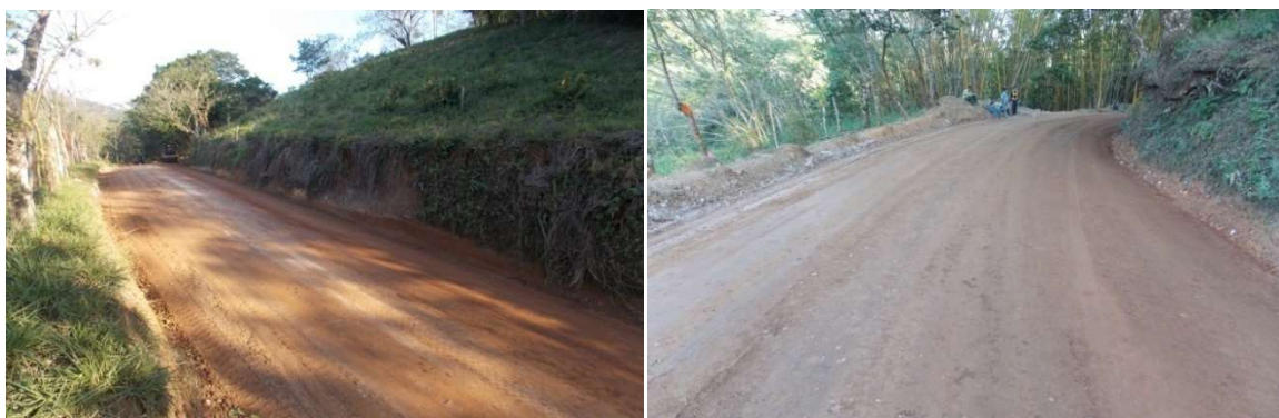
Figura 36. Acabado final del Tramo 6 _CAL HIDRATADA
