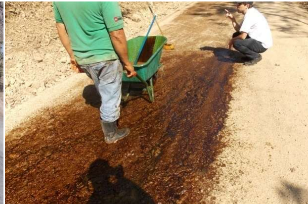
Figura 13. Aplicación de melaza para control de polvo
