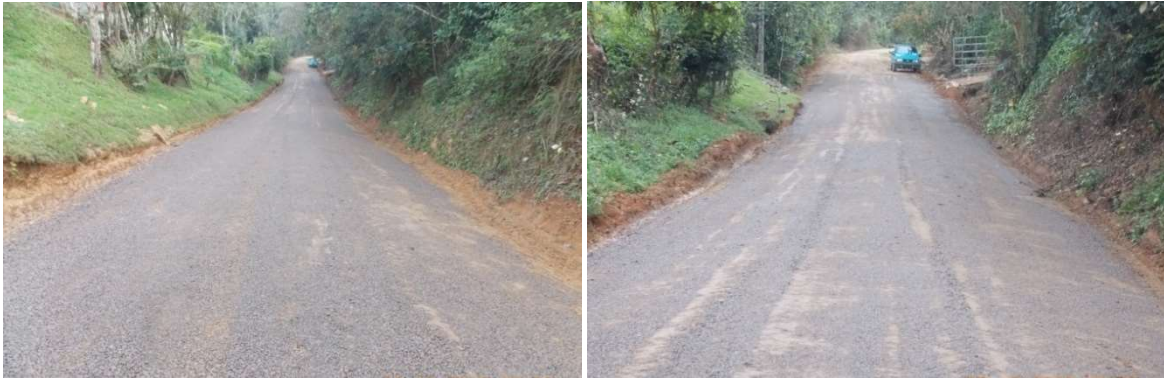
Figura 25. Acabado final del Tramo 3_IÓNICO II
