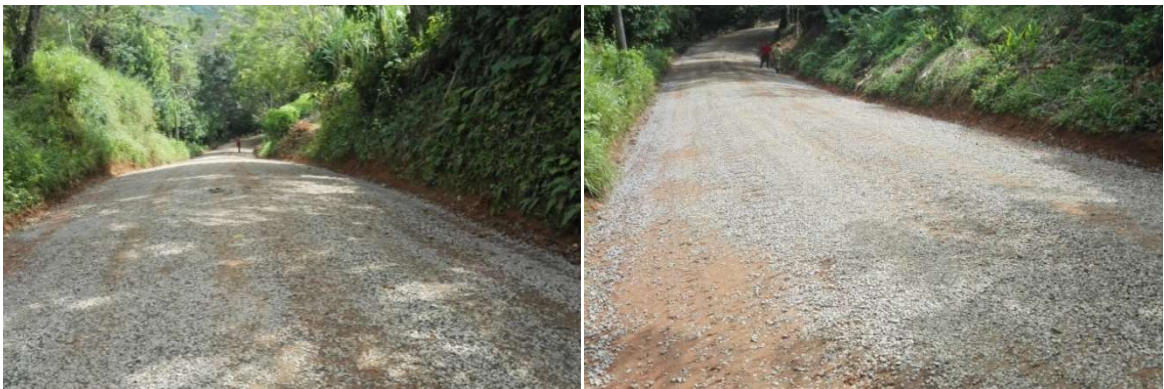
Figura 26. Acabado final del Tramo 4_IÓNICO II
