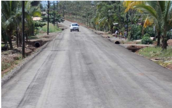
Sello asfáltico anti-erosión, San Carlos, Alajuela
