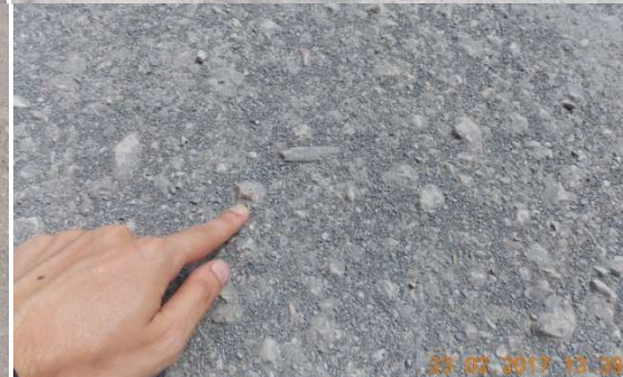
Figura 12. Sellos asfálticos para control de polvo en caminos no pavimentados
