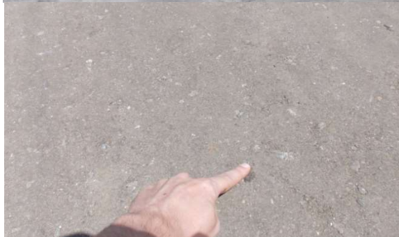
Figura 12. Sellos asfálticos para control de polvo en caminos no pavimentados
