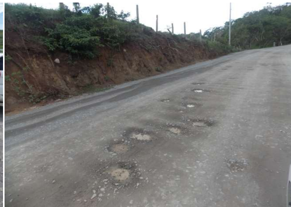
Figura 9. Algunos de los deterioros típicos de caminos no pavimentados en Costa Rica
