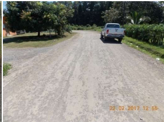
Base mejorada con cemento RN. 163, Jicaral, Puntarenas
