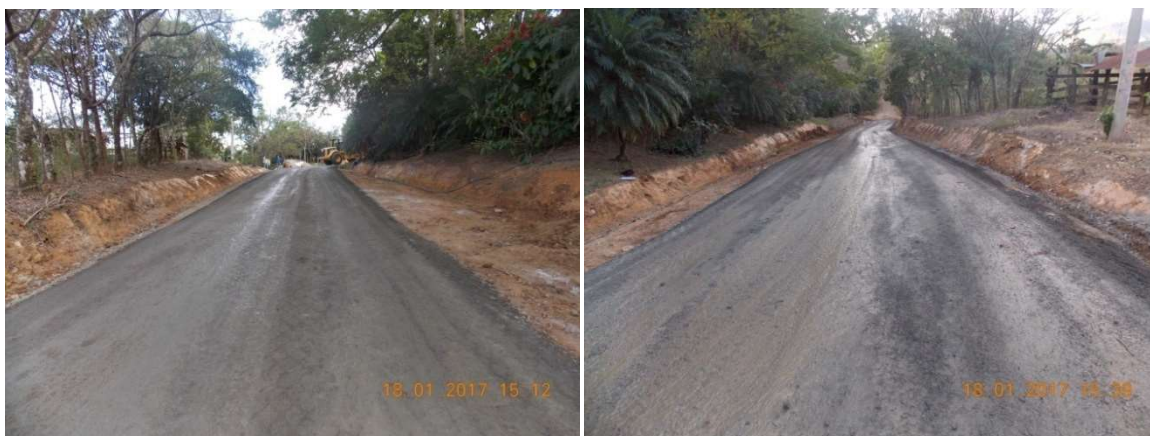
Figura 21. Acabado final del Tramo 2_CEMENTO
