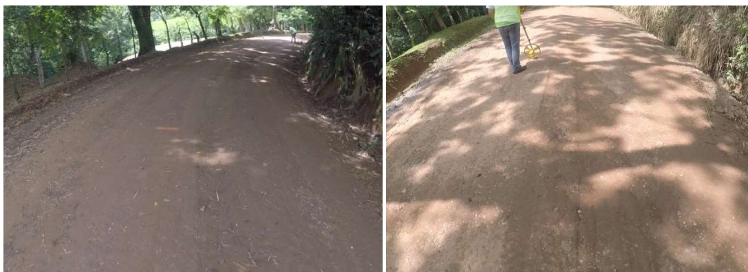
Figura 32. Acabado final del Tramo 5_POLÍMERO-IO
