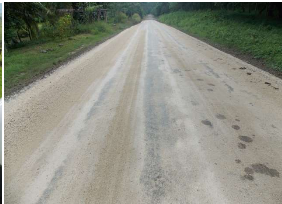
Figura 10. Estabilización con cemento en caminos no pavimentados
