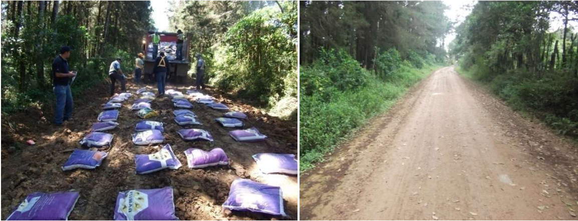
Figura 11. Tramos de prueba con suelo estabilizado con cal, Cartago
