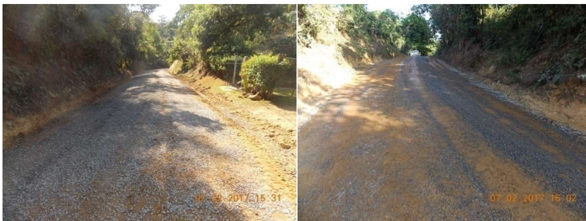
Figura 17. Acabado final del Tramo 1_IÓNICO I
