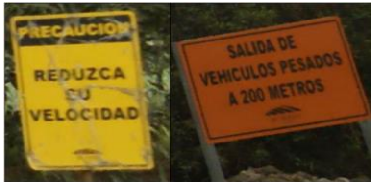
Figura 7. Categoría de señalización en mal estado o no oficial (Nota = 33)
