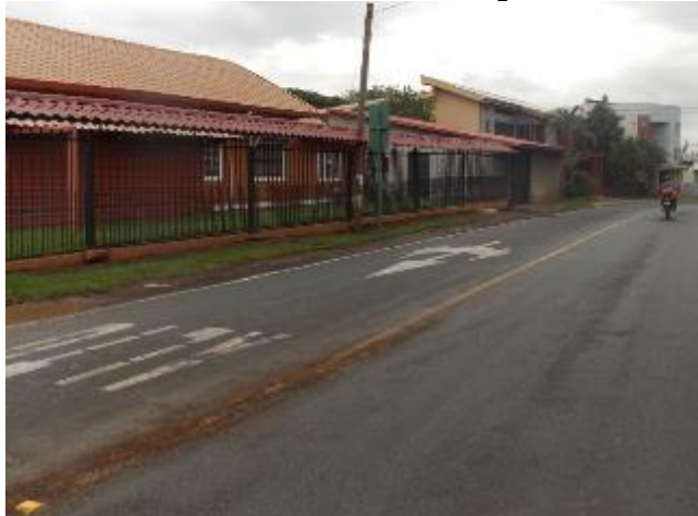
Desgaste de algunas figuras en la demarcación horizontal
