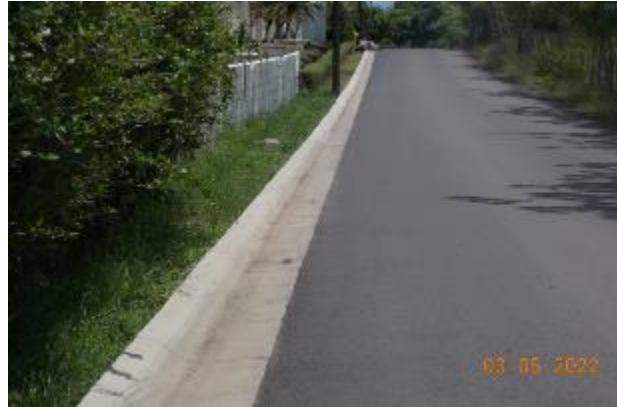
Presencia de cordones de caño en algunos sectores.
