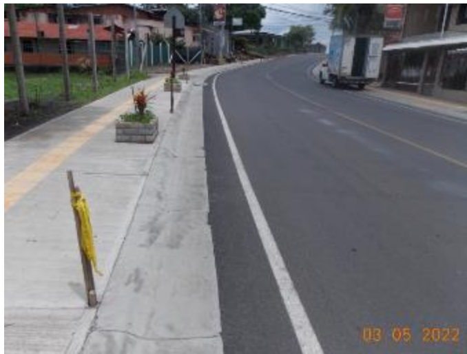
Presencia de cordones de caño y alcantarillado pluvial a lo largo de la ruta sin deterioros evidentes.
