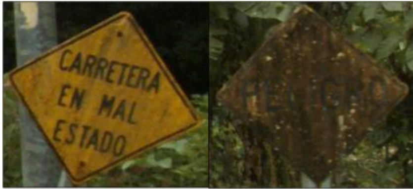
Figura 7. Categoría de señalización en buen estado, pero bloqueada o sucia (Nota = 66)
