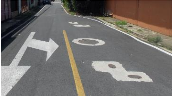
Tapas de alcantarilla y otros elementos a nivel con rasante
