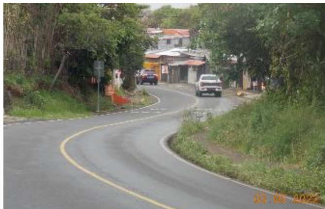
Presencia de aceras en algunos sectores
