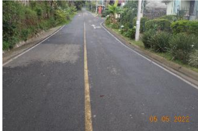
Demarcación horizontal visible con desgaste leve
