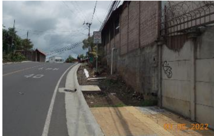
Zonas en proceso de construcción.
