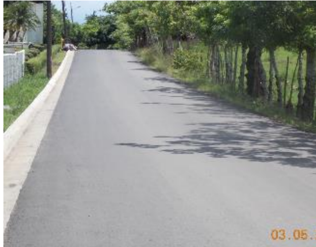
Ausencia de demarcación horizontal
