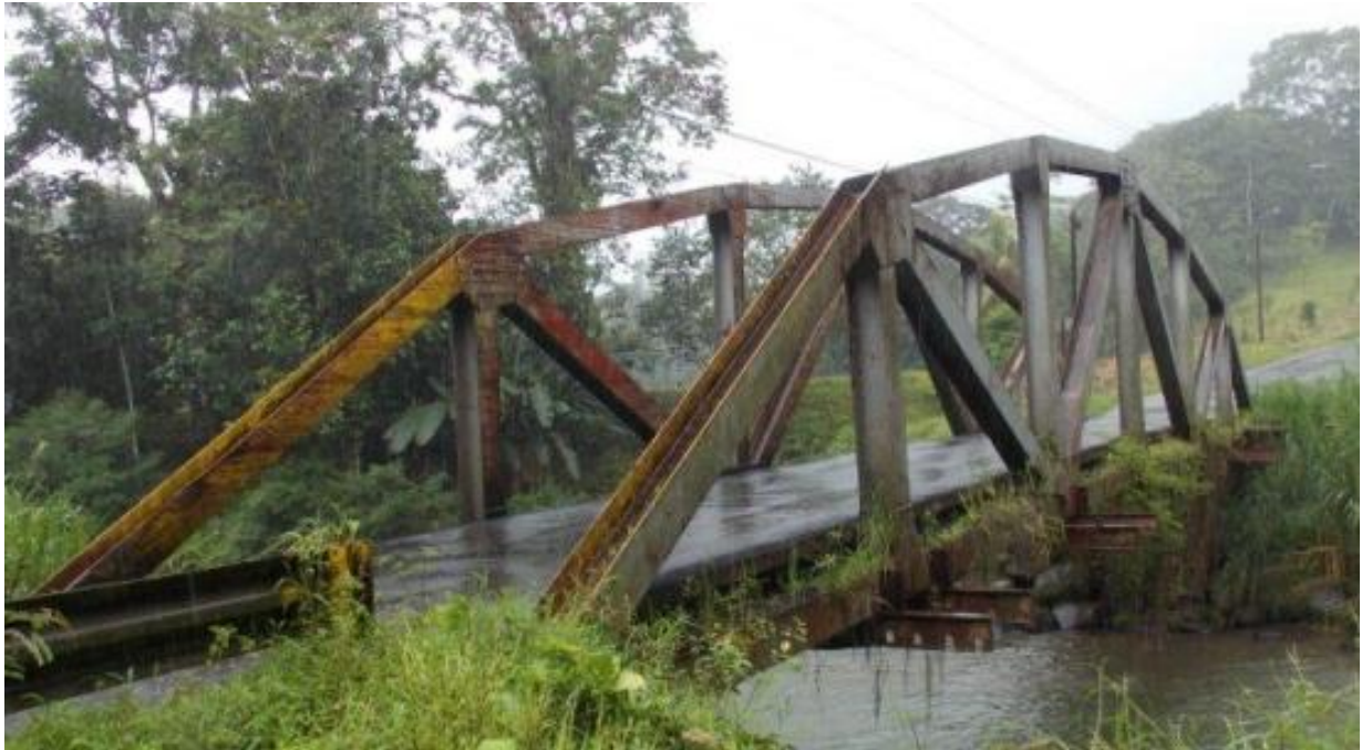
Figura C: Vista lateral oeste.
