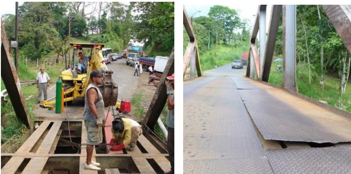
Figura E. Distintas condiciones del puente. Izquierda: adición de largueros y colocación de láminas de acero en abril de 2007; derecha: vista de la condición de las láminas de acero en setiembre de 2011(Fuente: http://www.radiosantaclara.org ).
