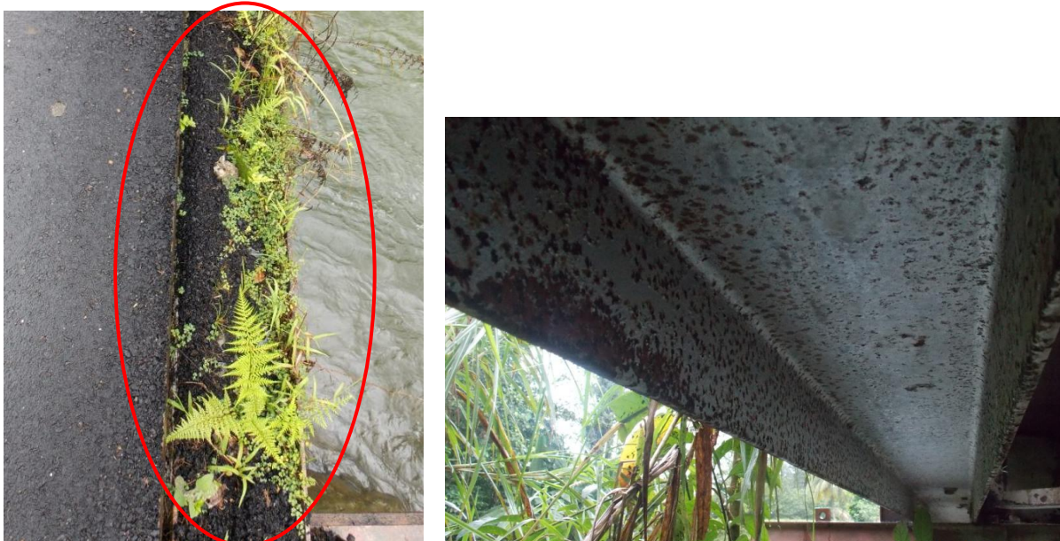
Figura 12. Indicios de corrosión así como acumulación de sedimentos, asfalto y vegetación en la cuerda inferior de las cerchas.
