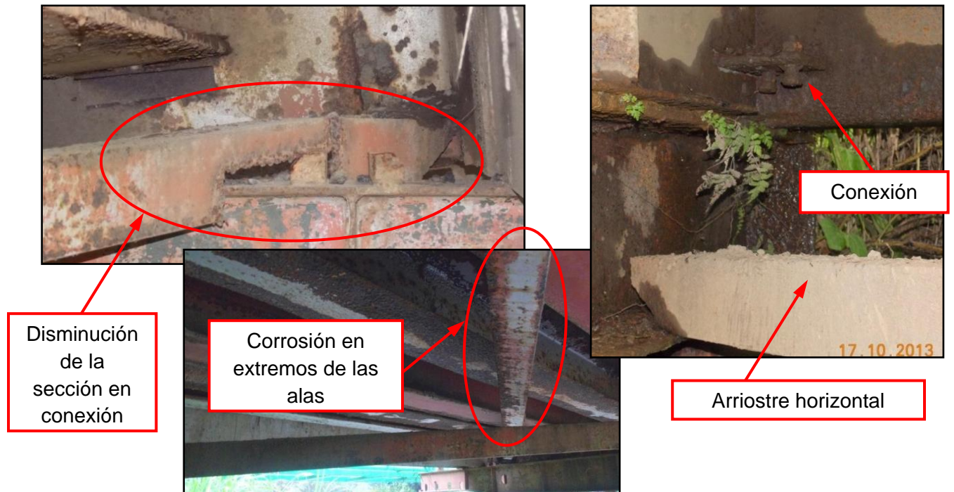
Figura 9. Arriostres: corrosión en los extremos de alas; disminución de sección transversal en conexión y ausencia de la misma.
