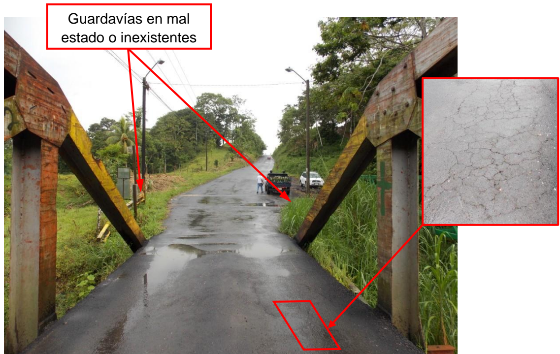
Figura 1: Ausencia de barrera vehicular, aceras, demarcación horizontal, bordillos, y ductos de drenaje; superficie de rodamiento con surcos y grietas; guardavías en mal estado o inexistentes.
