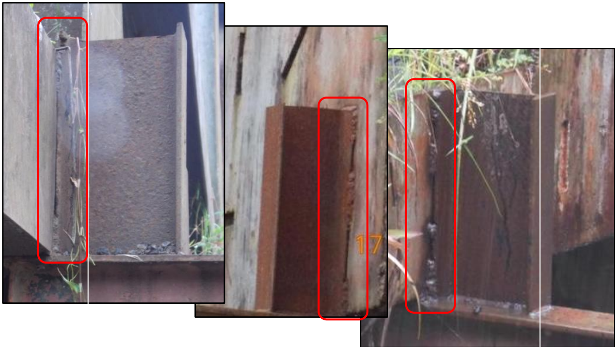
Figura 7. Diferencias en la longitud y espesor de soldadura utilizada en la unión de las vigas transversales adicionadas con la cuerda inferior de las cerchas laterales.
