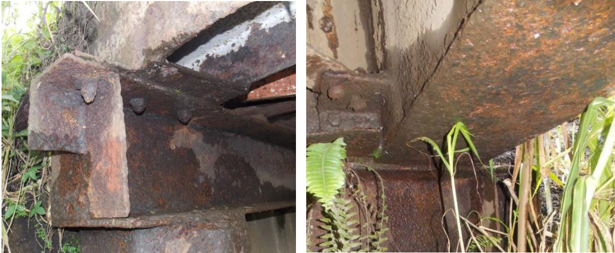
Figura 13. Estado avanzado de corrosión de los apoyos. Izquierda: caso del bastión 1; derecha: caso del bastión 2.
