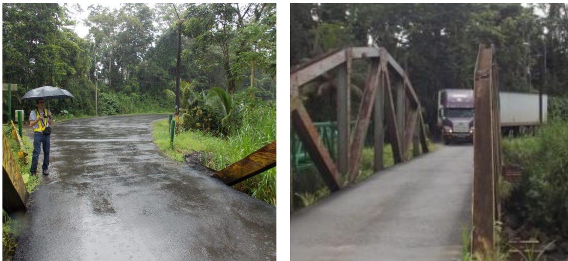
Figura 3. Alineamiento horizontal abrupto en el acceso norte del puente. Izquierda: vista en el sentido El Tanque-Monterrey; derecha: camión alineándose para ingresar al puente.
