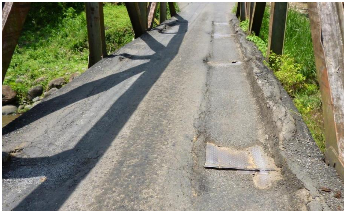
Figura F. Condición de la carpeta asfáltica en junio de 2013 (Fuente: LanammeUCR).
