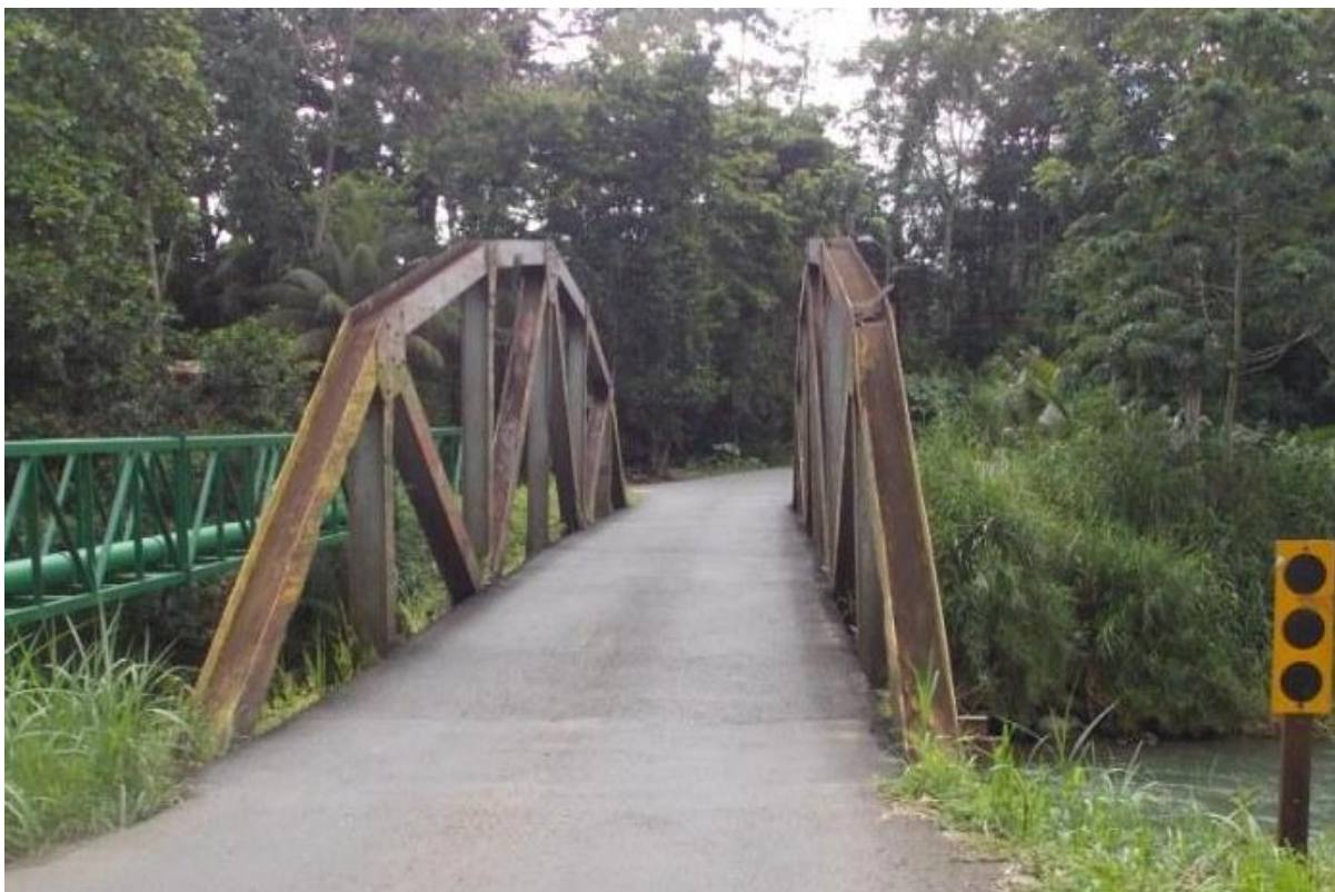
Figura B: Vista a lo largo de la línea de centro.
