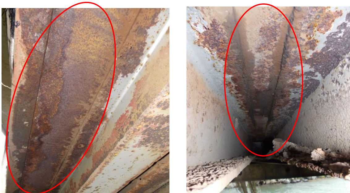
Figura 10. Corrosión, así como paso de agua y sedimentos en láminas de acero de tablero.
