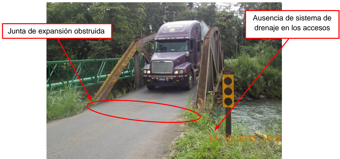
Figura 2. Paso de peatones limitado y peligroso; ausencia de sistema de drenaje en los accesos; juntas de expansión obstruidas.
