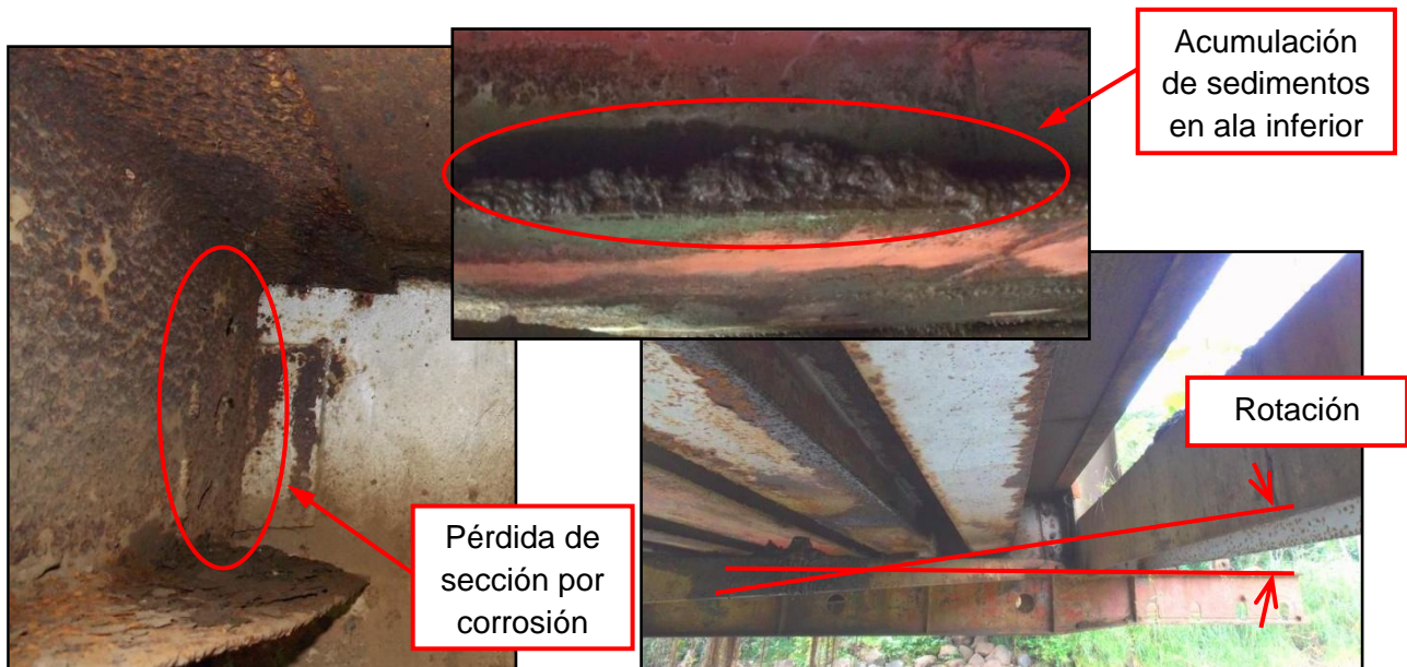
Figura 8. Largueros del puente: acumulación de sedimentos; corrosión, delaminación y pérdida de sección; rotación en su sección transversal.
