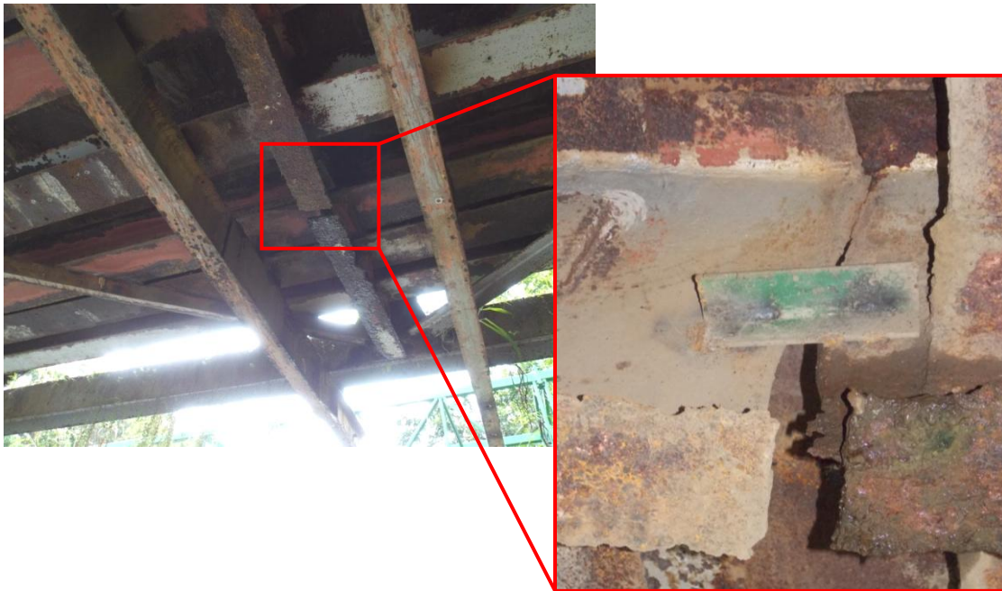
Figura 5. Viga transversal fracturada y en estado avanzado de corrosión, ubicada del lado del bastión 2.
