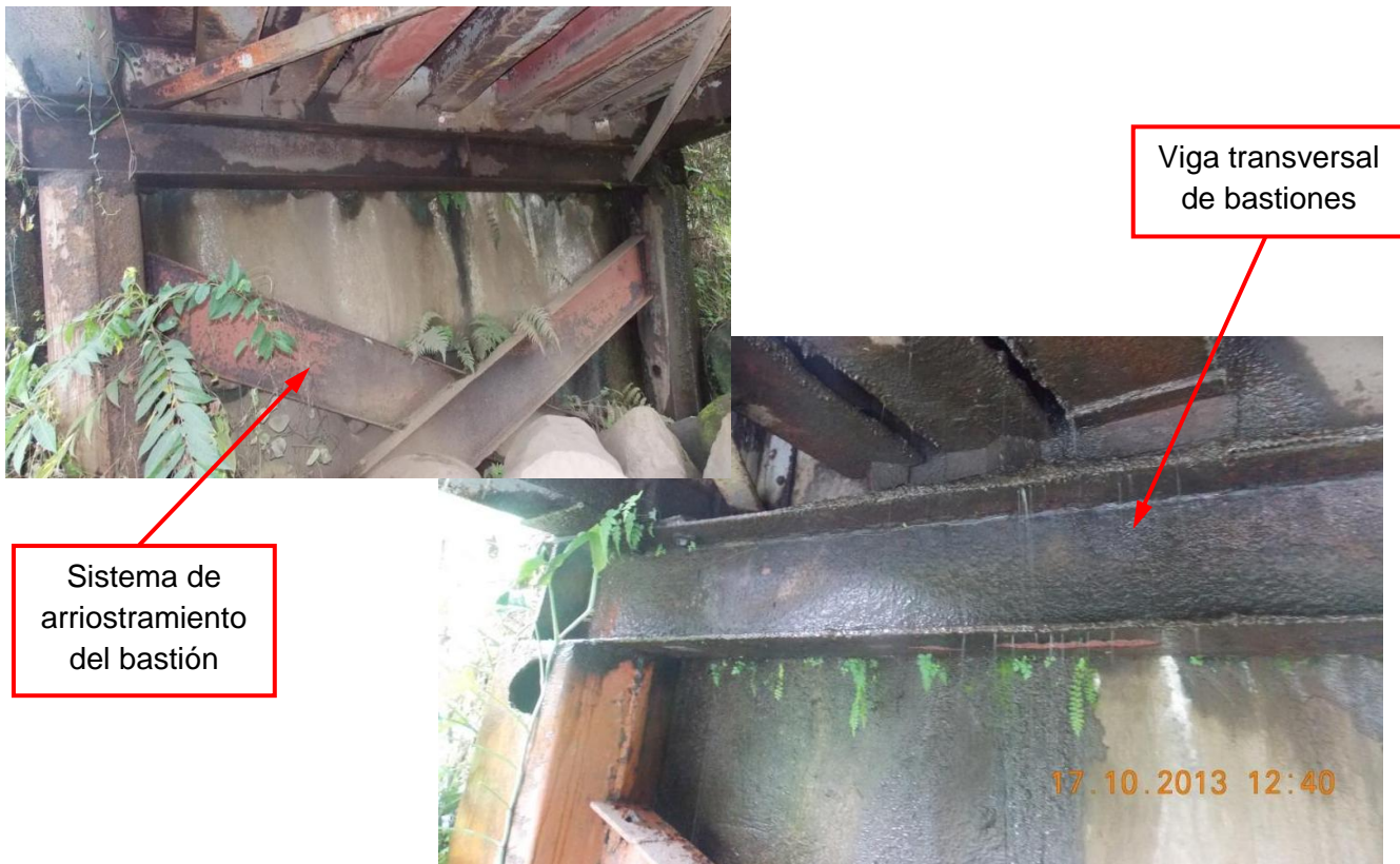
Figura 14 Condición de los bastiones. Izquierda: sistema de arriostramiento excéntrico en bastión 1; derecha: viga transversal en estado avanzado de corrosión en bastión 2.
