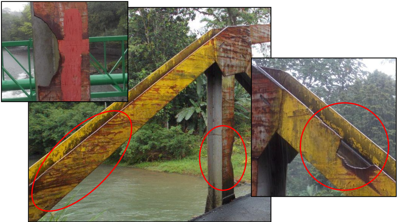
Figura 11. Cerchas laterales: indicios de corrosión, secciones faltantes, así como deformaciones locales, abolladuras y rasgaduras
