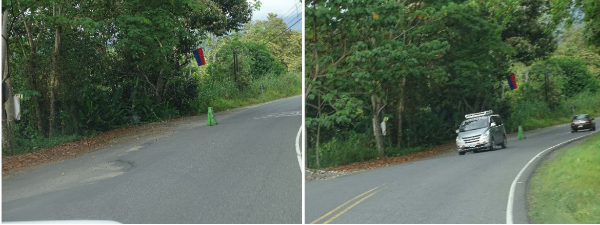
Figura 28. Hundimiento sobre la carretera. Ruta Nacional 2, Sección de control 60012 (Límite Cantonal Osa/Golfito – Río Claro) Estacionamiento 316+163. Fecha 17 de febrero de 2022. Fuente: LanammeUCR
