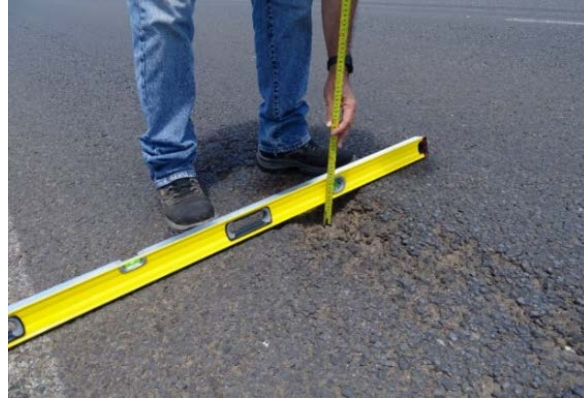
Figura 22. Desprendimiento de agregado. Ruta Nacional 4, Sección de control 21002 (Límite Cantonal Grecia/San Carlos - San José Aguas Zarcas Ruta 751). Estacionamiento 4+173. Fecha 22 de marzo de 2022. Fuente: LanammeUCR
