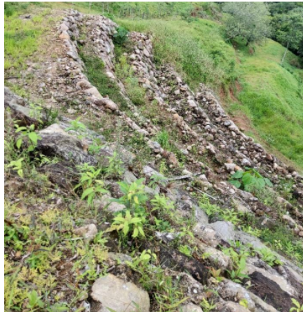
Figura 2 Estructura de contención tipo muro de enrocado por gravedad
