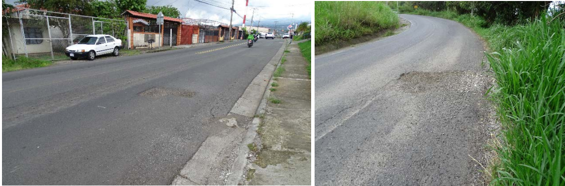
Figura 16. Huecos sobre bacheos, Ruta Nacional 117, Sección de control 40430 Montero o San Miguel (R32) – Los Ángeles de Tures (R116). Estacionamiento 2+663 y 3+736. Fecha 11 de mayo de 2022. Fuente: LanammeUCR
