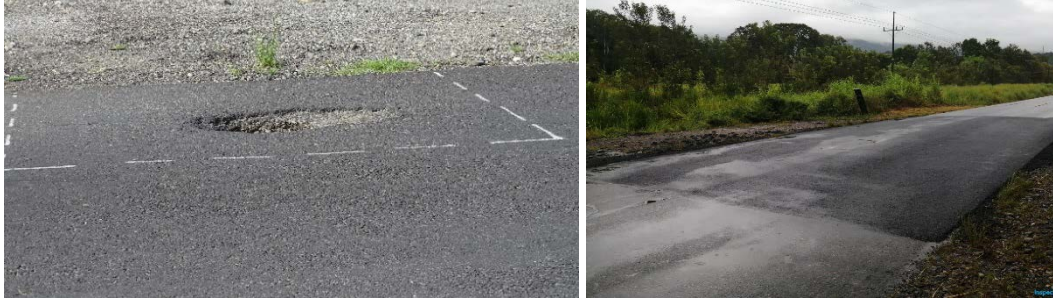
Figura 7. Condición de hueco el 17 de febrero del 2022 y condición de reparación el 14 de septiembre de 2022, Ruta Nacional 2, Sección de control 60030 (Palmar Norte R34 – Chacarita R245). Estacionamiento 273+620. Fecha 17 de febrero y 14 de septiembre del 2022. Fuente: LanammeUCR
