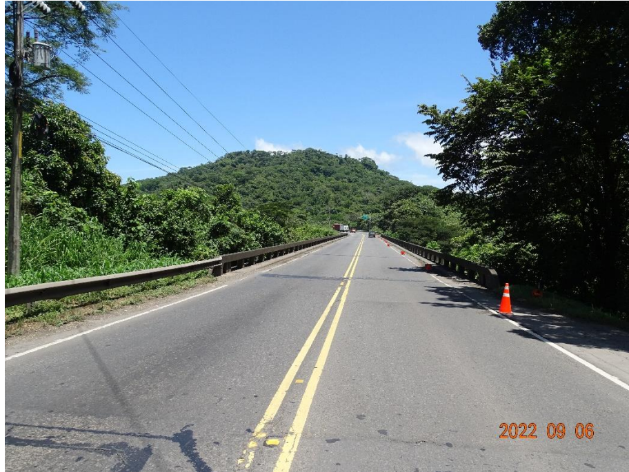
Figura 4.2. Vista a lo largo de la línea de centro del puente hacia Caldera
