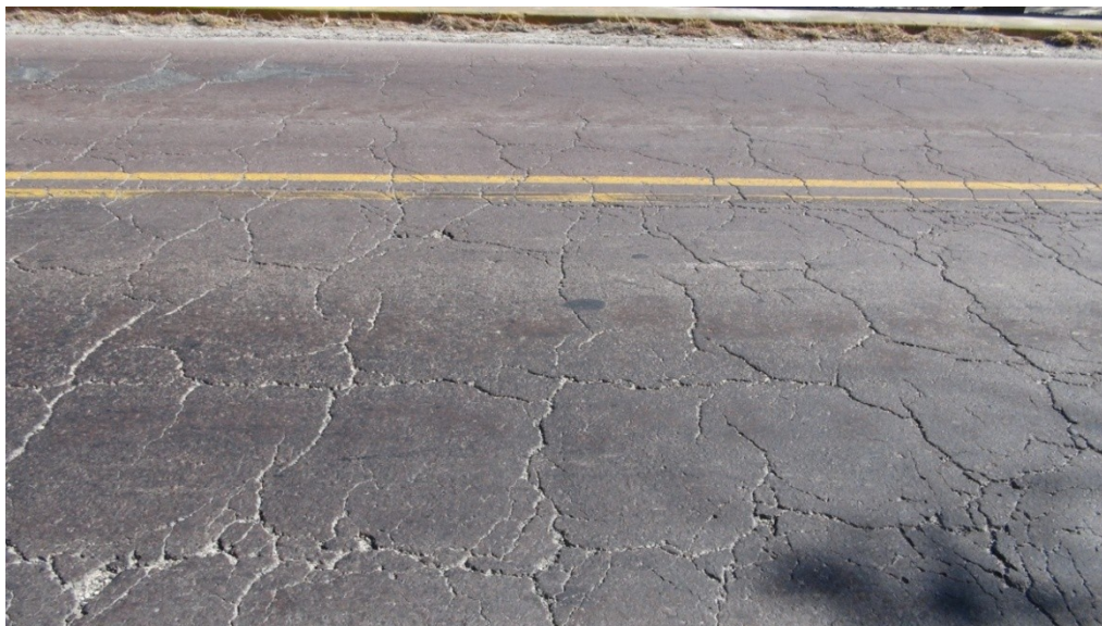
Figura 5: Agrietamiento de la carpeta asfáltica sobre el puente.
