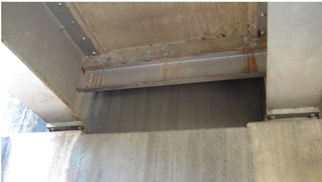
Figura 15: Oxidación de la viga diafragma ubicada sobre el bastión norte.
