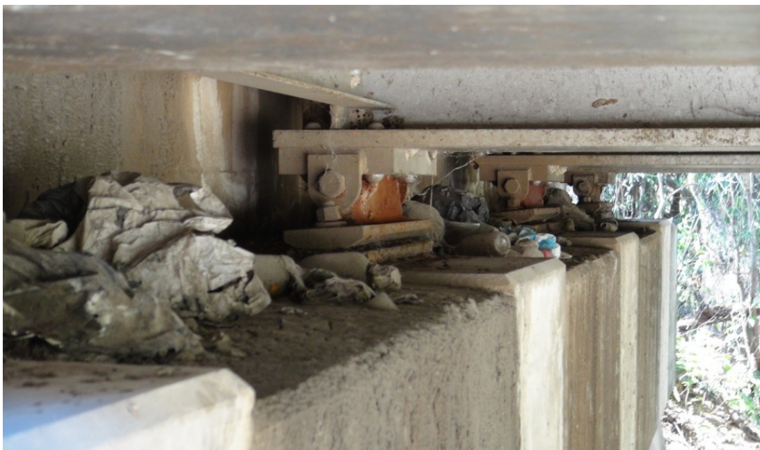
Figura 16: Leve inclinación de los apoyos expansivos (bastión sur) y acumulación de basura y sedimentos a su alrededor.
