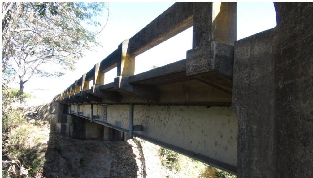
Figura 3: Vista lateral del puente sobre el Río Caraña.
