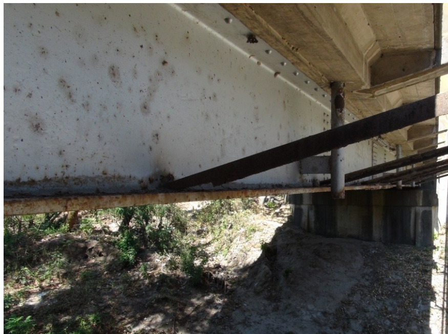
Figura 11: Piquetes de corrosión y oxidación a lo largo del ala inferior de viga externa.
