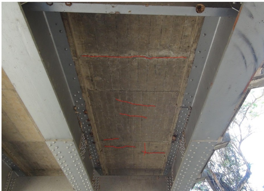
Figura 9: Agrietamiento generalizado de la losa de concreto
