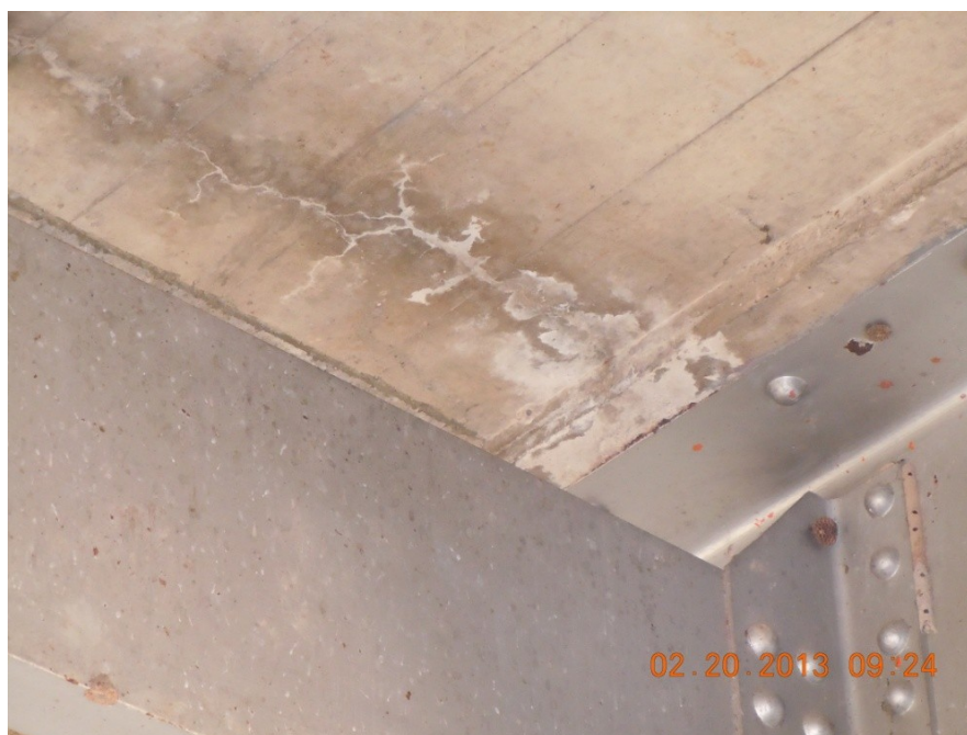
Figura 10: Eflorescencia observada a lo largo de grietas de la losa de concreto
