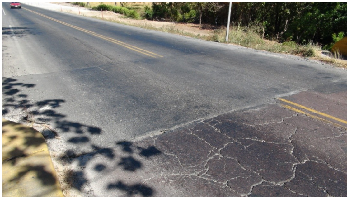
Figura 8: Obstrucción de junta de expansión sobre el bastión sur por una sobrecapa asfáltica.
