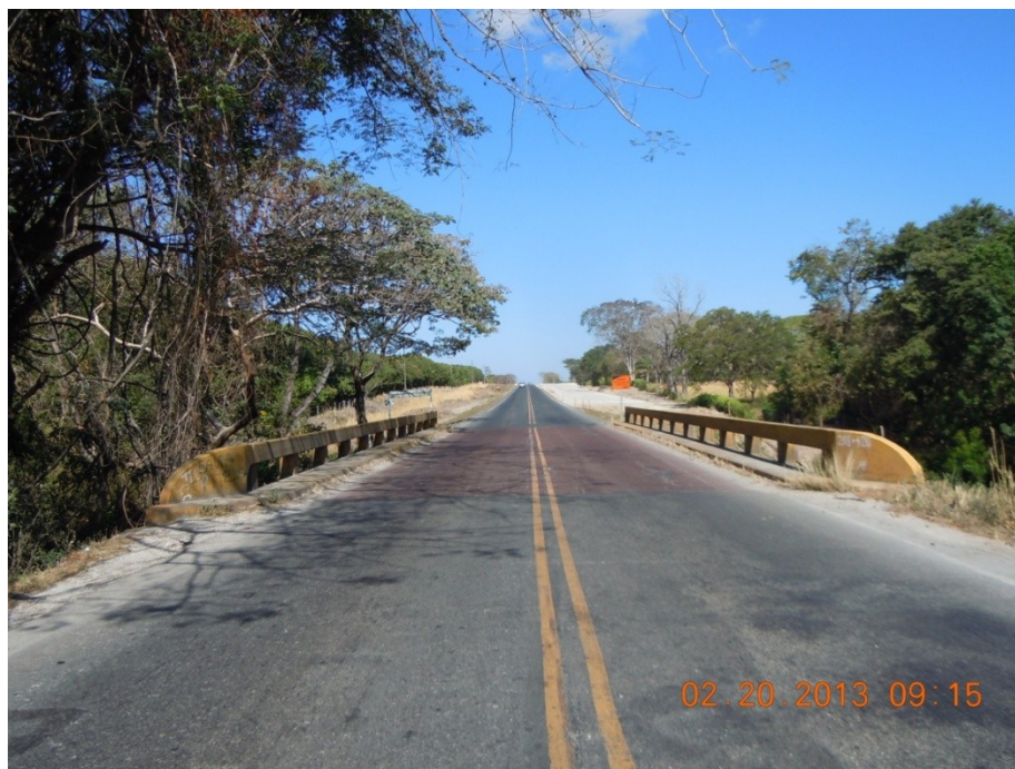
Figura 2: Vista a lo largo de la línea de centro del puente sobre el Río Caraña.
