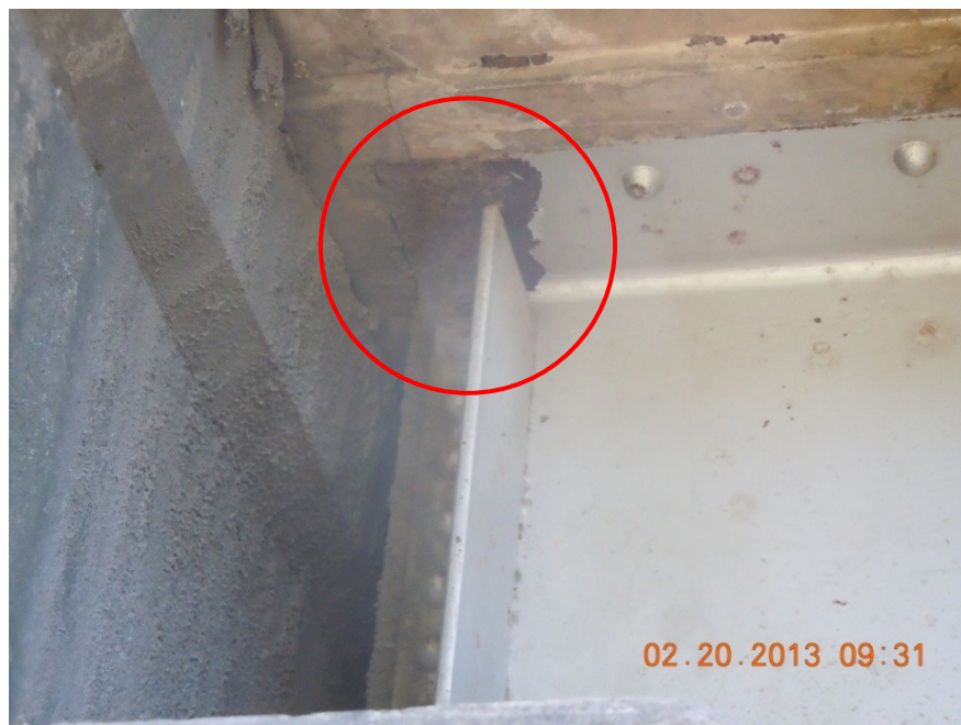
Figura 12: Inicios de corrosión en extremo de viga externa.
