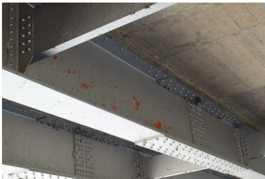
Figura 14: Desprendimiento de pintura y exposición de la capa base.
