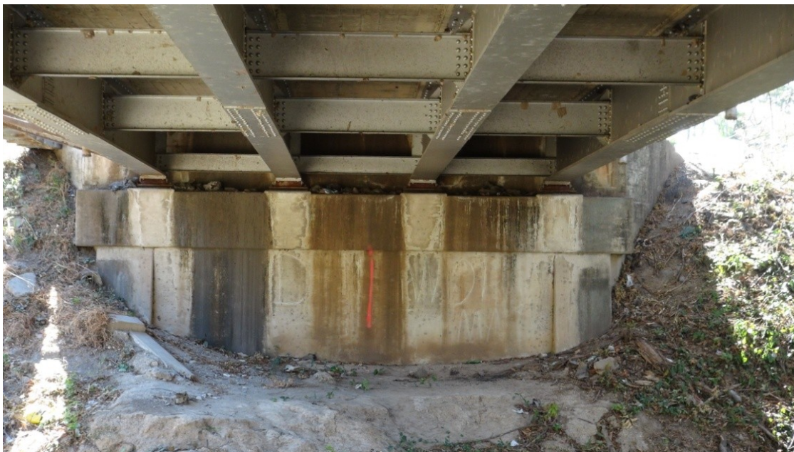
Figura 7: Evidencia de filtraciones a través de las juntas de expansión en el bastión sur.
