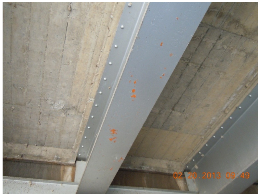
Figura 13: Desprendimiento de pintura y exposición de la capa base.
