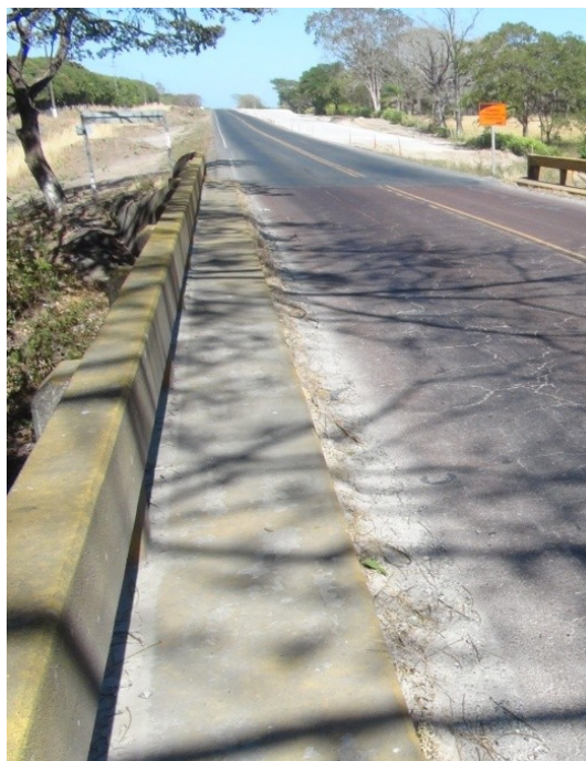
Figura 6: Acumulación de sedimentos en los bordillos y obstrucción de los ductos de desagüe.
