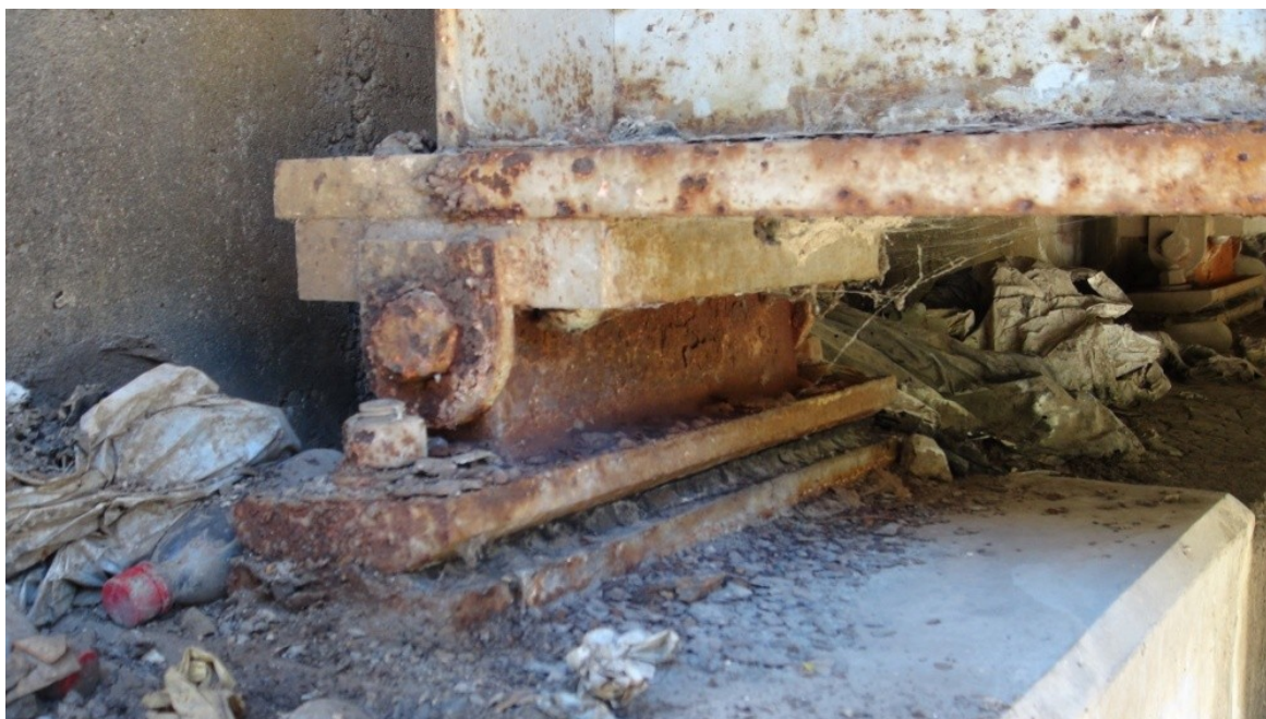
Figura 17: Estado avanzado de corrosión y acumulación de sedimentos observada en uno de los apoyos expansivos.
