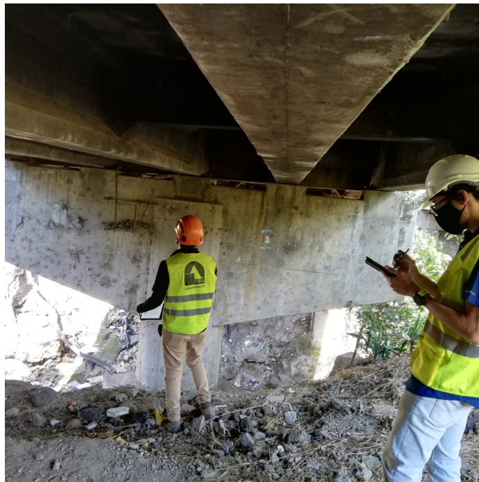
Figura 2. Inspección rutinaria del puente sobre el río Corrogres en la RN27 Fuente: LanammeUCR, 2021.
