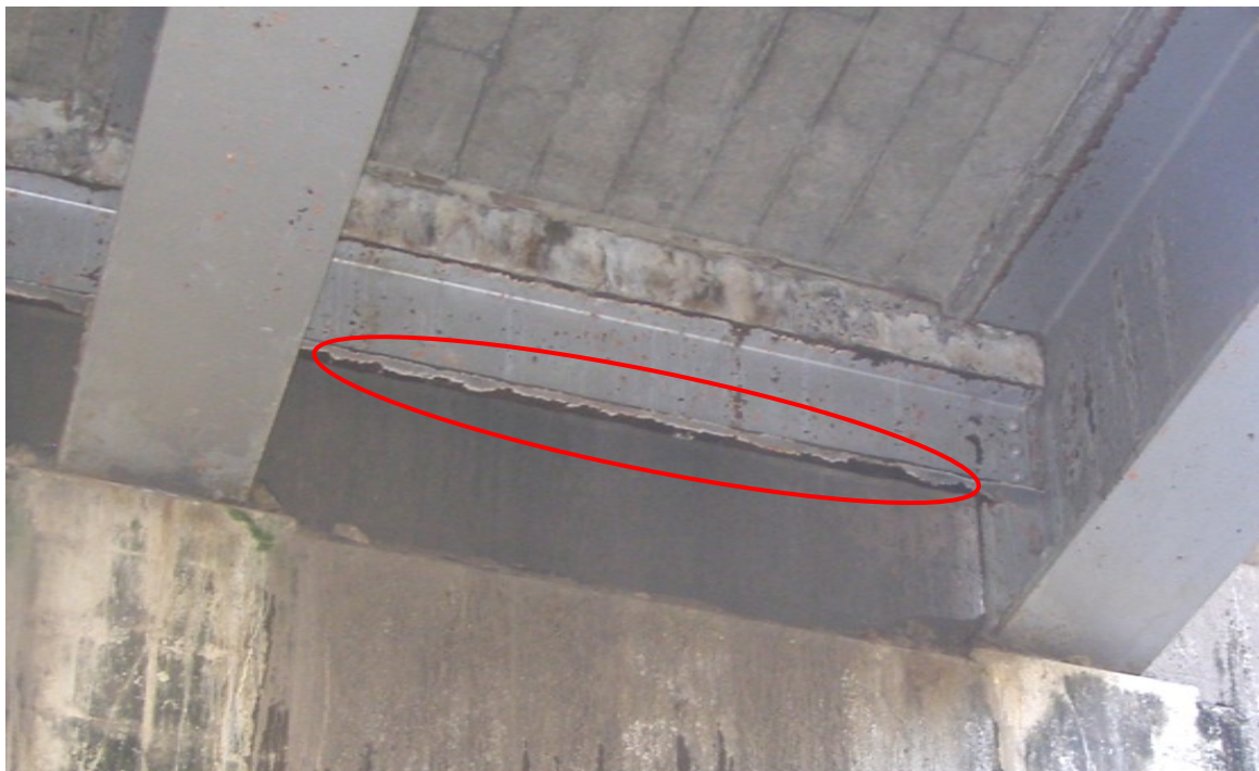
Figura 17. Corrosión en vigas diafragma sobre el bastión 2
