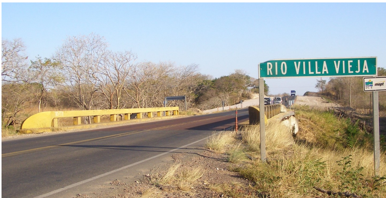
Figura 2. Vista a lo largo de la línea de centro del puente sobre el Río Villa Vieja.
