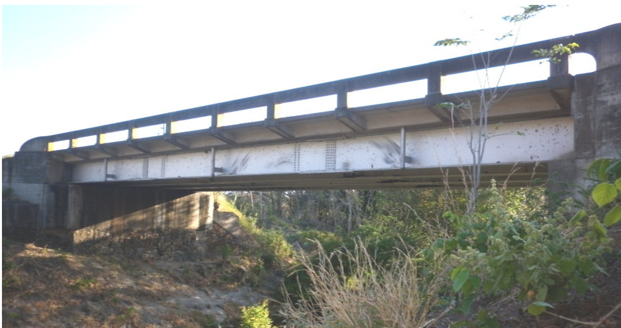
Figura 3. Vista lateral del puente sobre el Río Villa Vieja.
