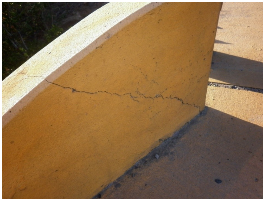
Figura 5. Grieta en la baranda del extremo suroeste en la zona del acceso 1, producto del golpe de vehículos.
