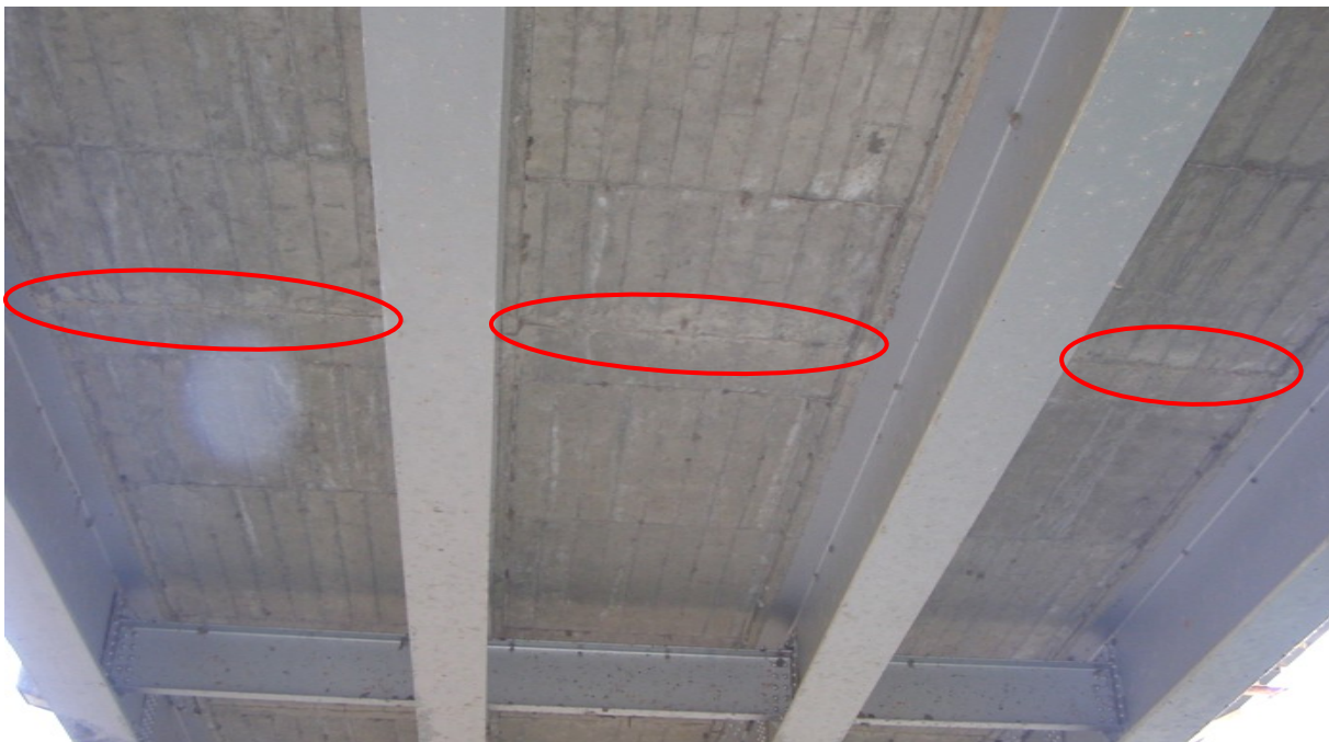
Figura 13. Eflorescencia y agrietamiento transversal en la superficie inferior de la losa.
