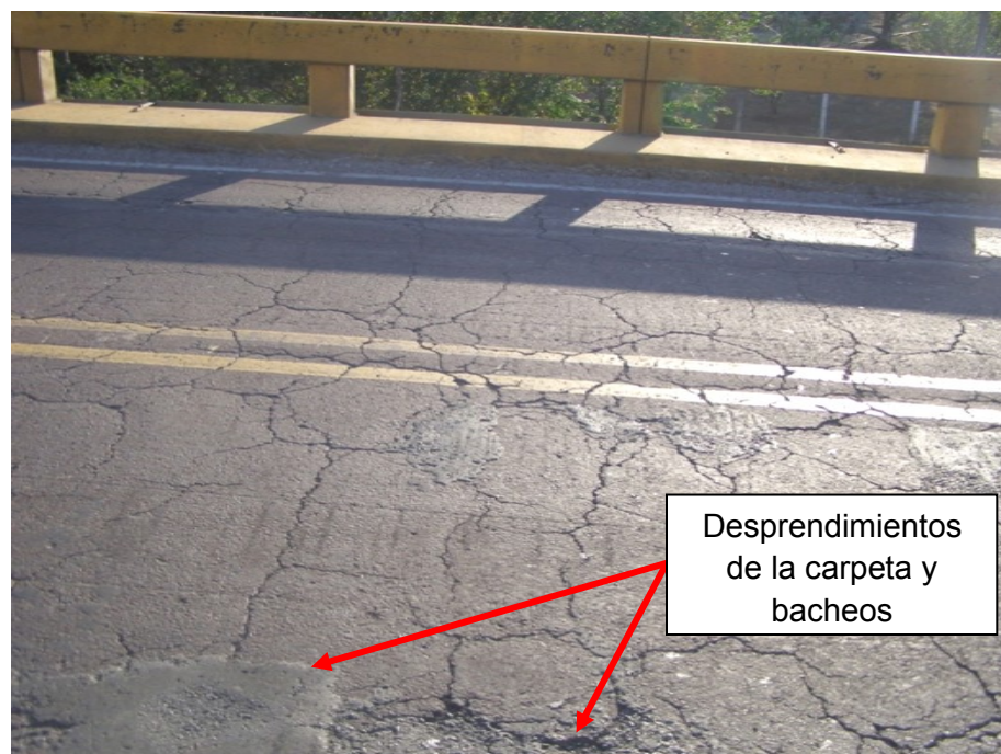
Figura 8. Agrietamiento en dos direcciones, desprendimientos y bacheos en la carpeta asfáltica de la superficie de rodamiento.
