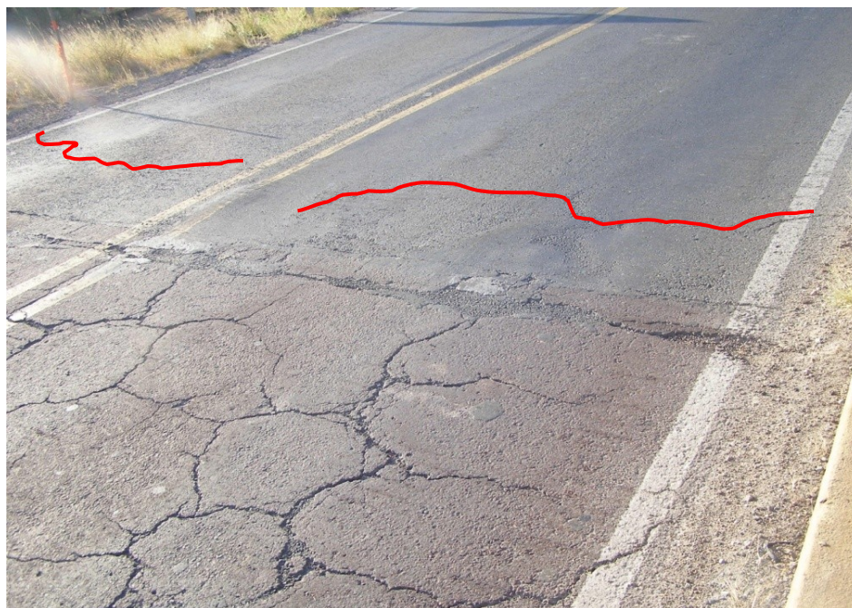
Figura 9. Agrietamiento transversal y ondulaciones en el acceso 2.
