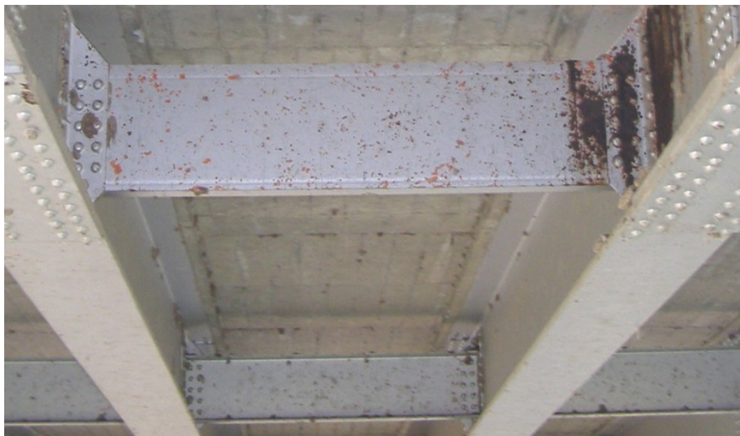
Figura 18. Piquetes de corrosión y desprendimientos de pintura en vigas diafragma
