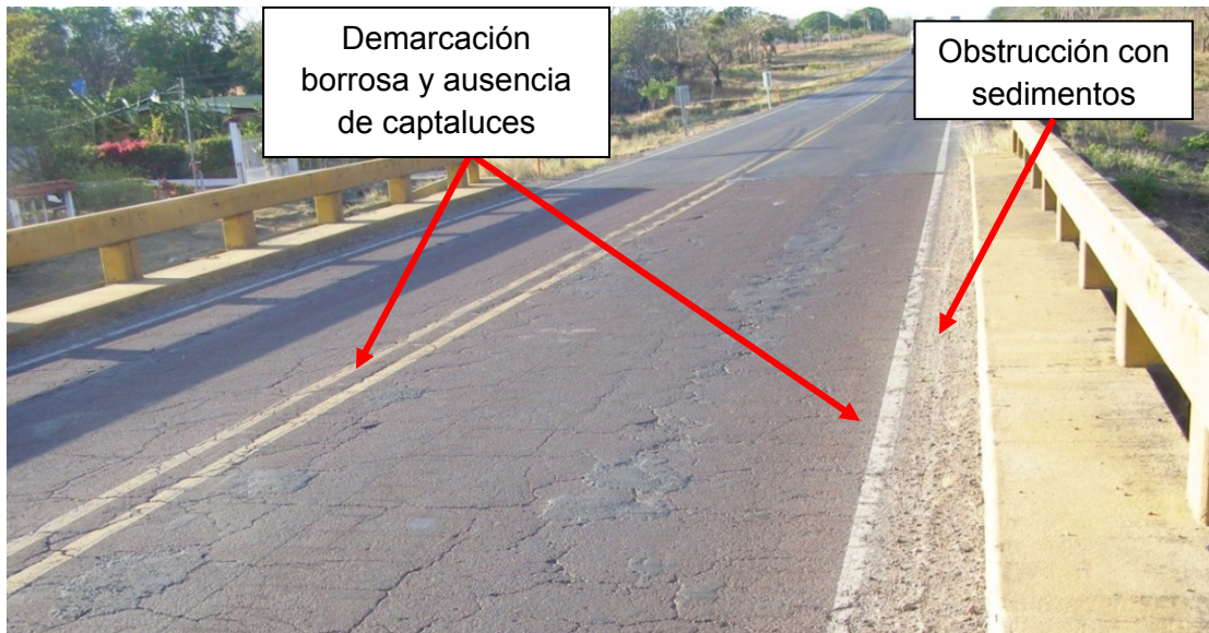
Figura 7. Demarcación horizontal borrosa, ausencia de captaluces y obstrucción de bordillos con sedimentos.
