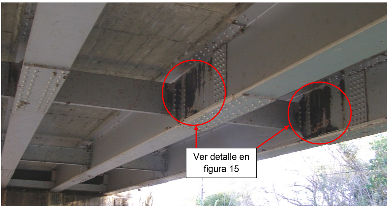
Figura 14. Corrosión en las conexiones de las vigas principales y vigas diafragma de acero.
