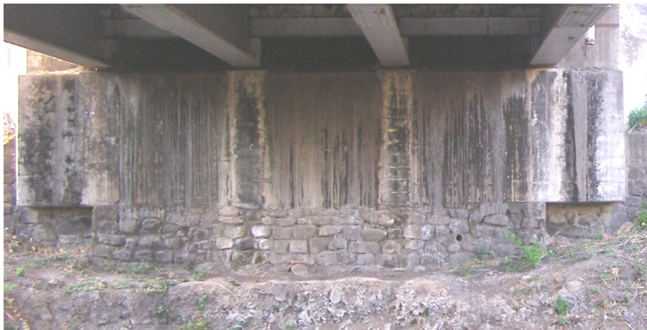
Figura 20. Viga cabezal de bastión 2 cubierta de humedad y moho.
