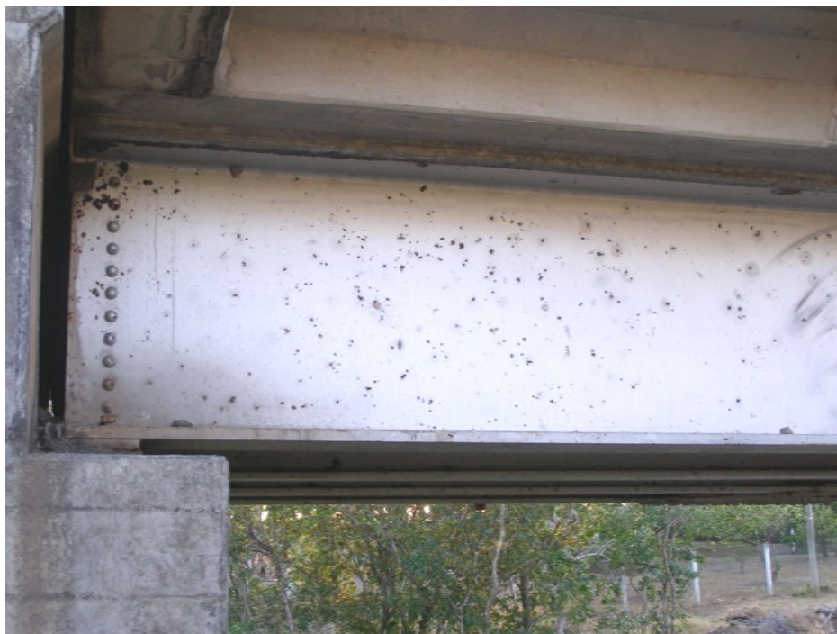
Figura 16. Piquetes de corrosión en viga principal de acero
