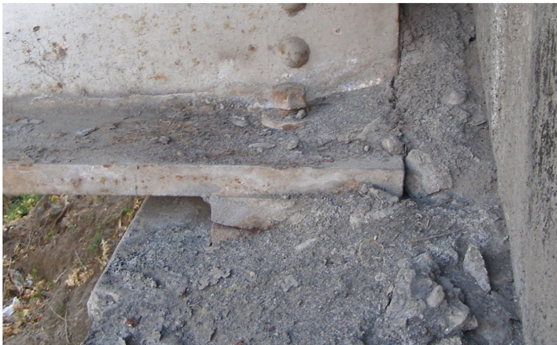
Figura 19. Apoyo sobre el bastión 2 cubierto de sedimentos provenientes de la superficie del puente.
