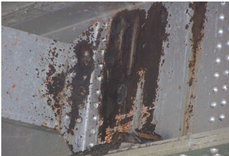
Figura 15. .Detalle de corrosión típica en la conexión entre vigas principales y vigas diafragma de acero.
