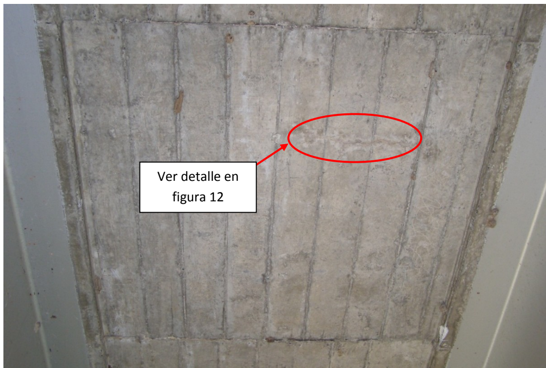
Figura 11. Grieta en una dirección en la zona inferior de la losa.
