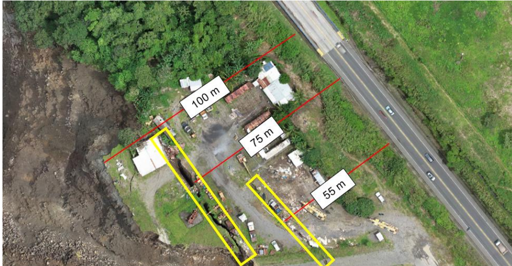
Figura 11. Condición del sitio afectado por el deslizamiento de la margen del río Virilla, km 17+065 de la RN N°27
