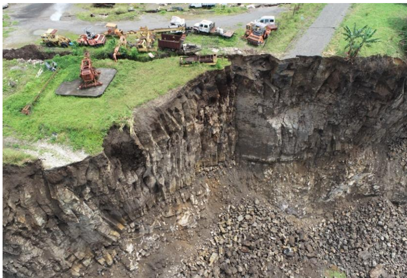
Figura 12. Estado del macizo rocoso para su clasificación con el sistema GSI
