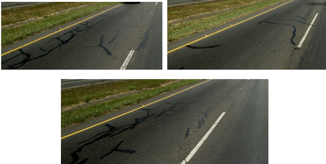
Figura 31. Sellos de grietas
