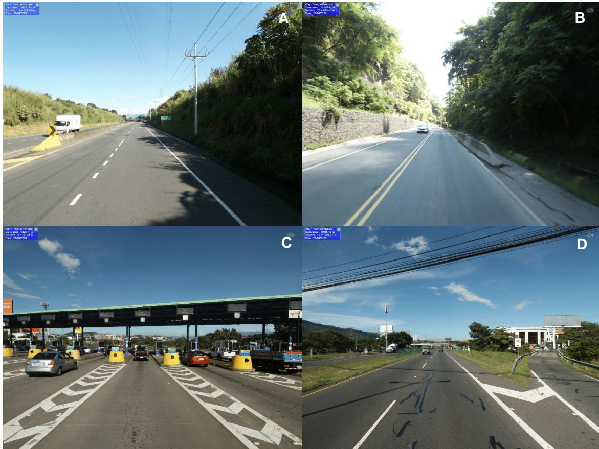
Figura 115. Deficiencias críticas a nivel de terminales: inicio de barrera medianera (A), inicio de barrera lateral (B), zona de peaje (C) y rampa de salida (D)
