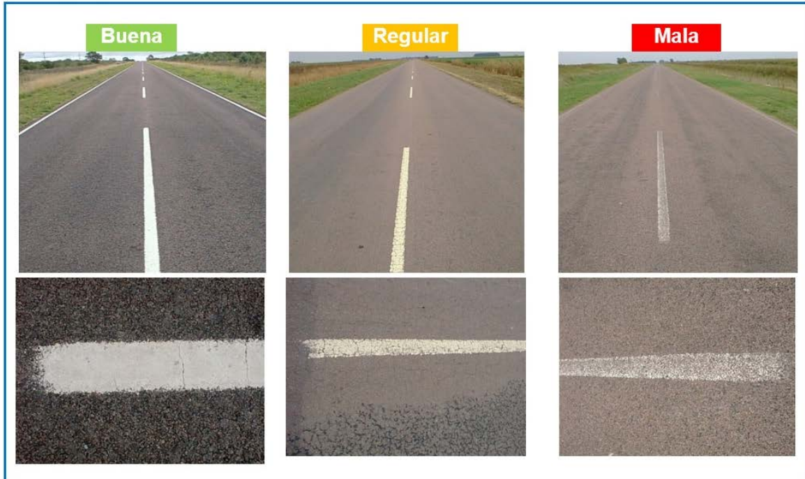
Figura 83. Clasificación visual en función del estado del señalamiento vertical
