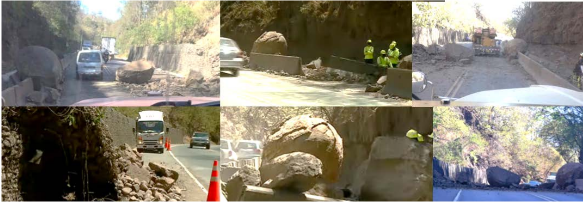
Figura 70. Serie de fotografías de los bloques de roca de tamaño métrico que cayeron sobre la Ruta Nacional No.27, en el estacionamiento Pk 75+000 y provocaron el cierre de la vía en ambos sentidos, marzo 2021.
