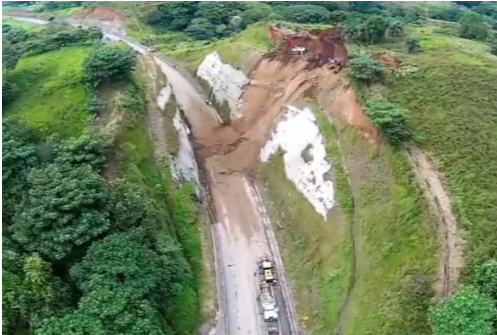
Figura 65. Fotografía aérea del primer deslizamiento que bloqueo la ruta en el km 40+700, noviembre 2014.
