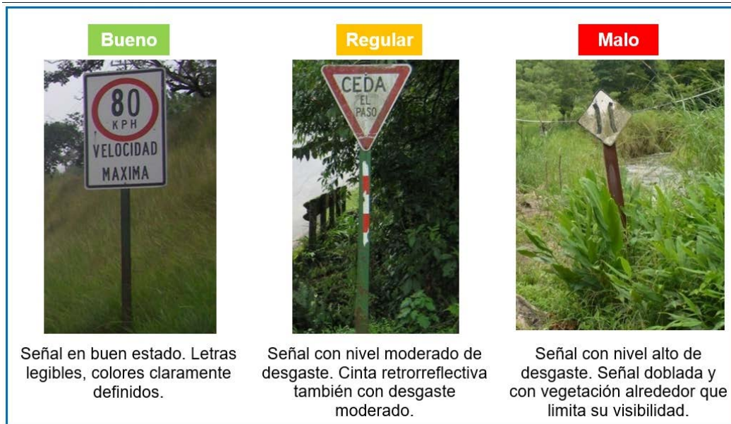
Figura 82. Clasificación visual en función del estado del señalamiento vertical
