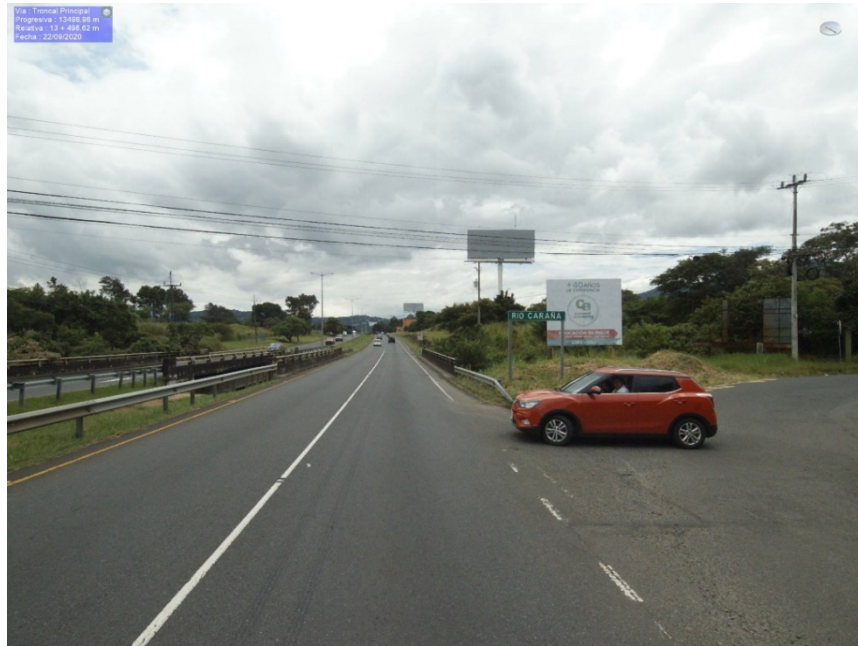
Figura 176. Accesos inseguros a Ruta Nacional 27, aledaño al puente sobre el río Caraña
