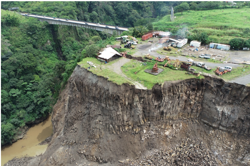
Figura 78. Vista aérea del deslizamiento que ocurrió el 18 de setiembre del 2022 en la margen izquierda del río Virilla, aguas abajo del Puente de la RN-27
