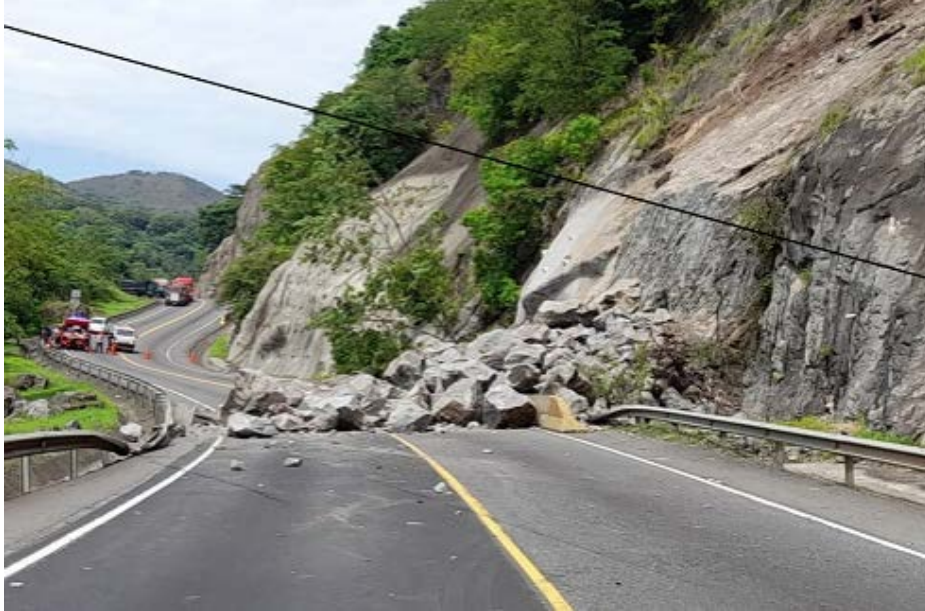
Figura 71. Deslizamiento en km 46+200 el 10 de mayo del 2022
