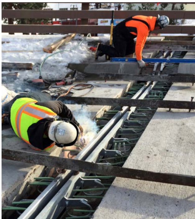
Figura 3. Reemplazo de una junta de conexión como parte de las actividades de conservación Fuente: FHWA, 2018
