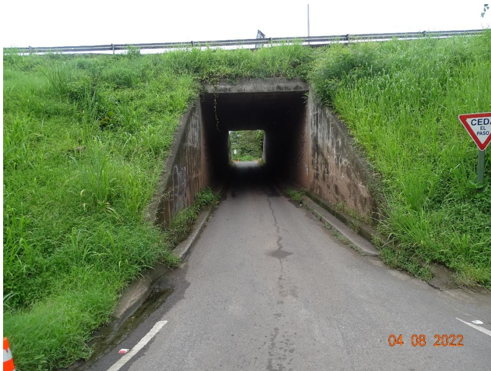
Figura 4.3. Vista lateral del puente en el costado sur
