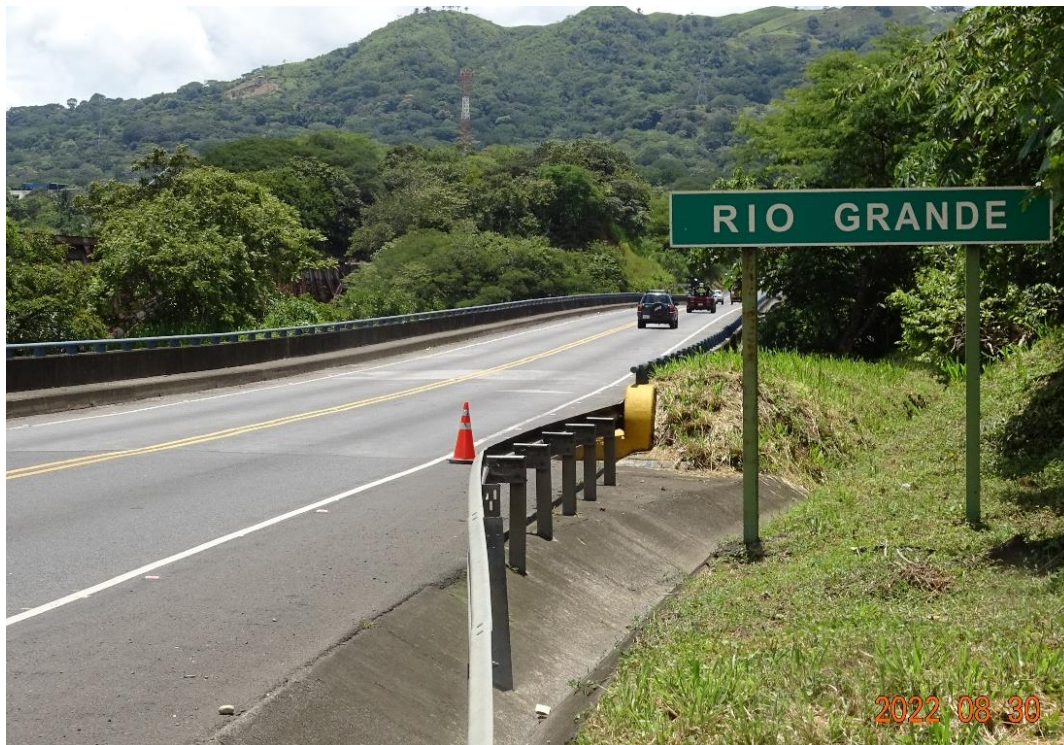
Figura 4.2. Vista a lo largo de la línea de centro del puente hacia Orotina
