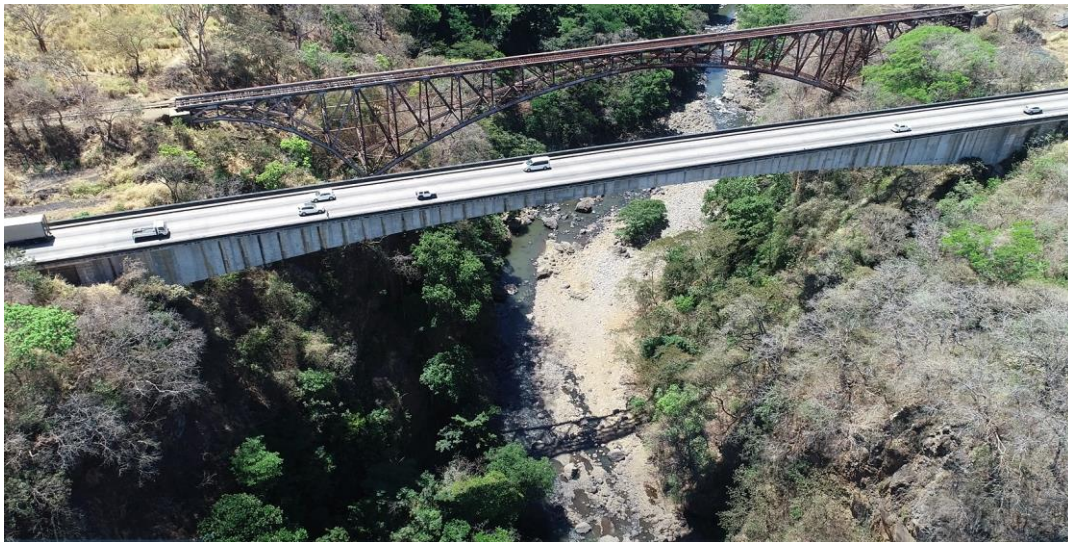
Figura 4.3. Vista lateral del costado aguas arriba del puente
