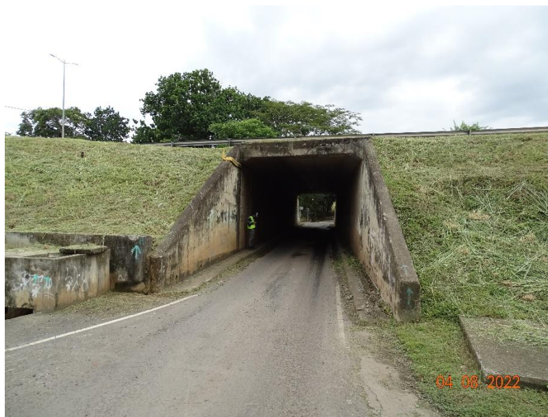
Figura 4.3. Vista lateral del costado noroeste del puente
