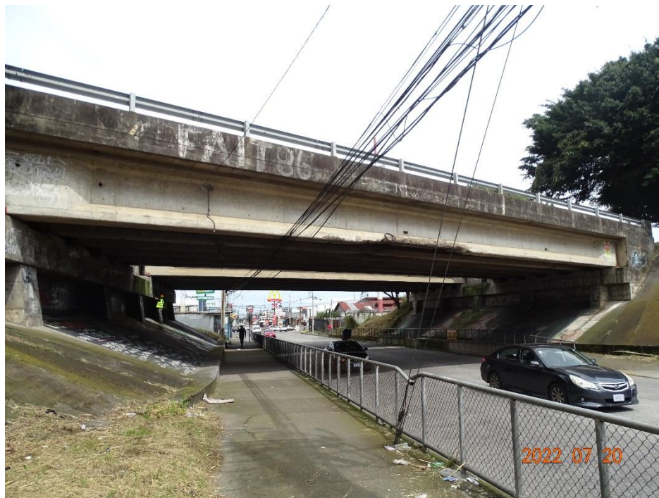
Figura 4.3. Vista lateral del costado este del puente
