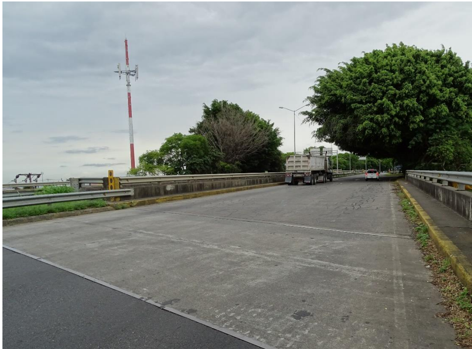
Figura 4.2. Vista a lo largo de la línea de centro del puente hacia Limón
