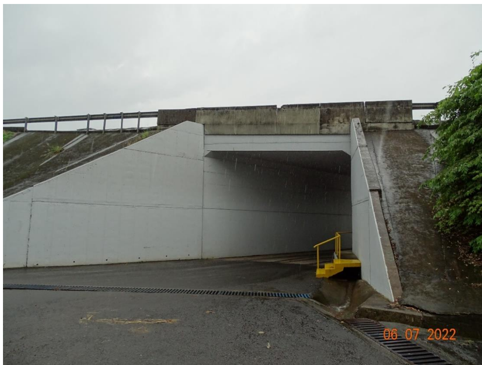
Figura 4.3. Vista lateral del costado norte del puente
