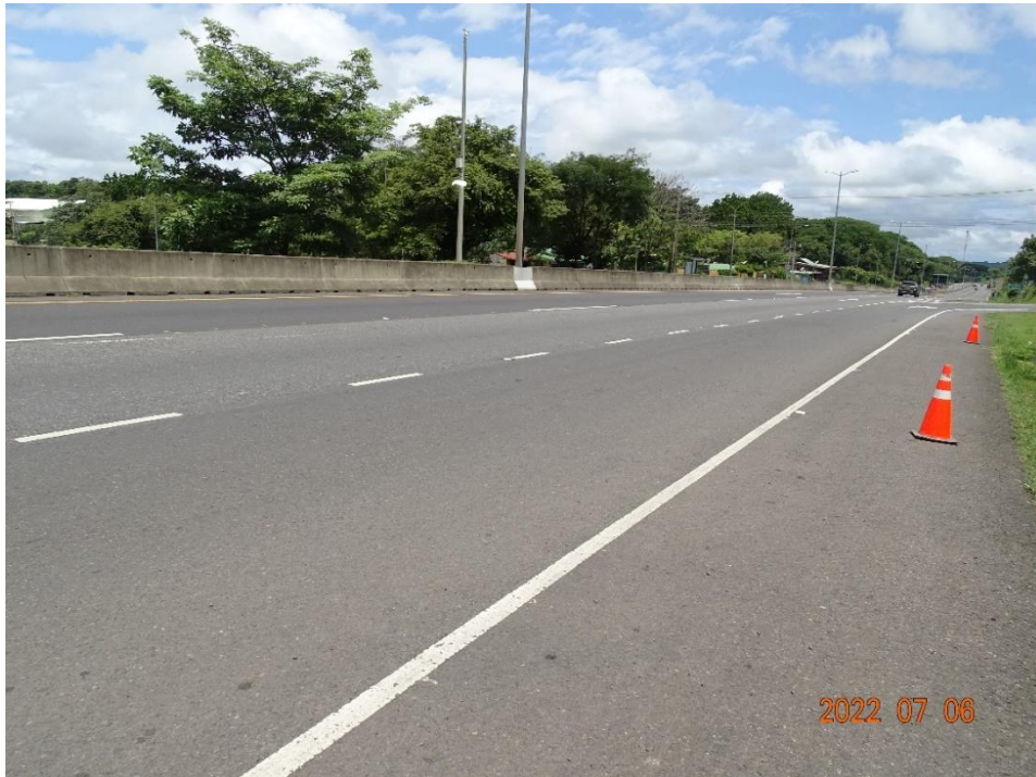
Figura 4.2. Vista a lo largo de la línea de centro del puente hacia Puntarenas
