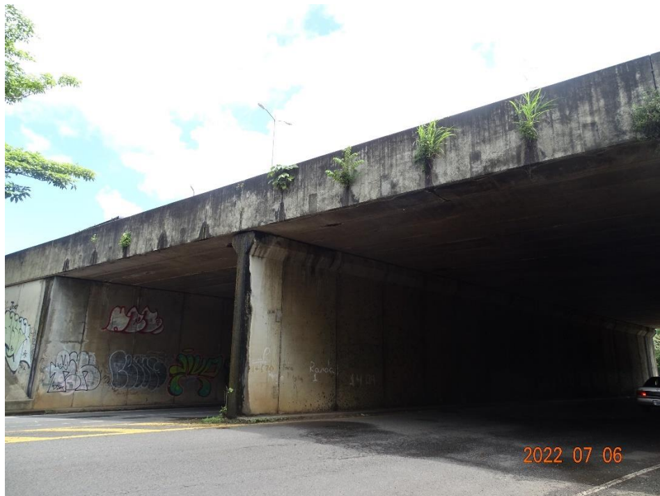
Figura 4.3. Vista lateral del costado sur del puente
