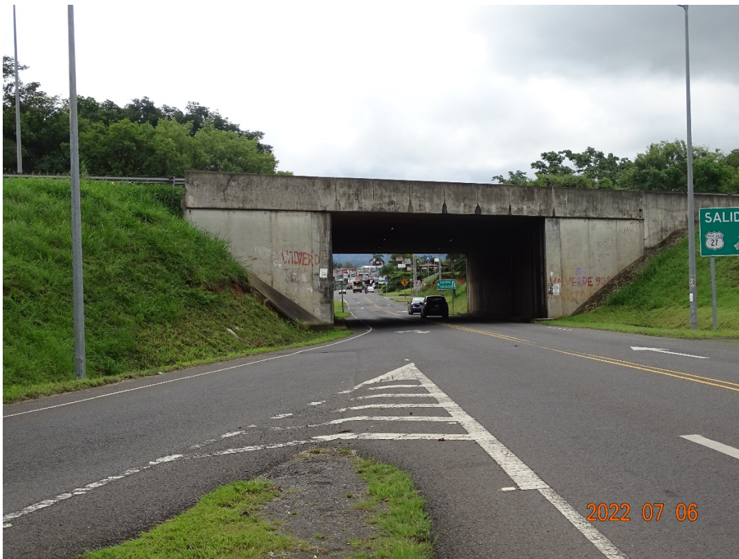
Figura 4.3. Vista lateral del costado sur del puente
