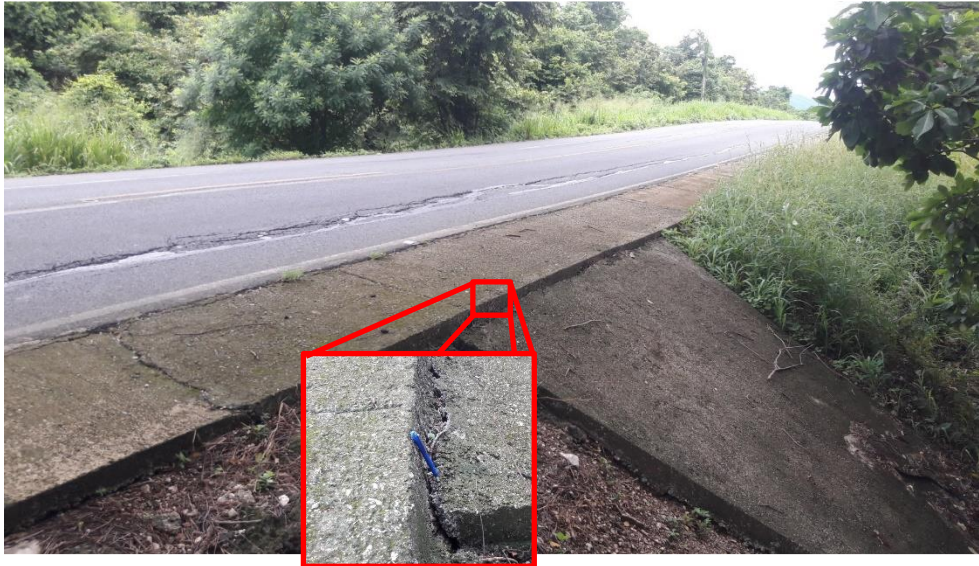
Figura 27: Evidencia de deslizamiento de losa de recubrimiento del talud de las alcantarillas
