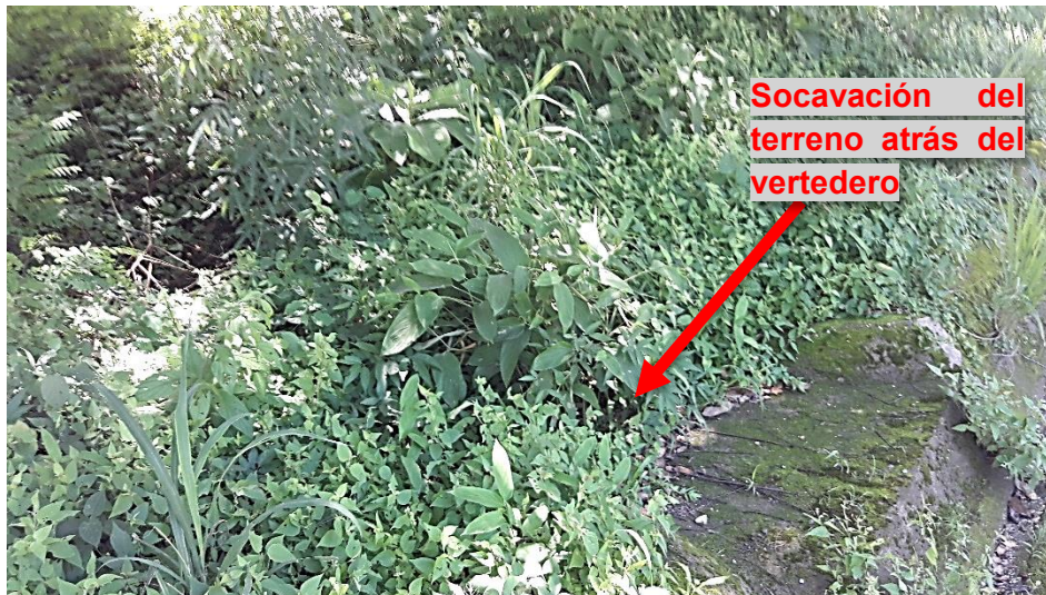
Figura 23: Socavación del terreno próximo a estructuras del drenaje superficial
