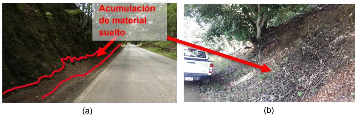
Figura 29: Presencia de materiales sueltos al pie de los taludes debido a la erosión producida por la escorrentía superficial
