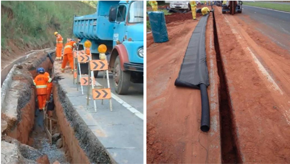
Figura 34: Ejemplos de procesos constructivos para mejoramiento del drenaje subsuperficial
