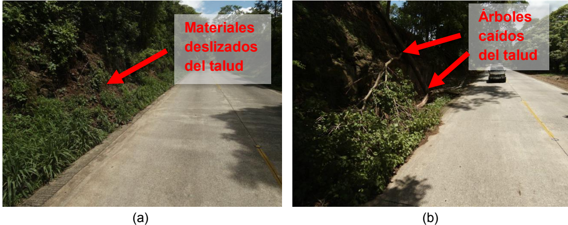
Figura 28: Deslizamientos de material y vegetación en taludes ubicados al lado de la superficie de ruedo
