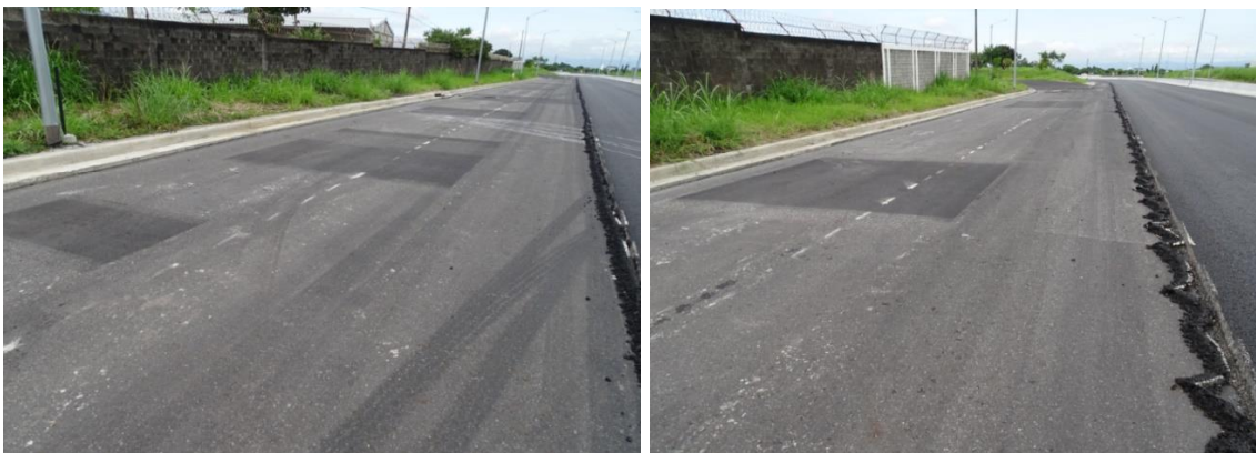
Figura 13. Bacheos realizados en zonas afectadas por el almacenamiento de vigas. Se nota que ya se colocó parte de la capa final de rueda en carriles interno e intermedio. Unidad Funcional 2B. Estacionamiento 1+550 a 1+650. Fecha: 8 de octubre de 2021. Fuente: LanammeUCR.
