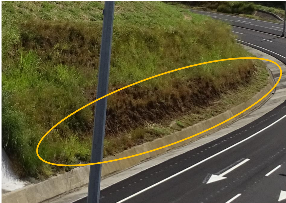
Figura 15. Zona medianamente afectada por erosión por falta de desarrollo de vegetación en la Radial Heredia, lado Este en Unidad Funcional 2B. Fecha: 16 de diciembre de 2021. Fuente: LanammeUCR.
