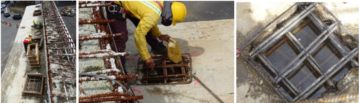
Figura 9. Actividad de limpieza de acero de los apoyos del bastión Sur. Unidad Funcional 1. Fecha: 4 de noviembre de 2021. Fuente: LanammeUCR.
