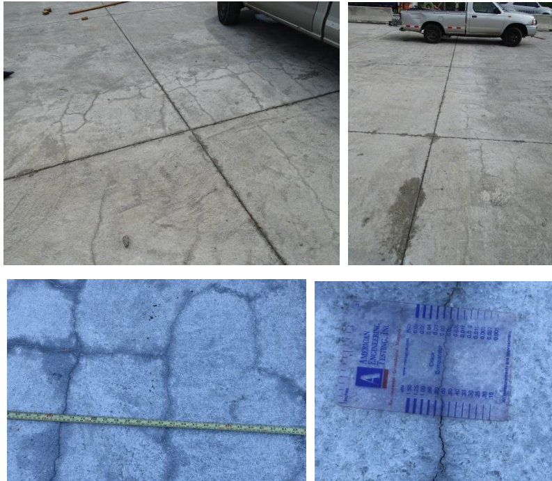
Figura 2. Condición de agrietamiento de losa 1 (lado del bastión Oeste) en el Puente sobre Quebrada Rivera. UF 2A. Fecha: 20 de agosto de 2021. Fuente: Nota informe LM-IC-D-728-2021, LanammeUCR.
