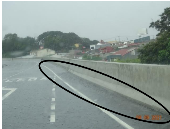
Figura 35. Área encharcada en el espaldón entre las Pilas 34 y 35. Fecha: 8 de setiembre de 2021.
