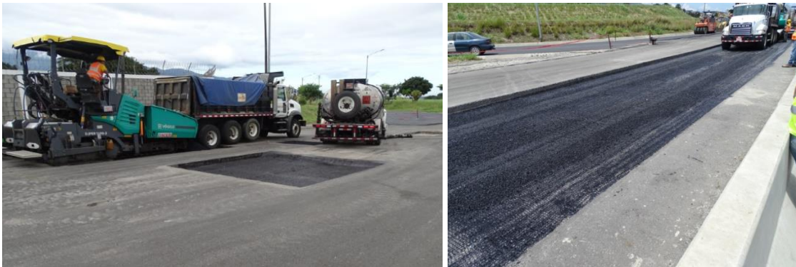
Figura 13. Bacheos realizados en zonas afectadas por el almacenamiento de vigas. Se nota que ya se colocó parte de la capa final de rueda en carriles interno e intermedio. Unidad Funcional 2B. Estacionamiento 1+550 a 1+650. Fecha: 8 de octubre de 2021. Fuente: LanammeUCR.
