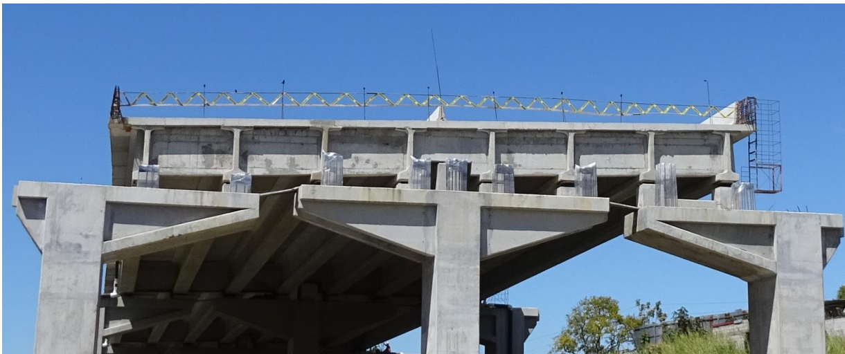
Figura 10. Protección de acero de apoyos de pila 49. Unidad Funcional 4. Fecha: 3 de febrero de 2022. Fuente: LanammeUCR
