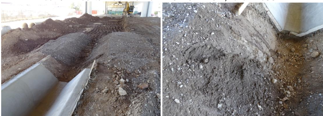
Figura 23. Apoyo de cunetas con material suelto. Cerca de pila 2 de UF3. Fecha: 10 de febrero de 2021. Fuente: Nota Informe LM-IC-D-0127-2021, LanammeUCR.
