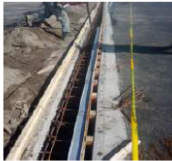
Ilustración 2. Registro Fotográfico limpieza de acero
