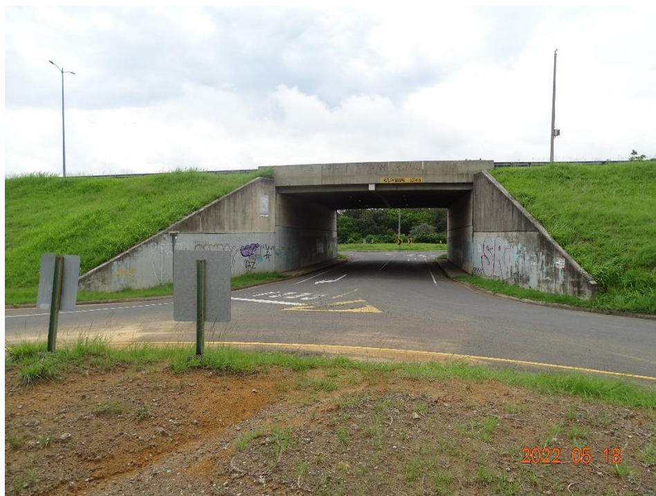
Figura 4.3. Vista lateral del costado sur del puente
