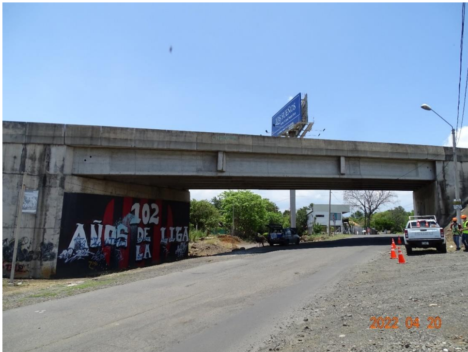
Figura 4.3. Vista lateral del costado sur del puente
