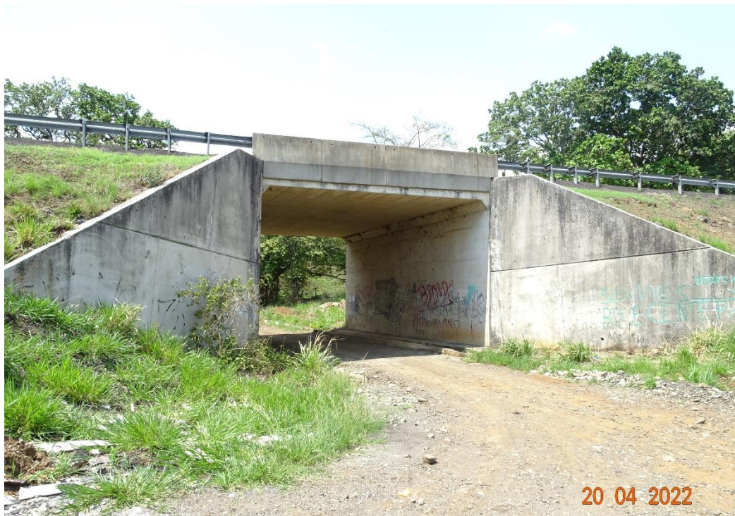
Figura 4.3. Vista lateral del costado sur del puente
