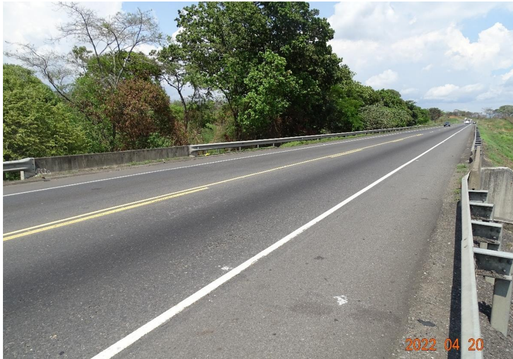
Figura 4.2. Vista a lo largo de la línea de centro del puente hacia San José
