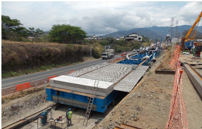
Puente sobre Río Virilla – Ruta Nacional 147
