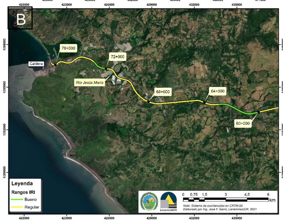
Figura 8. Ubicación de tramos con un IRI entre moderado y bajo. A) sentido San José - Caldera, B) sentido Caldera - San José
