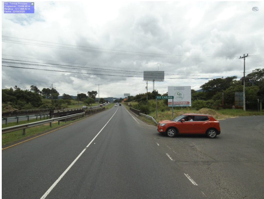
Figura 140. Accesos inseguros a Ruta Nacional 27, aldeaño al puente sobre el río Caraña
