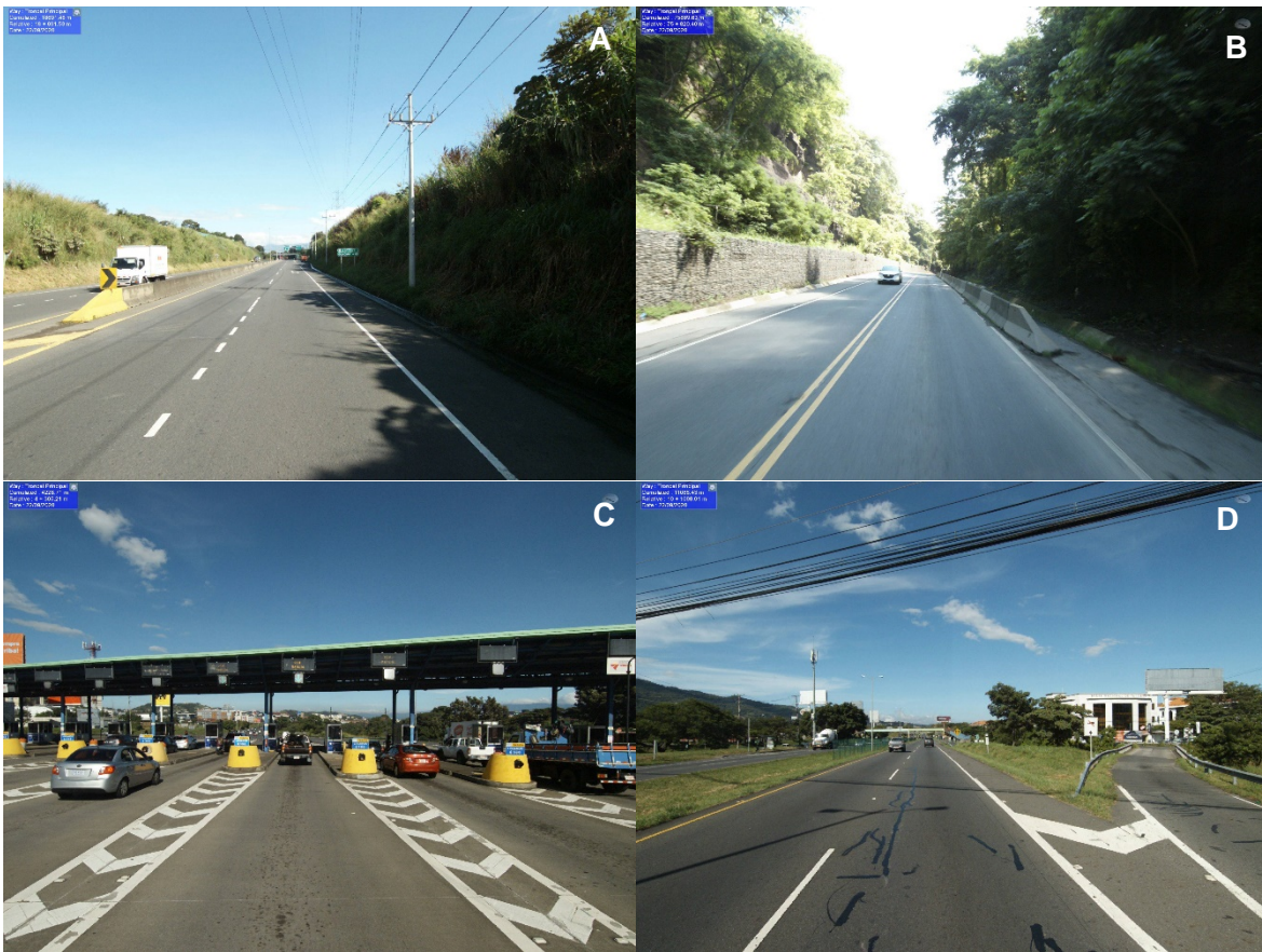
Figura 103. Deficiencias críticas a nivel de terminales: inicio de barrera medianera (A), inicio de barrera lateral (B), zona de peaje (C) y rampa de salida (D)
