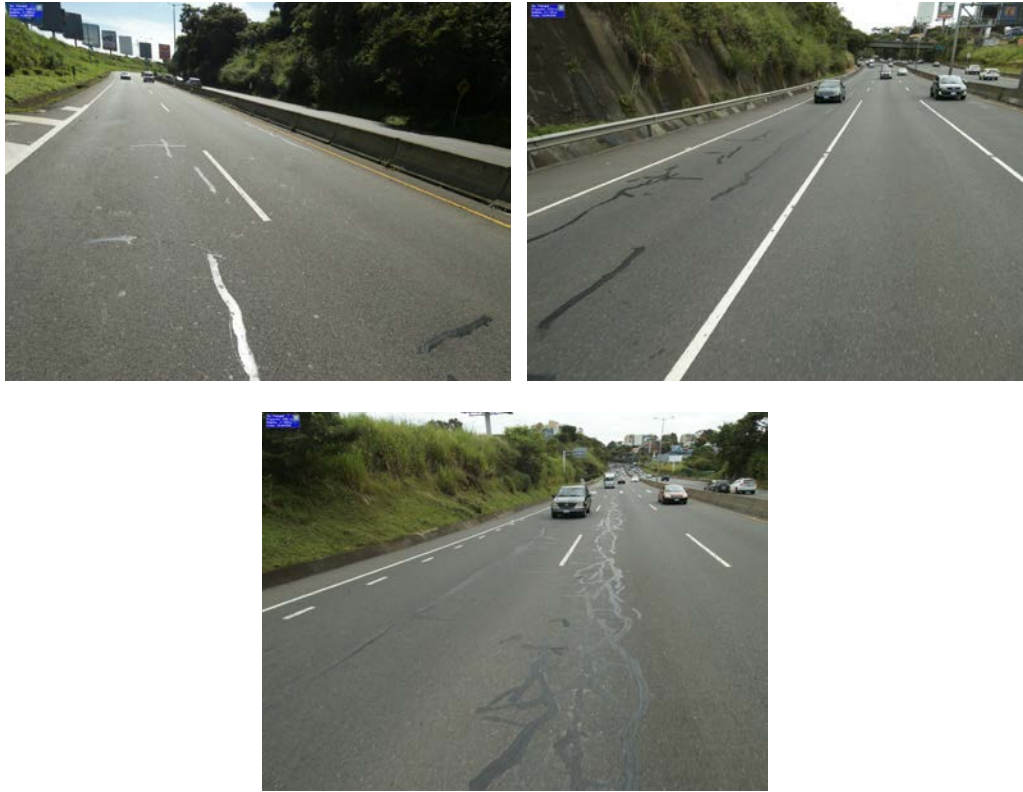
Figura 29. Sellos de grietas
