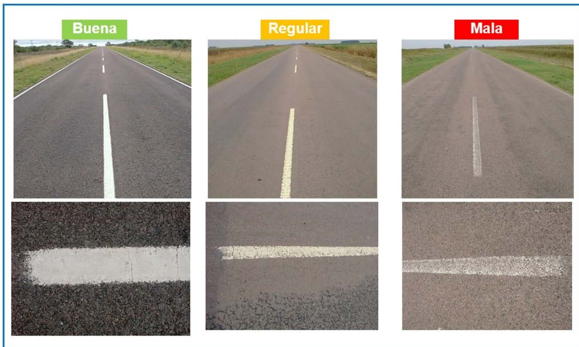
Figura 75. Clasificación visual en función del estado de la demarcación horizontal
