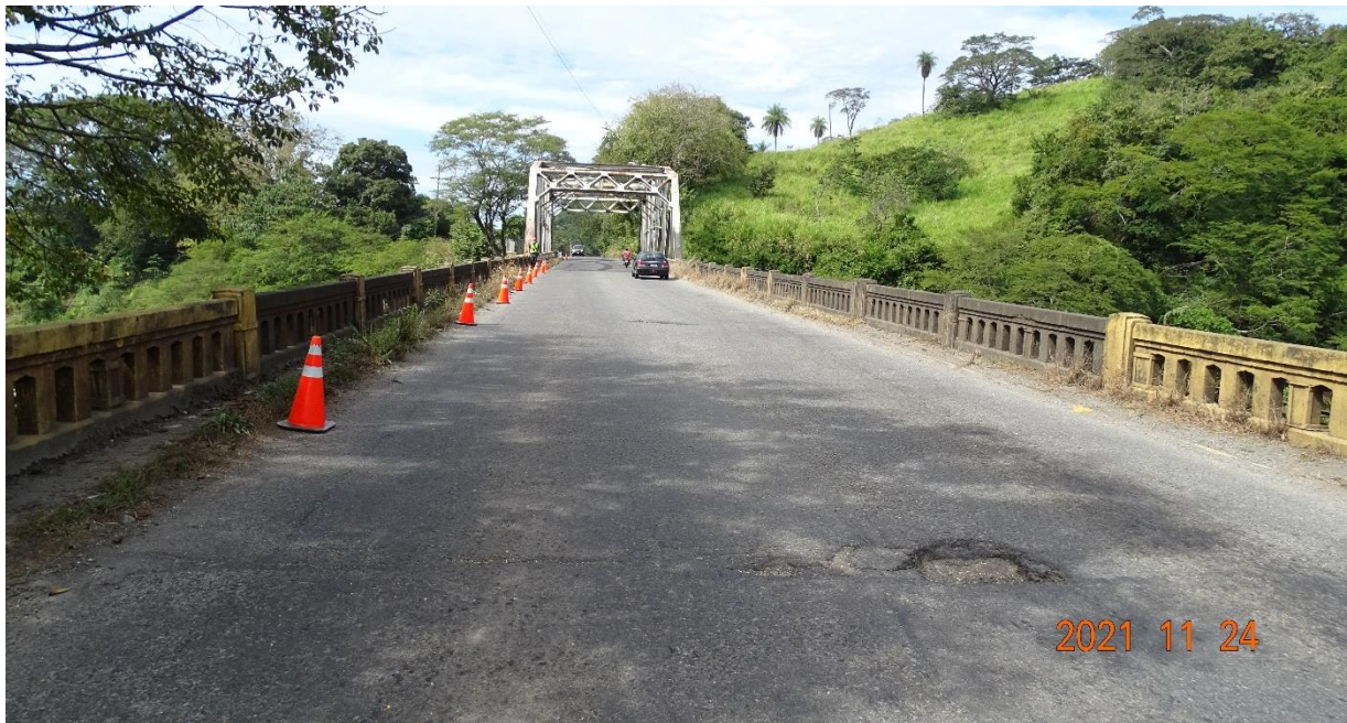
Figura 4.2. Vista a lo largo de la línea de centro del puente hacia distrito de Barranca.
