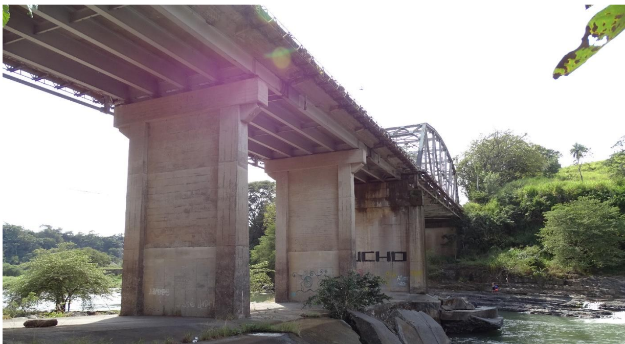
Figura 4.3. Vista lateral del costado aguas arriba del puente.
