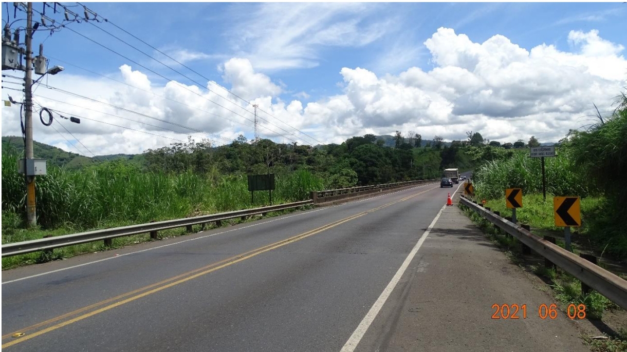
Figura 4.2. Vista a lo largo de la línea de centro del puente hacia San Ramón
