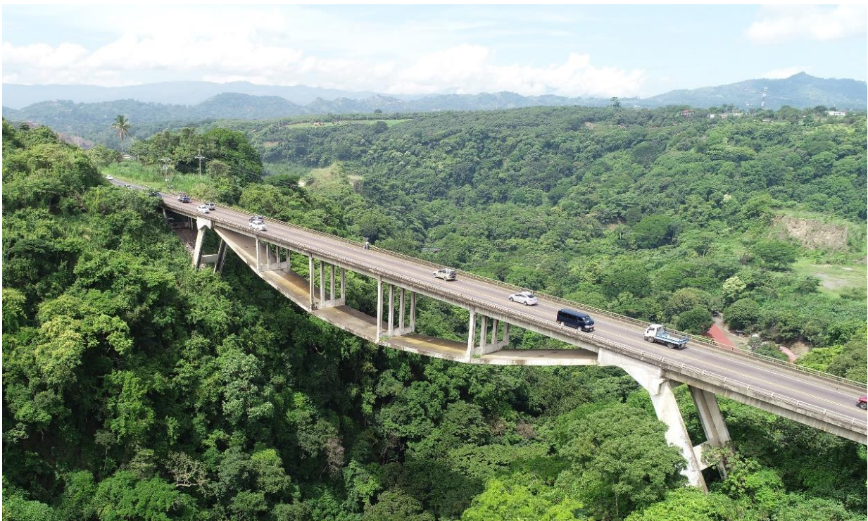
Figura 4.3. Vista lateral del costado aguas arriba del puente
