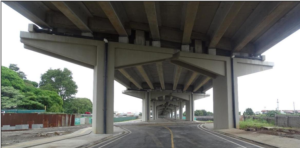
**Figura 22.** Pilas sesgadas del viaducto de Circunvalación Norte.
