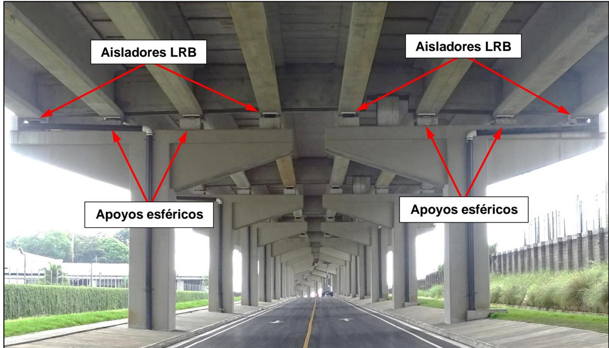
**Figura 10.** Tipos de apoyo que se utilizan en las pilas del viaducto.
