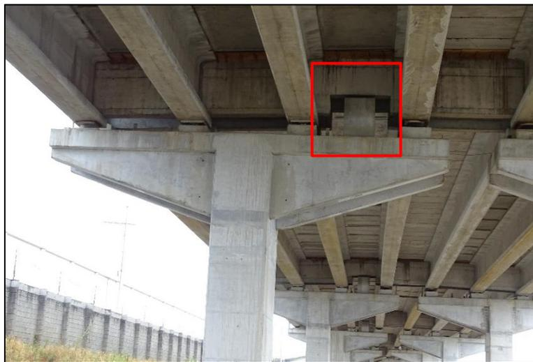
Figura 12. Llave de cortante construida en las pilas del viaducto.
