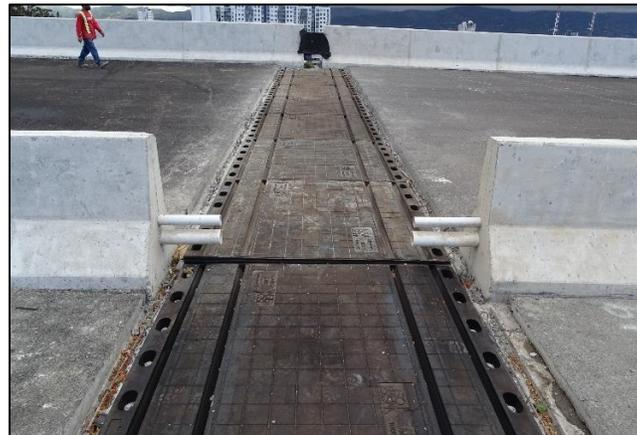
**Figura 6.** Junta de expansión elastomérica modular colocada en el viaducto.
