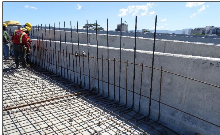
Figura 13. Arranques del acero de refuerzo colocados al lado de la barrera vehicular existente.
