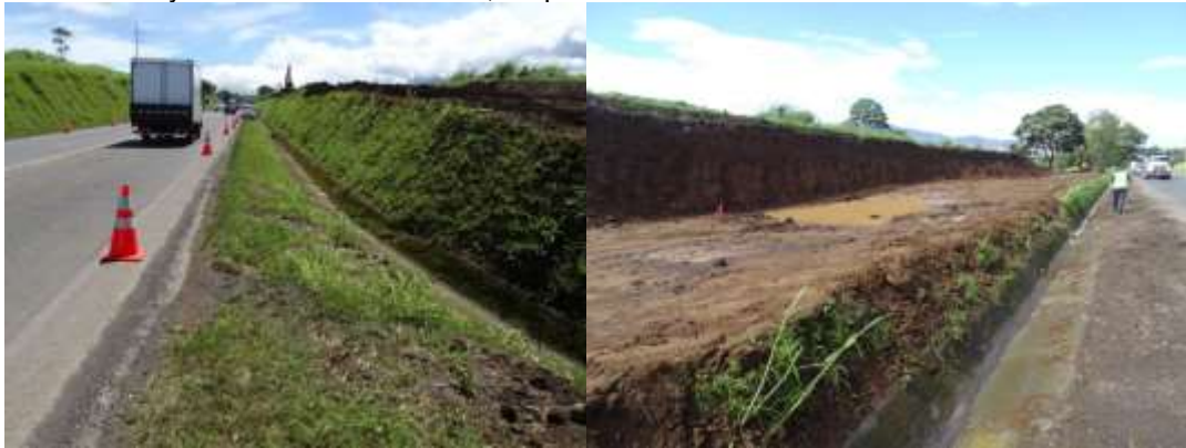
Figura 17. Inicio de movimiento de tierras. Sector Cruce Santo Tomás – Cruce RN117 (Rest. Doña Lela). Fechas: 10 de set y 15 de octubre de 2020, respectivamente. Fuente: LanammeUCR.
