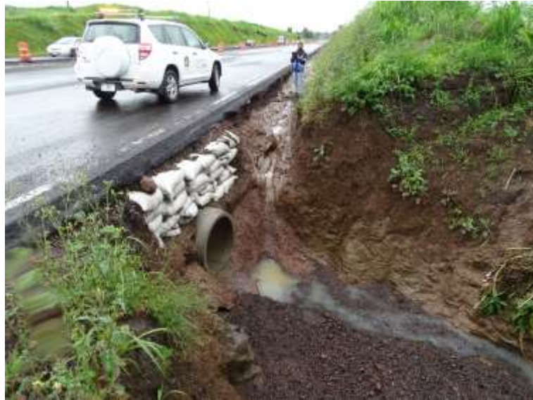
Figura 10. Ausencia de cabezales y cunetas que generan erosión y socavación en la margen lateral de la calzada. Además, representa un riesgo a la seguridad vial de los usuarios. Estacionamiento 1+150, sin embargo, esta condición es generalizada hasta el estacionamiento 2+360. Fecha: 23 de julio de 2021. Fuente LanammeUCR.
