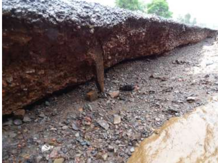
Figura 14. Socavación de la estructura de pavimento- Se observa la separación entre capas de base estabilizada y subbase granular, estacionamiento 1+660. Fecha: 23 de julio de 2021. Fuente LanammeUCR.
