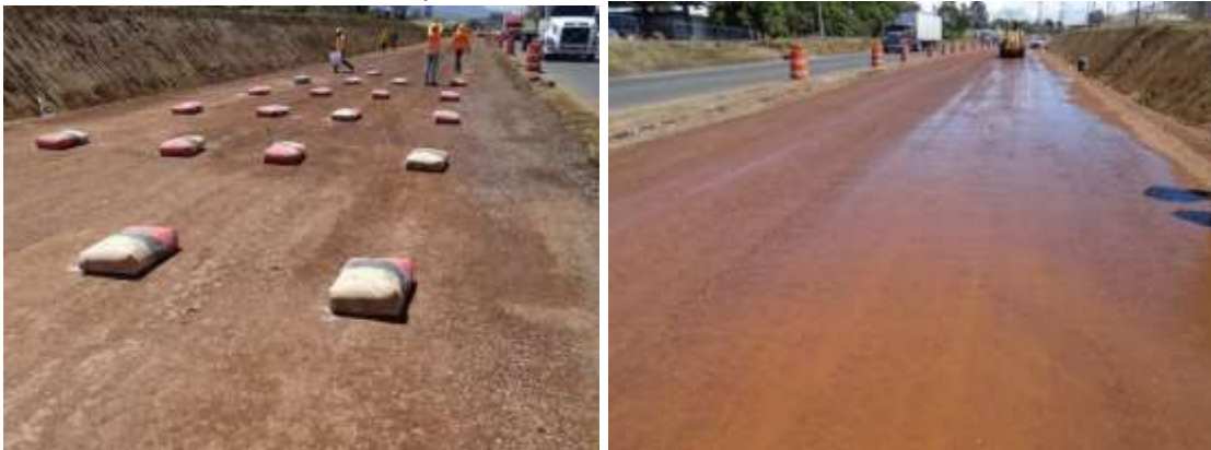
Figura 19. Tramo en proceso de estabilización con cemento. 600m Suroeste del cruce con Ruta 117. Fechas: 10 febrero de 2021. Ampliación Sur de la vía. Fuente: LanammeUCR.
