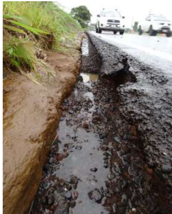
Figura 12. Ausencia de cunetas, que propició socavación y pérdidas de material de las capas granulares subyacentes del pavimento, estacionamiento 1+310. Fecha: 23 de julio de 2021. Fuente LanammeUCR.
