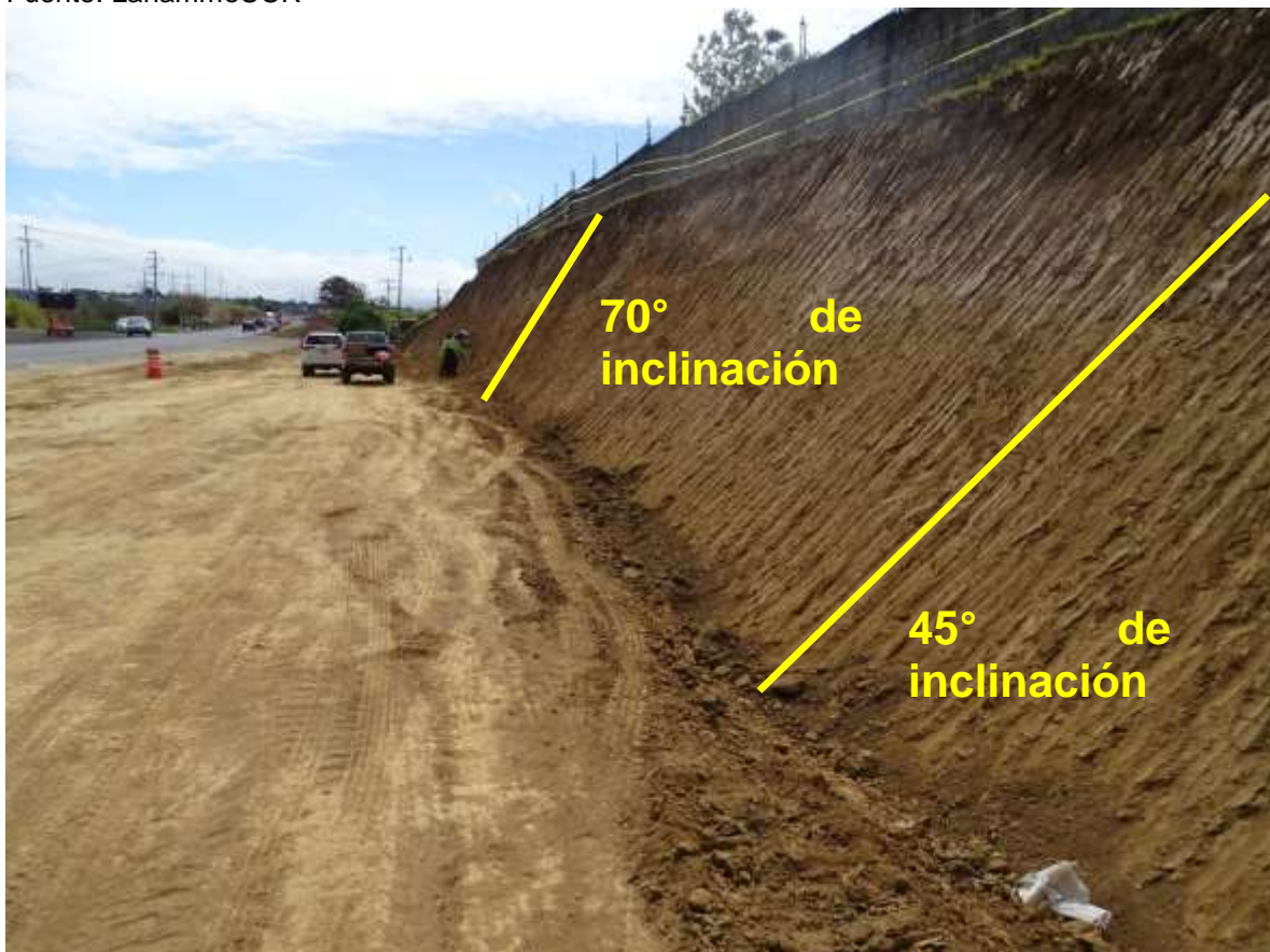
Figura 25. Se observaron distintas inclinaciones para el talud no revestido. Fecha: 7 de abril de 2021. Fuente: LanammeUCR
