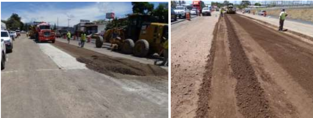
Figura 20. Tramo en proceso de estabilización con cemento. 100m Oeste del cruce con Ruta 117, Frente a Restaurante Doña Lela. Carriles centrales. Fecha: 3 marzo de 2021. Fuente: LanammeUCR.
