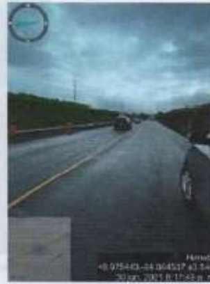
Figura No. 2 Estado de la vía
