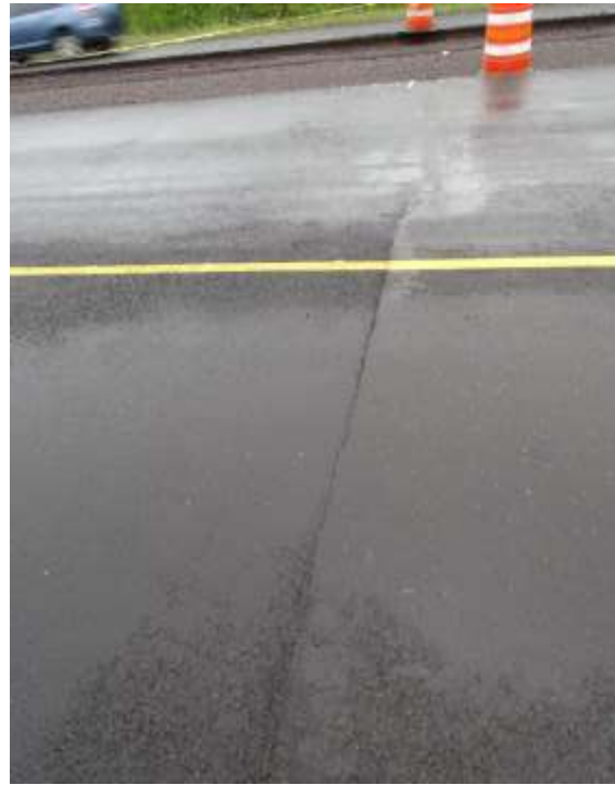
Figura 9. Agrietamiento transversal en junta de construcción de mezcla asfáltica, estacionamiento 1+260. Fecha: 23 de julio de 2021. Fuente LanammeUCR.
