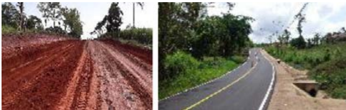
Figura 17. Proyecto finalizado de mejoramiento de calles – Colocación de Tratamientos superficiales, Cantón de Los Chiles, Alajuela 2-14-017
