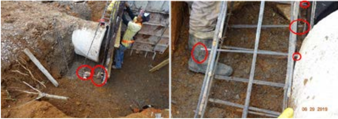
Figura 21. Incumplimiento en las prácticas constructivas y desempeño: agregados, piedras y varillas como separadores para revestimiento
