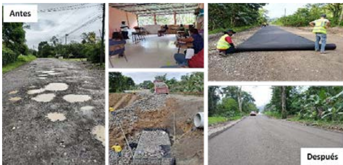
Figura 14. Proyecto de mejoramiento Talamanca, C.7-04-019-000
