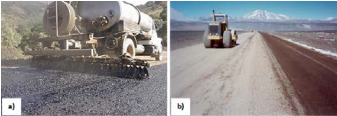
Figura 1. Experiencias previas a la creación del Programa Caminos Básicos. a) Imprimación reforzada año 1995 b) Estabilización con sales.
