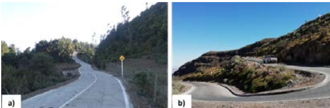
Figura 2. Casos especiales para caminos básicos de conservación. a) Pendientes mayores a 9 % b) Radios de curvas menores o iguales a 20 m
