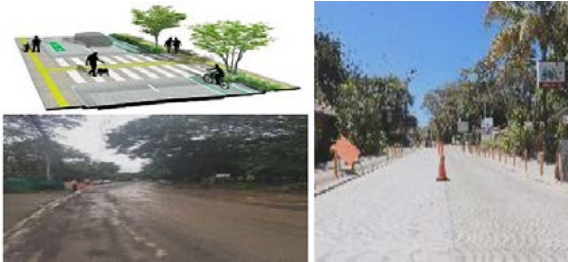
Figura 15. Proyecto de rehabilitación y mejoramiento de calles completa en losas de concreto, Cantón de Santa Cruz, Guanacaste 5-03-257
