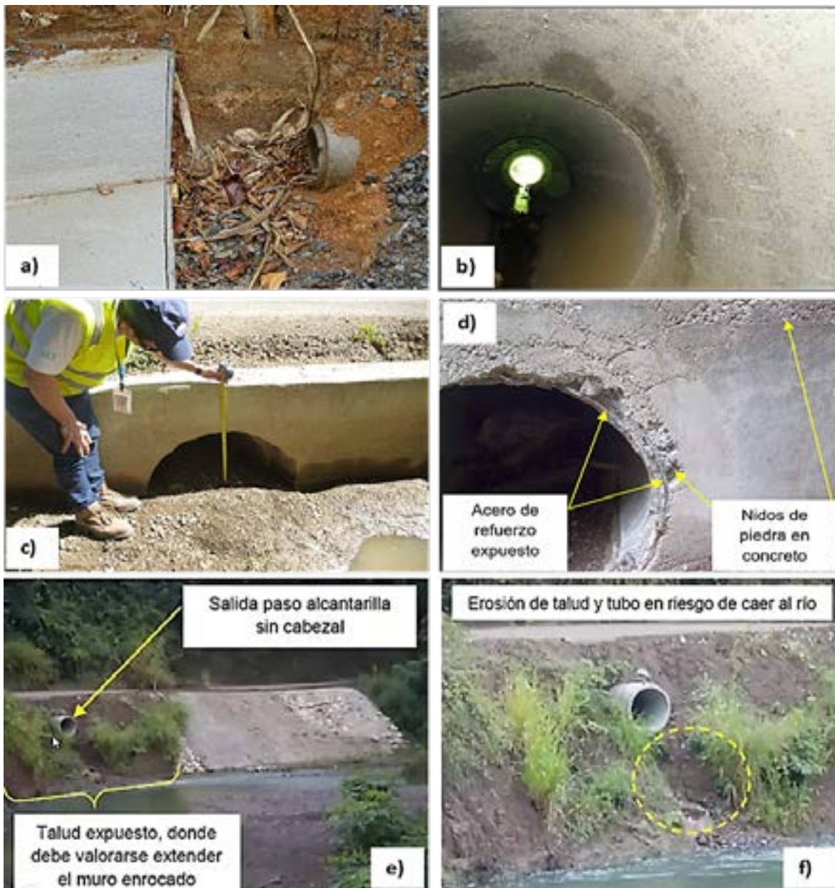
Figura 22. Problemas con el sistema de drenaje: a) Material de secado acumulado en alcantarillas, b) Mal nivel y falta de mortero para juntas de tuberías, c) Drenajes obstruidos durante la ejecución del proyecto, d) Nidos de piedra en concreto y acero de refuerzo expuesto, e) Salida para alcantarilla sin cabezal y taludes expuestos, f) Erosión de talud y tubo en riesgo de caer al río caídas a cuerpos de agua
