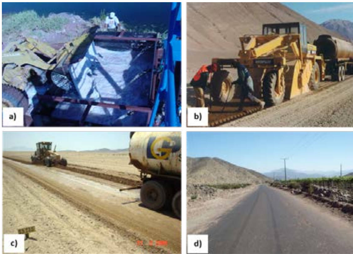
Figura 3. Estabilización de caminos con cloruro de magnesio hexahidratado.
