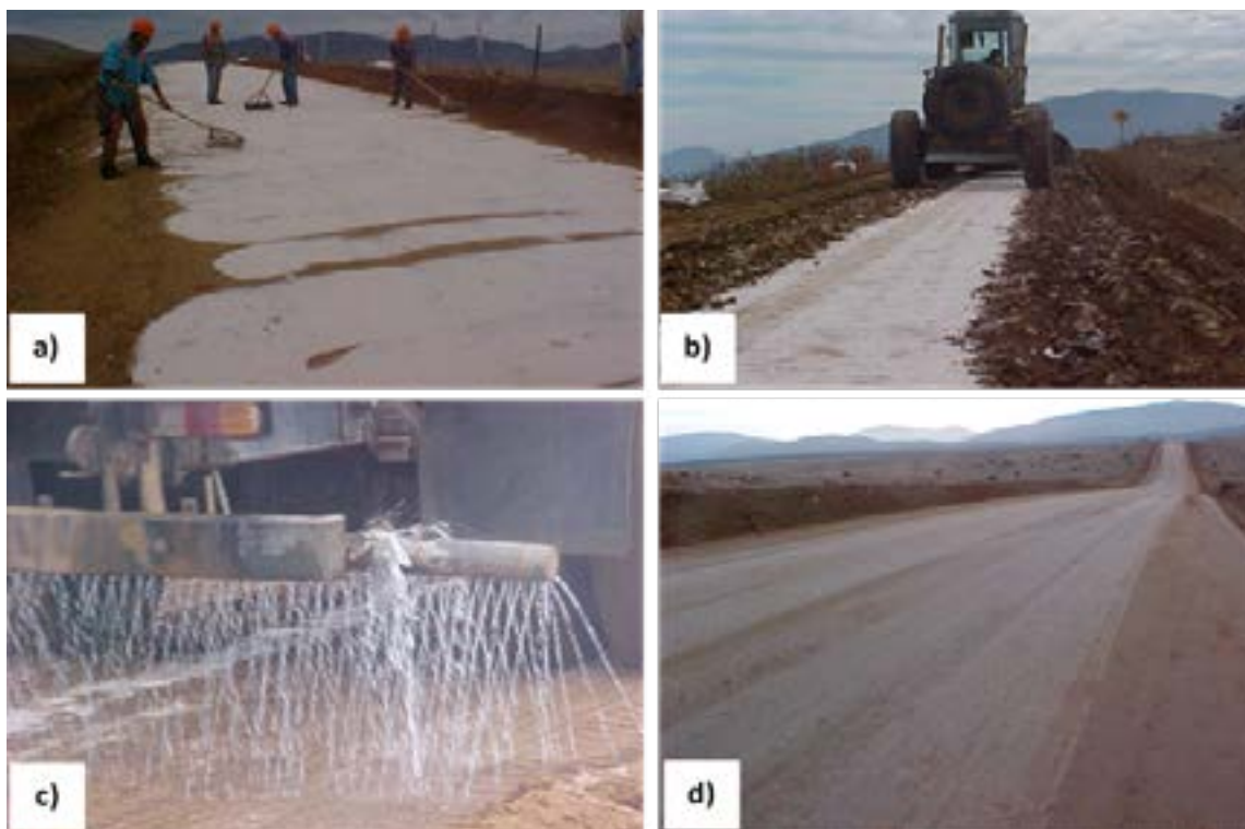
Figura 4. Estabilización de caminos con Cloruro de Sodio (Sal común).
