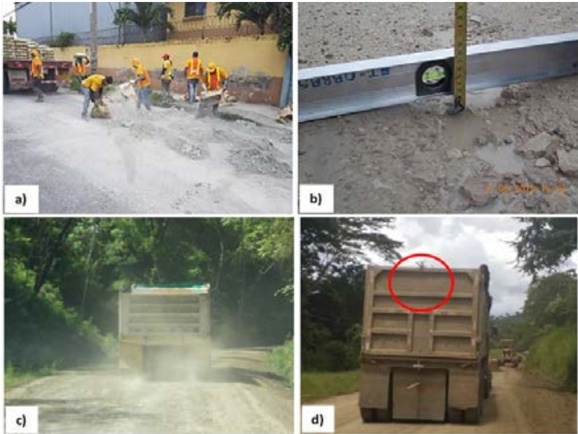
Figura 20. Incumplimiento en las prácticas constructivas y desempeño. a) Generación de polvo por lanzamiento de bolsas de cemento, b) Deterioros prematuros por la circulación de maquinarias en trabajos recién realizados, c) y d) Vagonetas sin lona de protección-exposición del material a contaminarse
