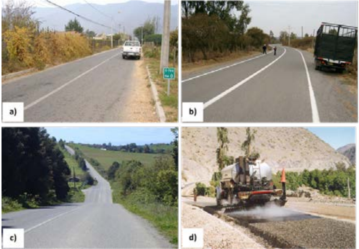
Figura 5. Soluciones utilizadas con capas asfálticas. a) Lechada Asfáltica. b) Tratamiento superficial simple. c) Doble tratamiento superficial. d) Cape Seal
