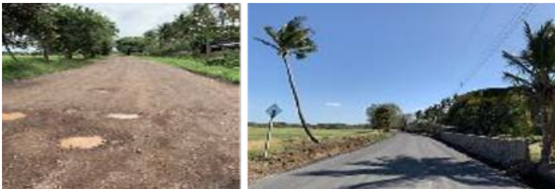
Figura 16. Proyecto finalizado de mejoramiento de calles – Colocación de Tratamientos superficiales, Cantón de Cañas, Guanacaste CS-06-011
