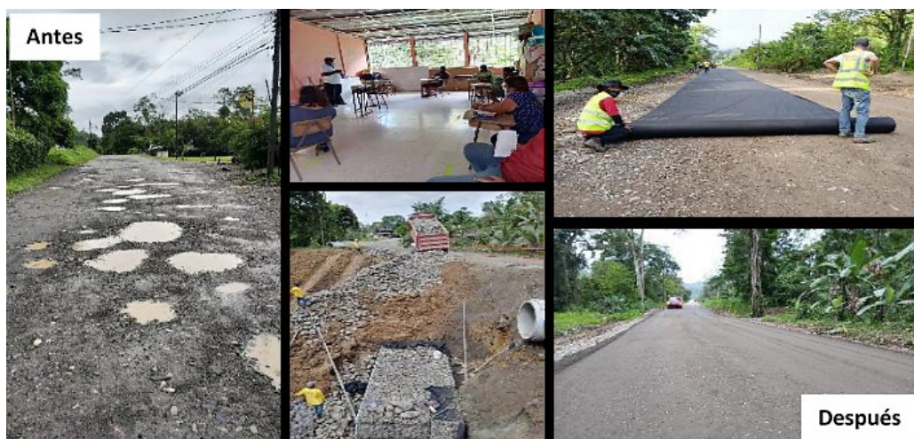
Figura 2. Proyecto de mejoramiento Talamanca, C.7-04-019-000
