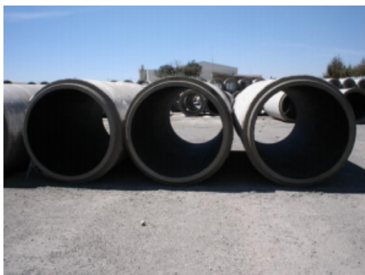
Figura 16. Forma correcta de almacenar los tubos Fuente: ATCO, 2012
