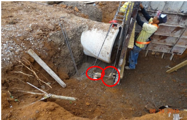
Figura 22. Utilización de piedras como separación entre armadura y suelo Fuente: LanammeUCR, 2019
