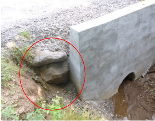
Figura 23. Construcción de cabezales sin aletones Fuente: LanammeUCR, 2016
