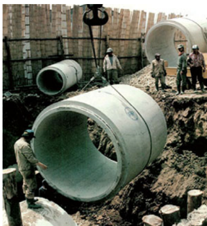
Figura 15. Correcta descarga de tubería Fuente: IMCYC, 2009
