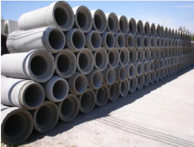
Figura 17. Tubería apilada de forma apropiada (para diámetros nominales entre 30 y 40 cm) Fuente: ATCO, 2012
