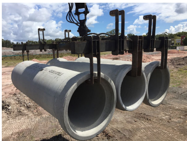
Figura 5. Descarga apropiada de tubería con multihorquilla Fuente: Precision Pipe Lifter, 2017.
