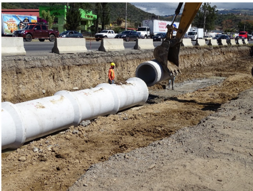
Figura 9. Maquinaria de descenso de tubos a la zanja.
