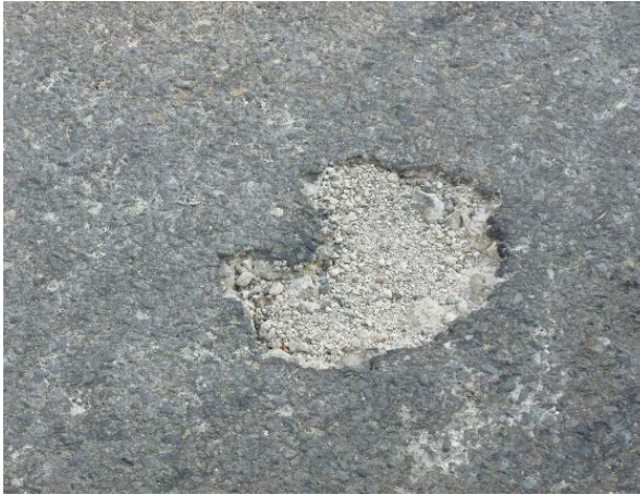
Figura 2 Consecuencias del daño por humedad en mezclas asfálticas a) desmoronamiento y b) desnudamiento
