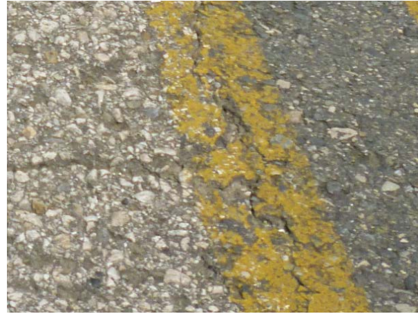
Figura 2 Consecuencias del daño por humedad en mezclas asfálticas a) desmoronamiento y b) desnudamiento
