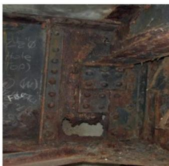
SEVERIDAD 4: Agujero en la sección ocasionado por la corrosión
