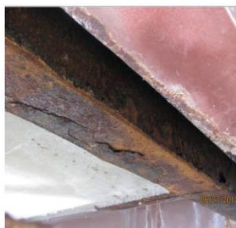
SEVERIDAD 3: Se observa corrosión con pérdida de sección
