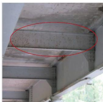
SEVERIDAD 2: Se observan puntos de oxidación en un elemento
